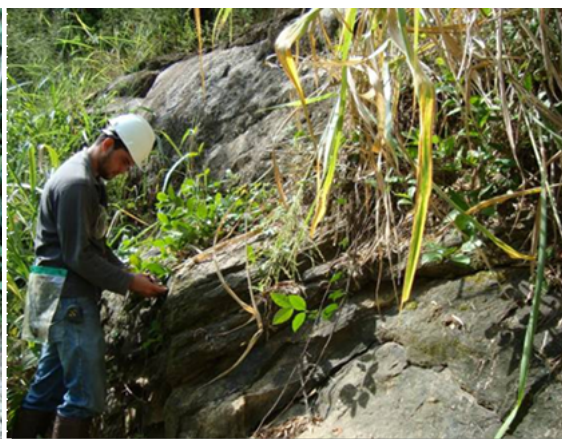
Figura 5.1-90 - Granito pouco fraturado superficialmente passando a rocha sã não fraturada.
