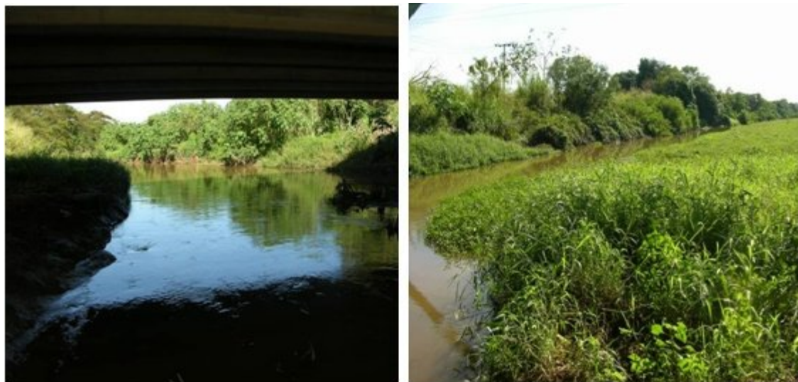
Figura 5.1-144 - Canal do Guandu, no cruzamento com a BR 101.
