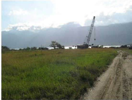
Figura 5.1-167 – Ponto 6 de medição de ruído de fundo
