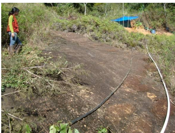
Figura 5.1-91 - Vista do emboque norte, onde se observa floramentos de rocha sã e maciça.
