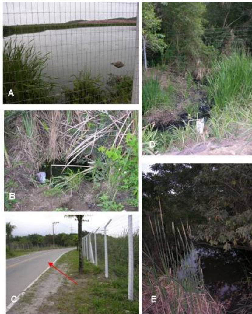
Figura 5.1-133 - Dreno do lago de decantação da Ingá: na foto A lago, na foto B saída do dreno; na foto C sentido da canalização sob a estrada de acesso à Ingá e à Ilha da Madeira; na foto D canalização do outro lado da estrada, e na foto E o deságue no mangue do Cação.
