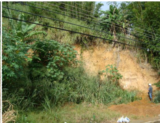
Figura 5.1-88 - Solos coluvionares que ocorrem na porção norte da Ilha da Madeira, argilo-arenosos, avermelhado, com boa plasticidade, espessos e bem drenados.
