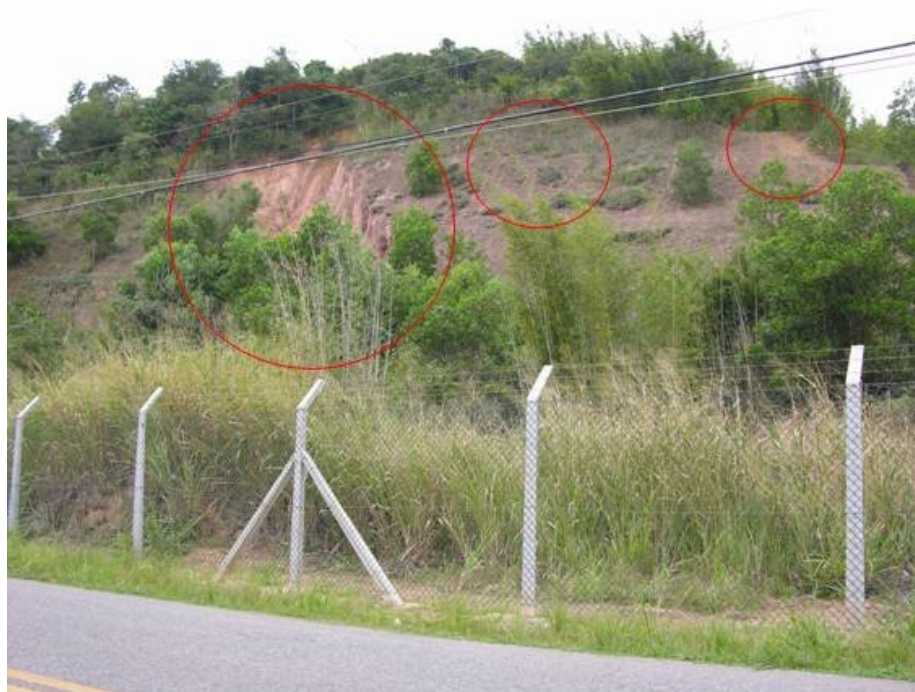
Figura 5.1-82 -Processos erosivos (principalmente laminares) em de corte da estrada.
