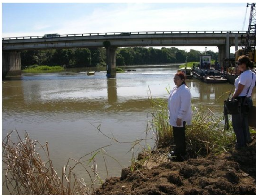
Figura 5.1-142 - Canal de São Francisco no cruzamento com a BR101.
