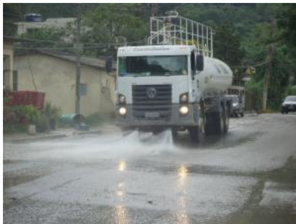
Figura 8 – Umectação das vias de acesso e canteiro de obras.
