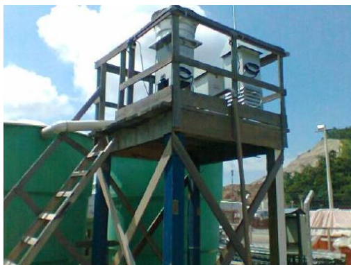
Figura 1 – EMQA1 instalada no Canteiro Norte
