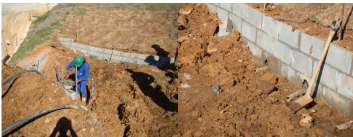
Figura 32 – Detalhe da construção dos muros de contenção com dutos de drenagem em Julho de 2012.
