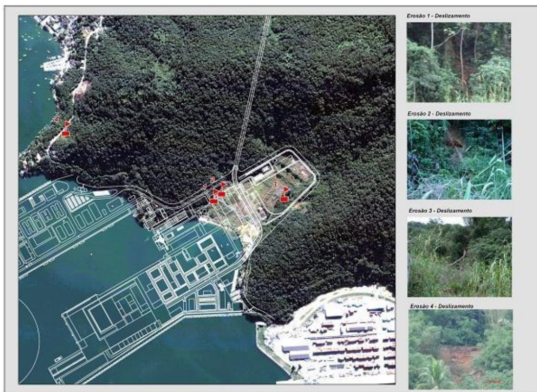
Figura 1 - Processos erosivos pré-existent.
