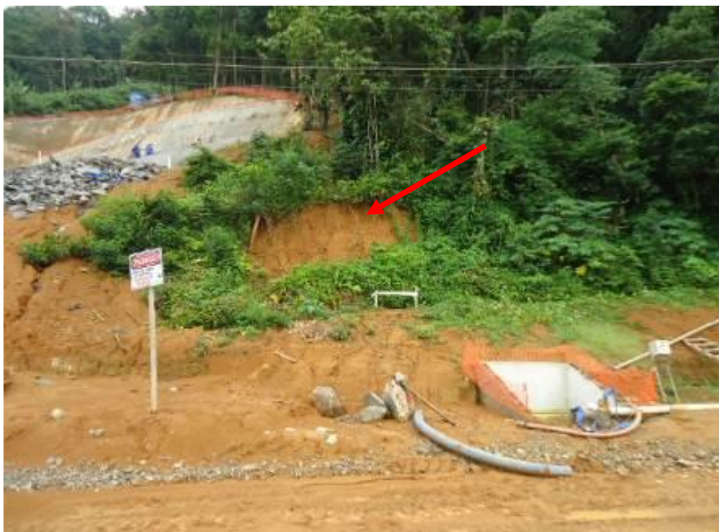
Figura 22 - Vista geral da área do deslizamento em Janeiro de 2012.
