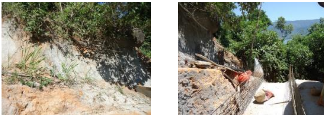
Figura 20 – Jateamento de concreto e construção de canaletas em Março de 2012.
