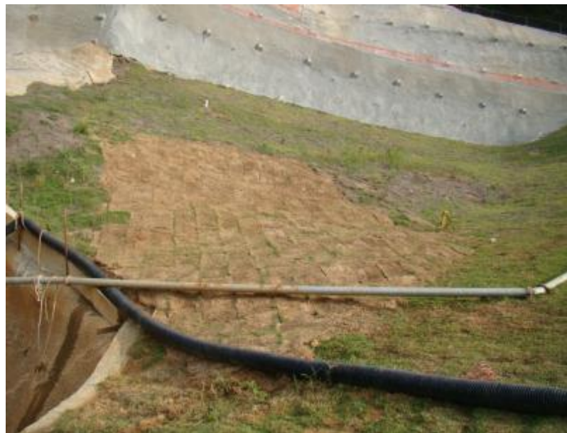
Figura 34 – Visão da Feição Erosiva mitigada com replantio de gramíneas em Agosto de 2012.
