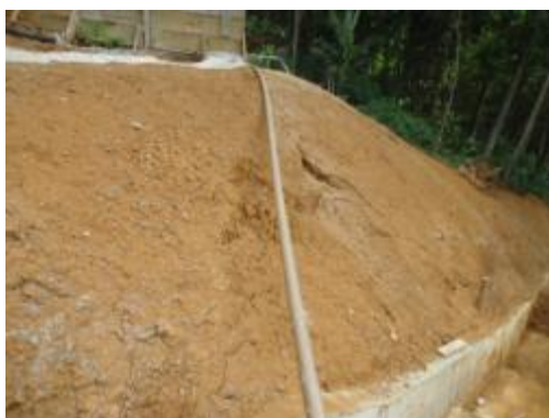
Figura 28 – Nivelamento do talude e construção de canaletas de concreto em Fevereiro de 2012.
