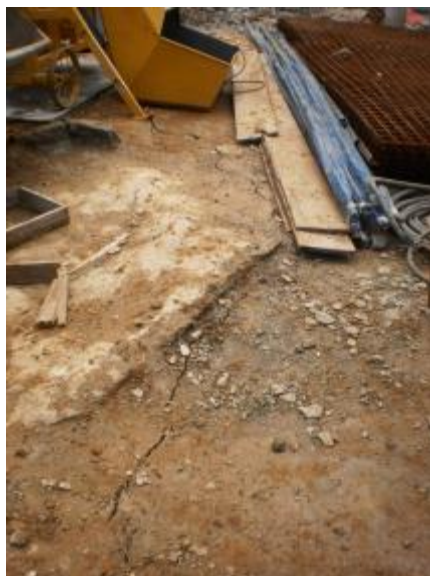
Figura 18 – Detalhe da Feição Erosiva 09 evidenciado por sulcos no platô do talude em Outubro de 2011.
