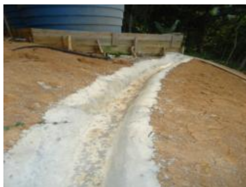
Figura 28 – Nivelamento do talude e construção de canaletas de concreto em Fevereiro de 2012.
