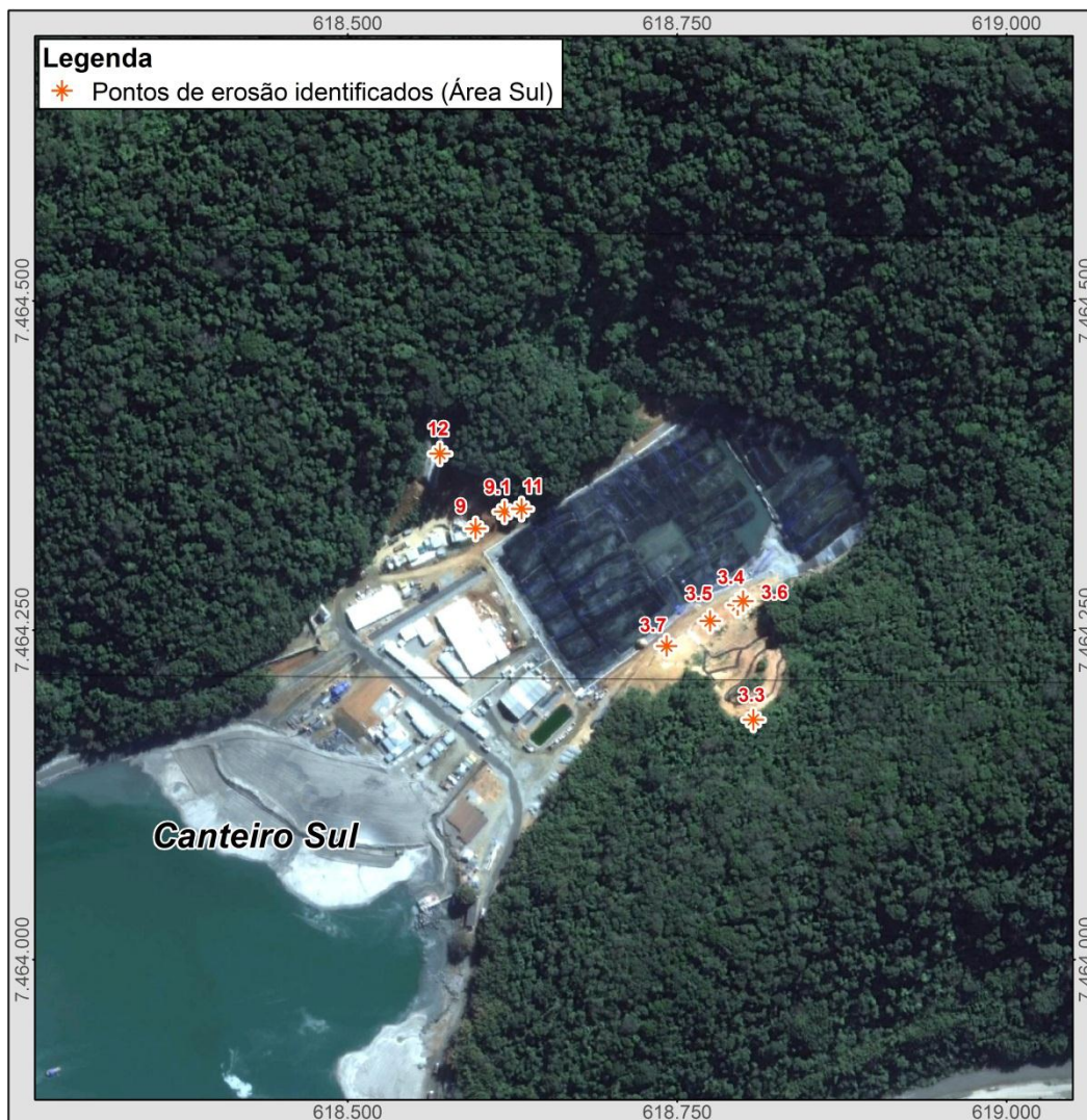
Figura 16 – Processos erosivos identificados no Canteiro Sul entre os meses de Outubro/2011 e Setembro/2012.
