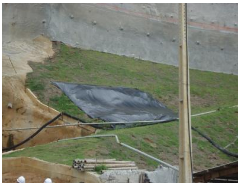
Figura 31 - Mitigação da feição com manta PEAD em Julho de 2012.
