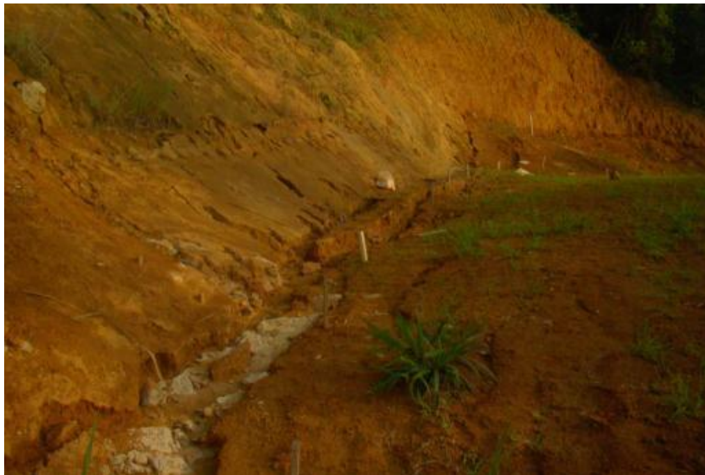
Figura 8 – Após intensas chuvas, em maio de 2012, foi verificado um aumento das fendas no solo.
