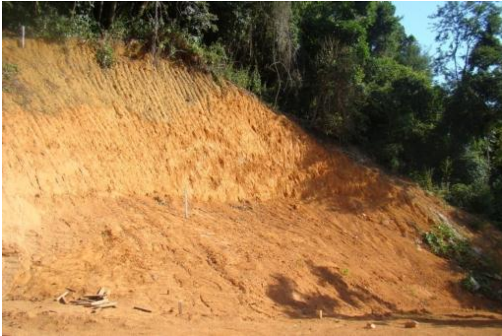
Figura 7 - Visão geral da feição após ações do nivelamento do talude em Abril de 2012.
