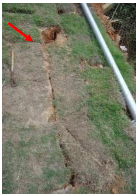
Figura 35 – Detalhe da rachadura no solo e equipes realizando o monitoramento com medição da Feição Erosiva 14 em Julho de 2012.
