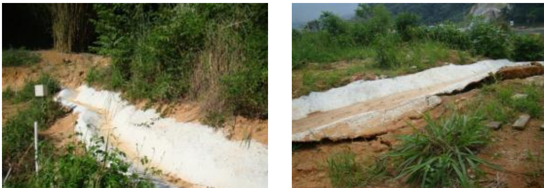
Figura 5 - Visão das Canaletas de concreto construídas no talude em Julho de 2012
