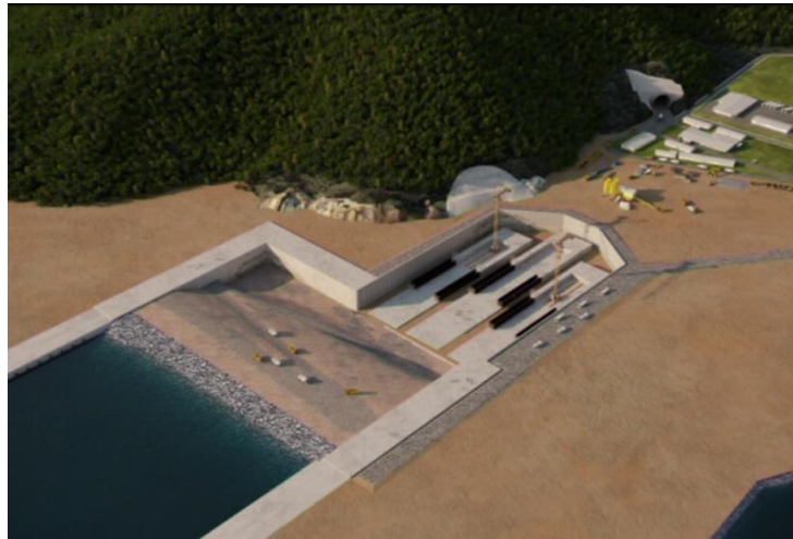
Figura 2 – Simulação da etapa de instalação das docas secas
