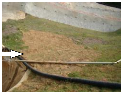
Figura 44 – Mitigação do processo erosivo, com construção de muro de arrimo e replantio de gramíneas.
