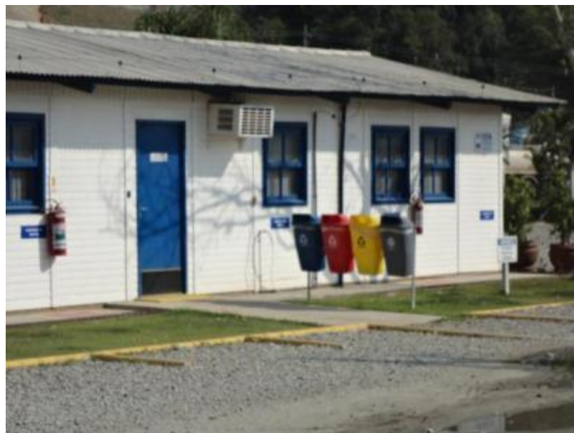
Figura 31 – Coletores específicos dispostos na área administrativa do canteiro.
