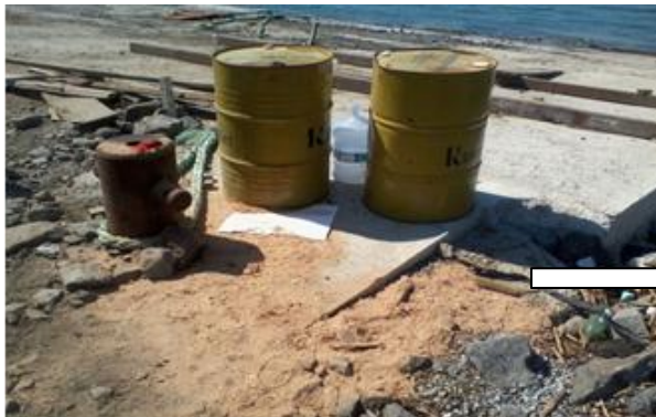
Figura 37 – Armazenamento Inadequado de Produtos Químicos (Tambores de 200 litros de Aditivo)
