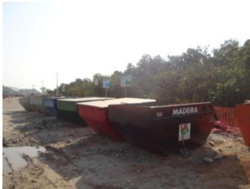
Figura 32 - Caçambas de coleta de resíduos dispostas no canteiro.
