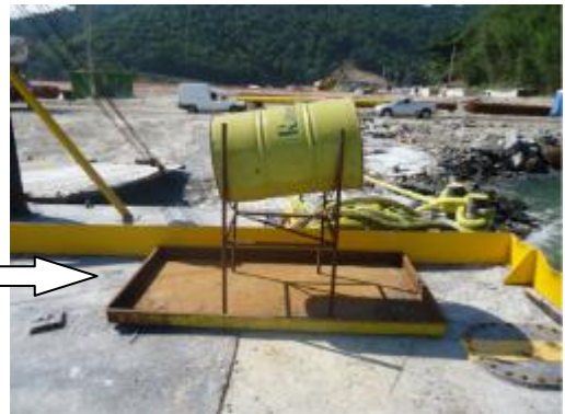
Figura 38 – Tambor armazenado em Local adequado, com bandeja de contenção.
