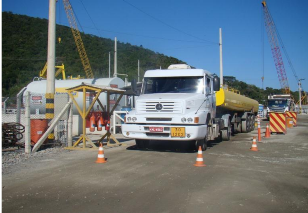
Figura 14 – Área de abastecimento devidamente isolada durante a operação.
