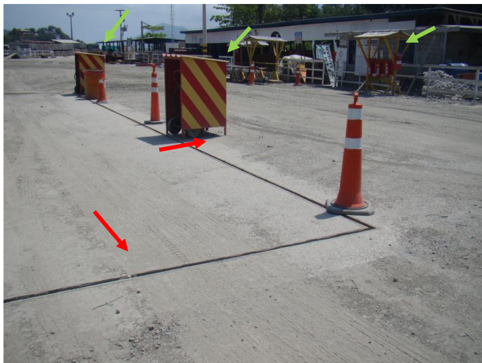
Figura 13 – Destacam-se em vermelho a rede de drenagem dedicada para encaminhando o efluente para o Separador de Água e Óleo e em verde os extintores de incêndio.
