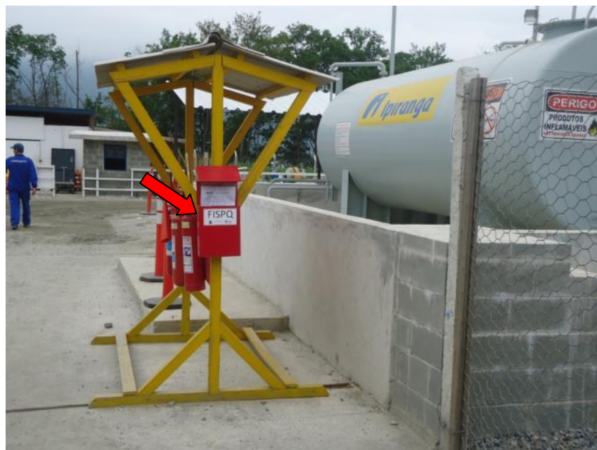
Figura 8 - FISPQ afixada próxima ao posto de abastecimento no canteiro norte.
