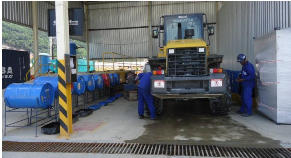
Figura 15 – Área de manutenção de equipamentos com rede de drenagem dedicada.
