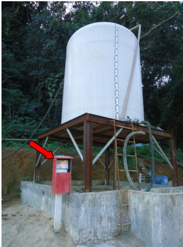
Figura 7 - FISPQ afixada próximo ao local de utilização de produto químico ( Canteiro Sul - tunel).
