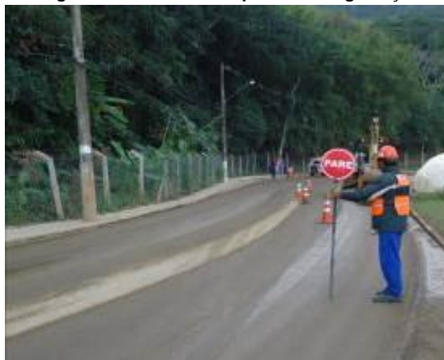
Figura 19 – Bloqueio de via em momento de movimentação de carga pesada.
