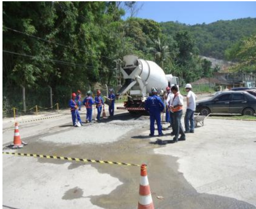
Figura 14–Conservação asfáltica nas vias de acesso.
