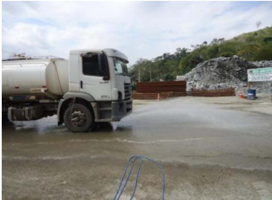
Figura 9 – Umectação no Canteiro de Obras.
