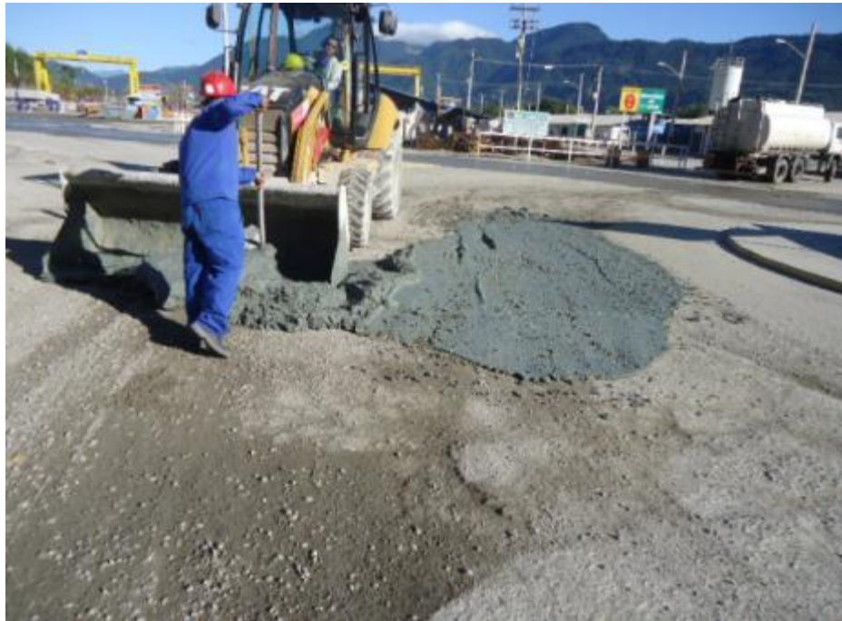
Figura 10 – Conservação asfáltica das vias internas do canteiro.
