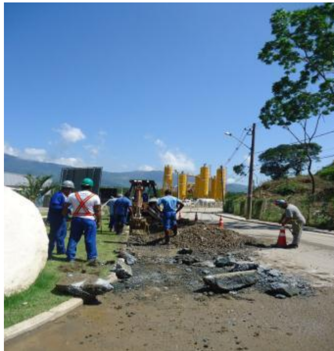
Figura 13 – Reparo nas vias da comunidade
