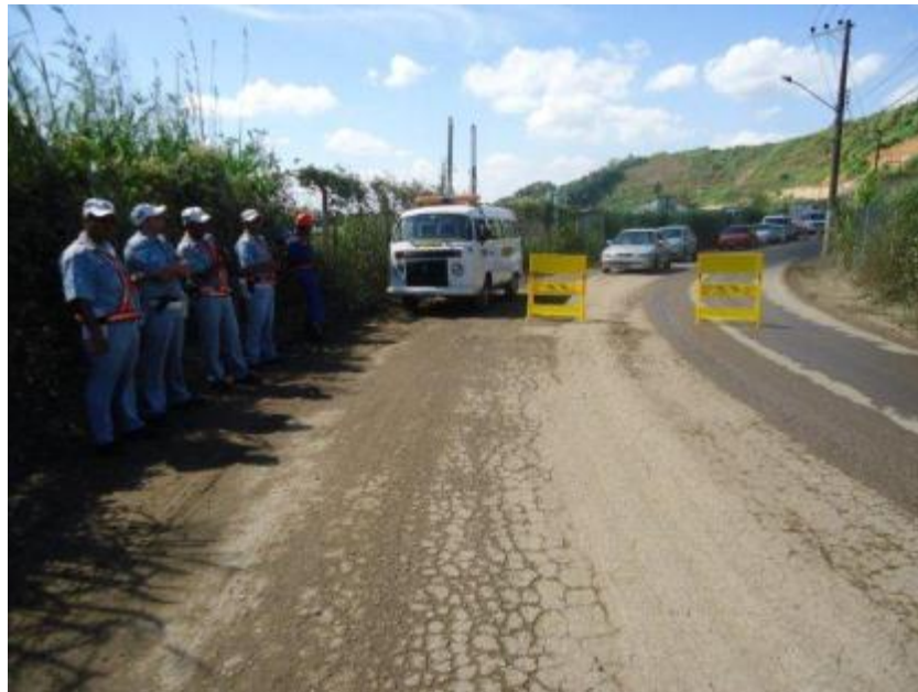
Figura 5 - Bloqueio da via no momento da detonação com o auxílio da autoridade de trânsito municipal.
