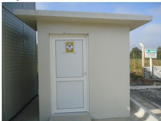
Figura 7 – Baía de armazenamento dos resíduos infectantes
