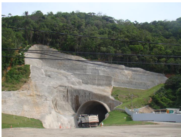
Figura 26 - Acesso e Táfeço de Veículos no Emboque Norte do Túnel. Setembro de 2012
