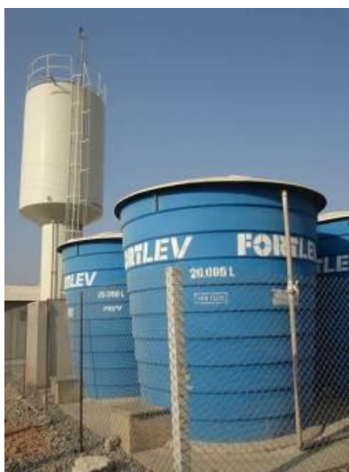
Figura 45 - Armazenamento de água para utilização nas atividades da obra.
