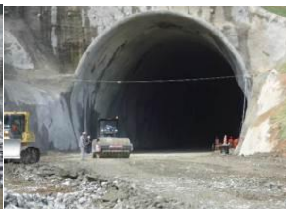
Figura 25 – Finalização dos acessos.
