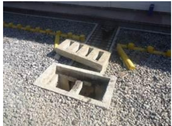
Figura 22 – Manutenção preventiva da rede de drenagem com retirada de lama
