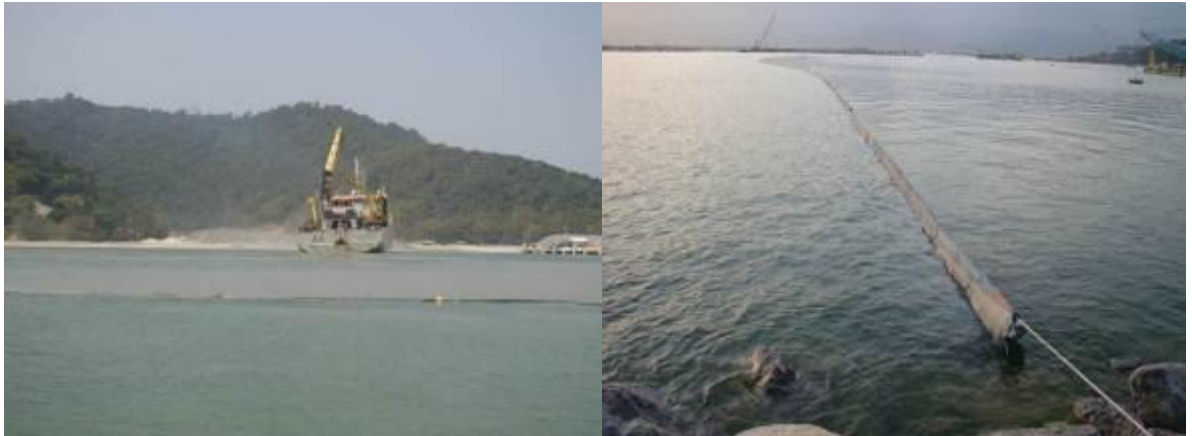
Figura 37 – Barreiras de Contenção posicionadas durante atividade de aterro por método Rainbow , campanha de setembro de 2012.
