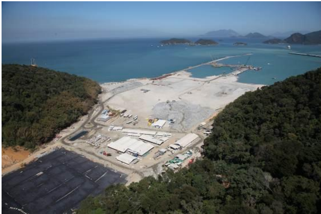
Figura 16 - Visão Aérea do Canteiro Sul em agosto de 2012.
