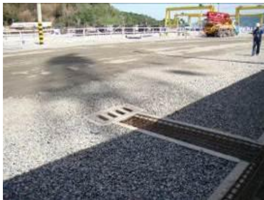
Figura 20 - Calha de drenagem instalada no canteiro Norte
