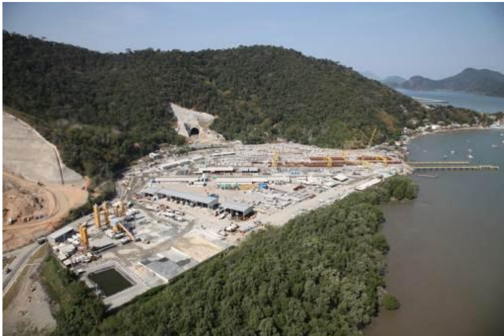
Figura 4 – Visão aérea do Canteiro Norte e Túnel em Setembro de 2012
