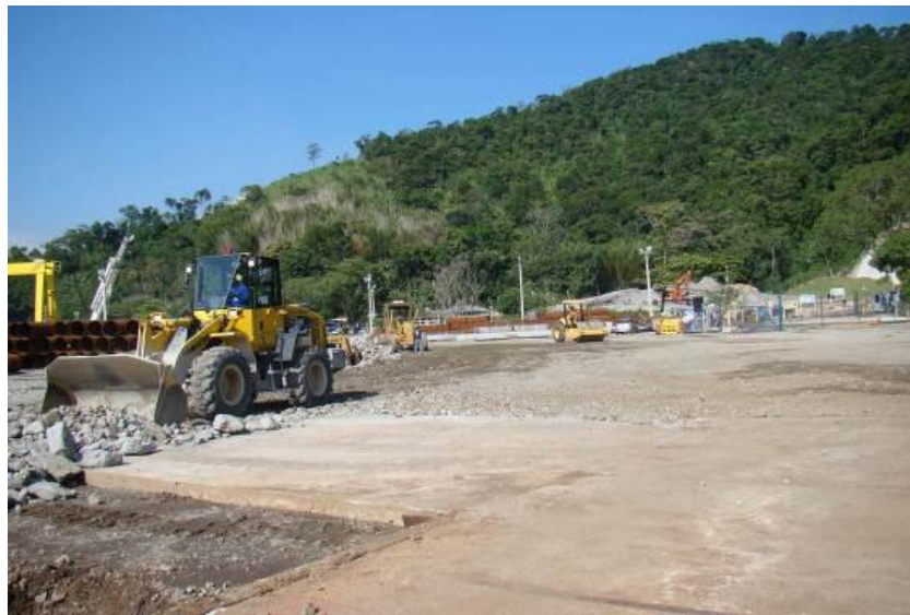
Figura 3 – Nivelamento em área no canteiro norte destinada a armazenamento de pré moldados em maio de 2012.
