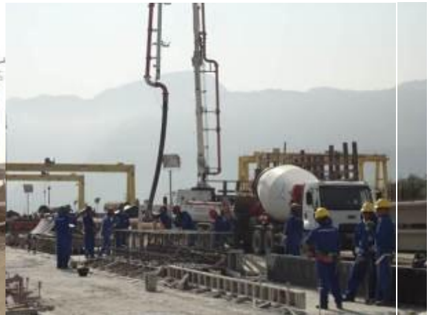
Figura 11 - Fabricação de pré-moldados.
