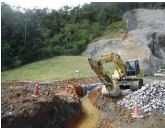
Figura 24 – Construção de Rede de drenagem provisória.
