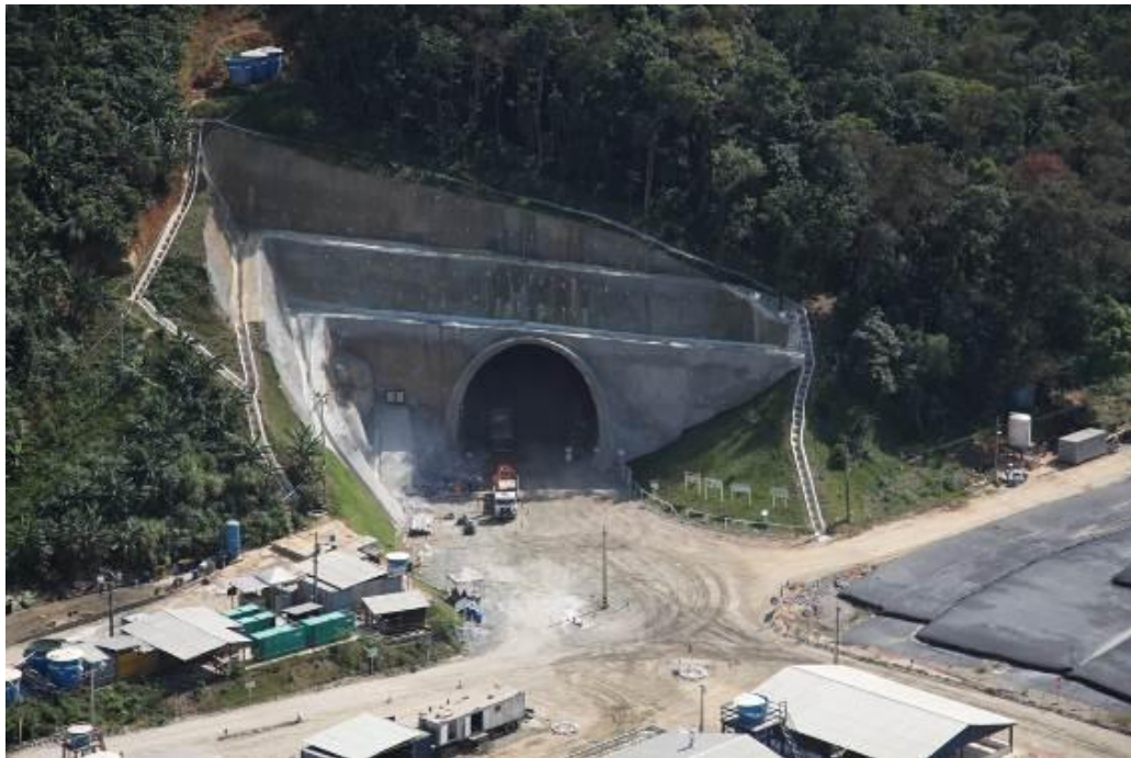
Figura 19 - Visão do emboque sul do túnel em agosto de 2012.
