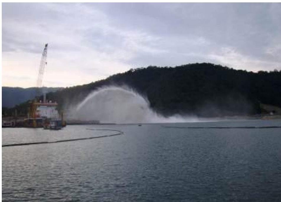
Figura 36 – Aterro por método Rainbow em junho de 2012.
