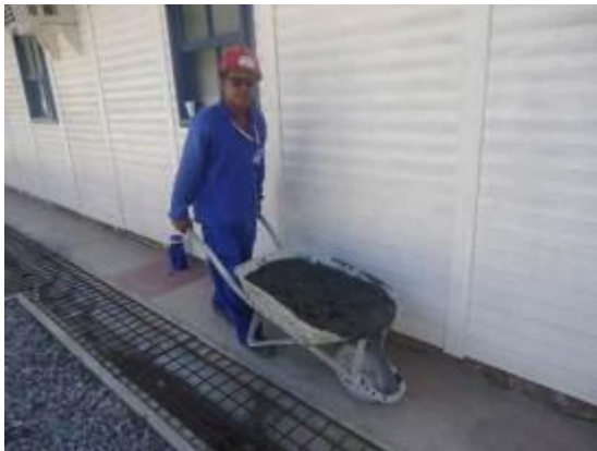
Figura 22 – Manutenção preventiva da rede de drenagem com retirada de lama
