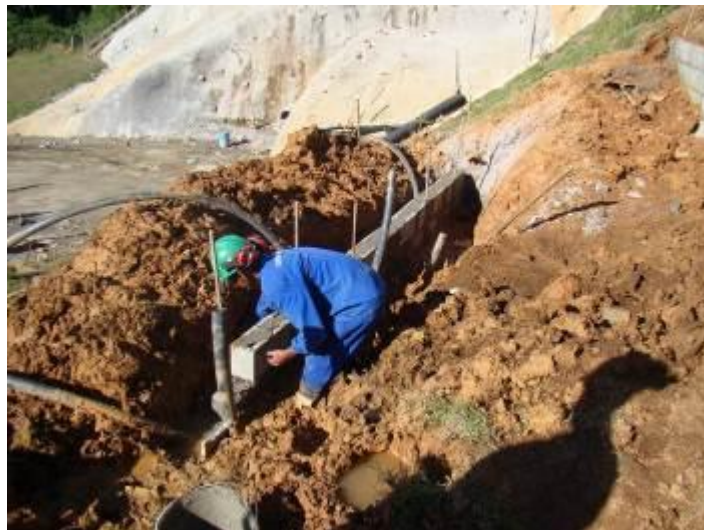
Figura 23 - Construção de muros de arrimo com sistema de drenagem em área de erosão em talude no emboque Norte do tunel.
