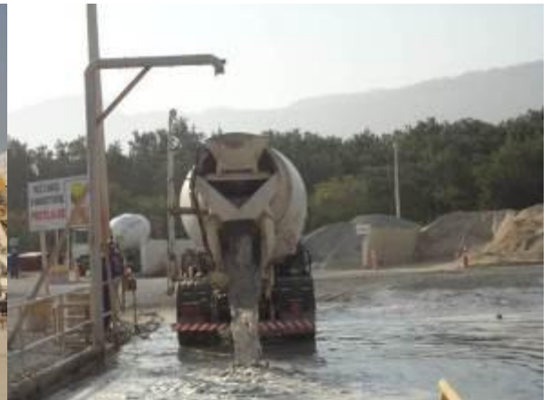
Figura 31 - Descarte da água na rampa
