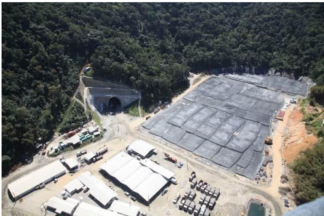
Figura 17 – Visão geral do Canteiro Sul incluindo o canteiro de apoio a construção do Tunel em agosto de 2012.
