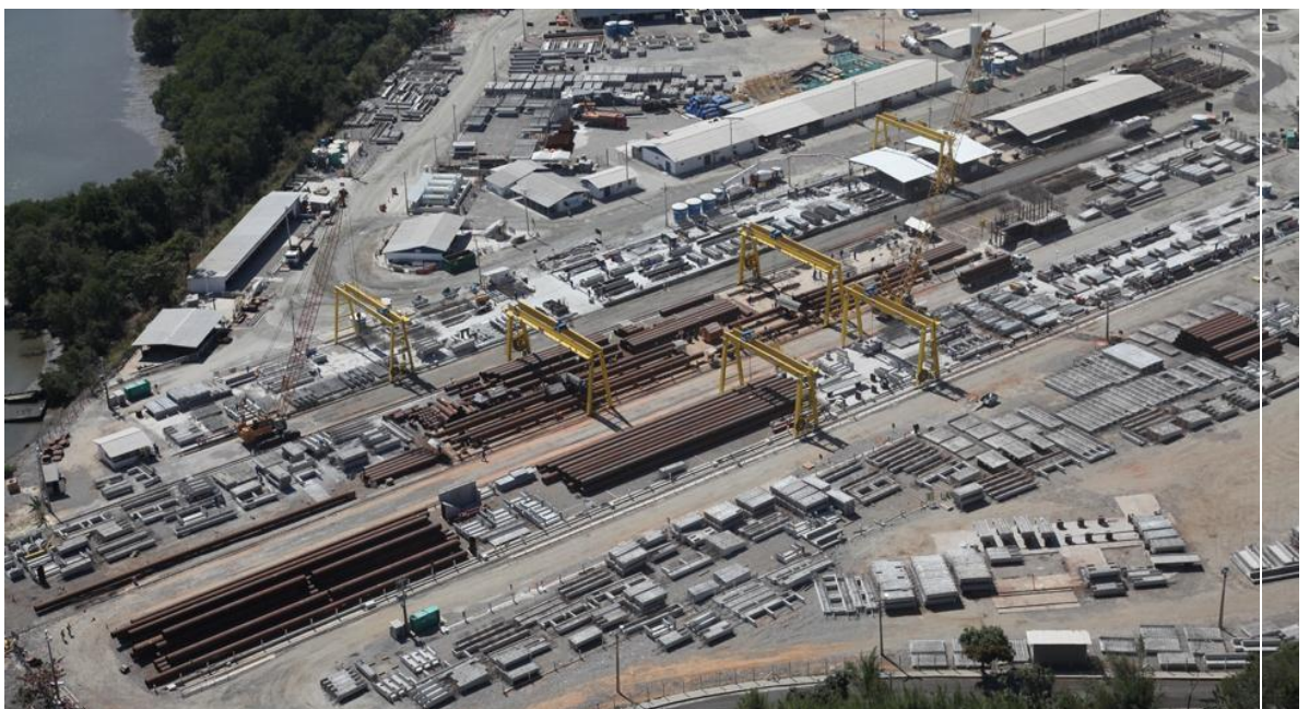
Figura 9 - Visão aérea do pátio de produção e armazenamento de pré-moldados em concreto e estacas metálicas.
