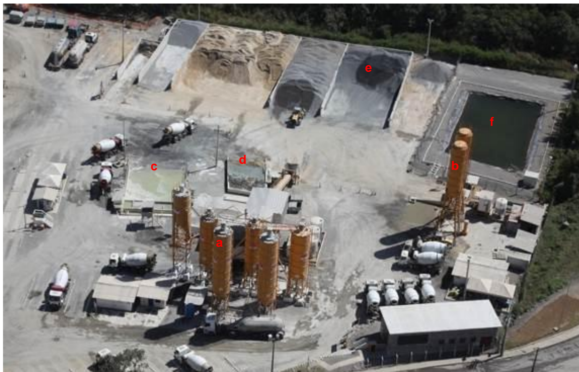
Figura 29 - Visão aérea da Central de concreto
