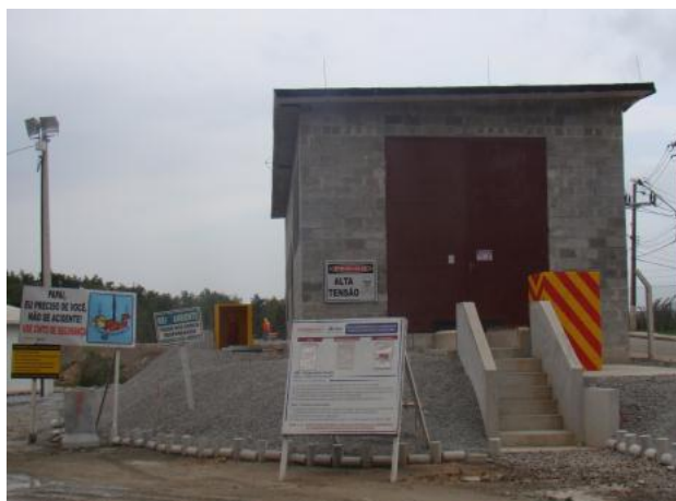
Figura 47 - Substação de energia – vista frontal.
