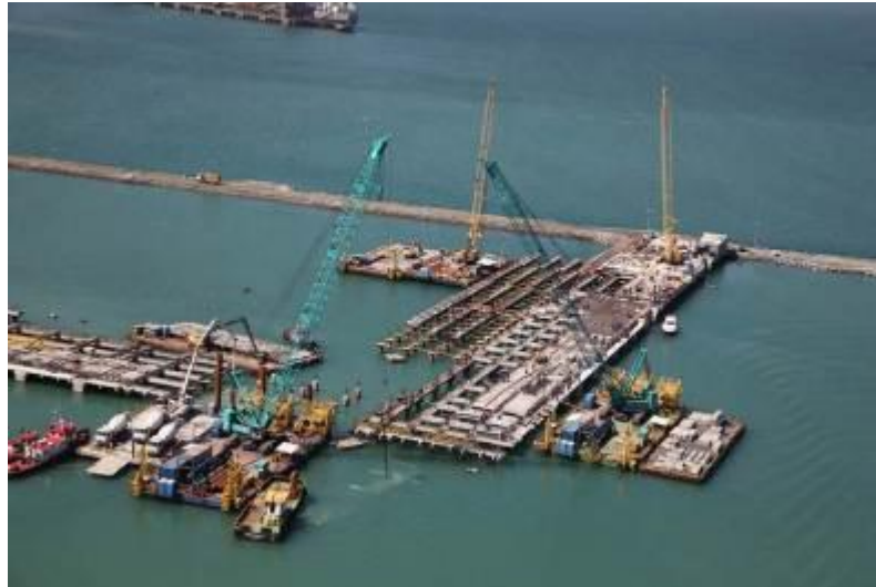
Figura 42 – Atividades de cravação de estacas, concretagem e lançamento de pré moldados.
