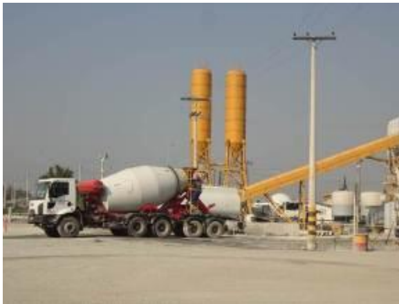
Figura 30 - Posicionamento de caminhão betoneira para lavagem
