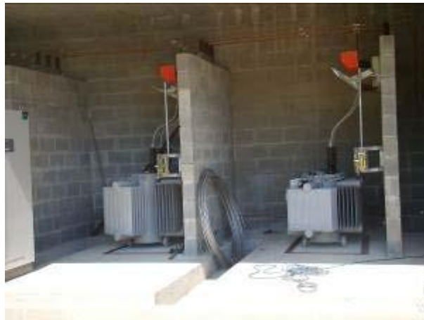
Figura 48 - Geradores presentes no Canteiro de Apoio ao Túnel - Norte.
