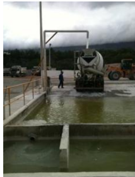
Figura 33 – Detalhe da lavagem com água de reuso proveniente da última célula da caixa de decantação após tratamento
