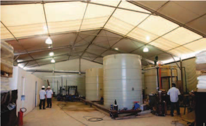
Acima, tratamento do sedimento contaminado - Unidade de dosagem de polímero; abaixo, sedimento nas unidades de Geotube dispostas em local definitivo
