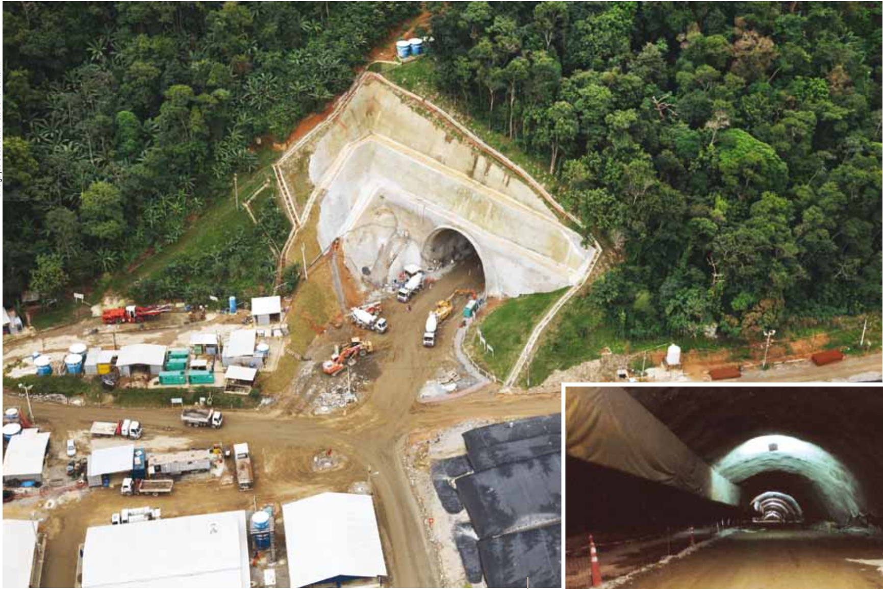
Acima, vista aérea do túnel na Área Sul; ao lado, detalhe do interior do túnel
