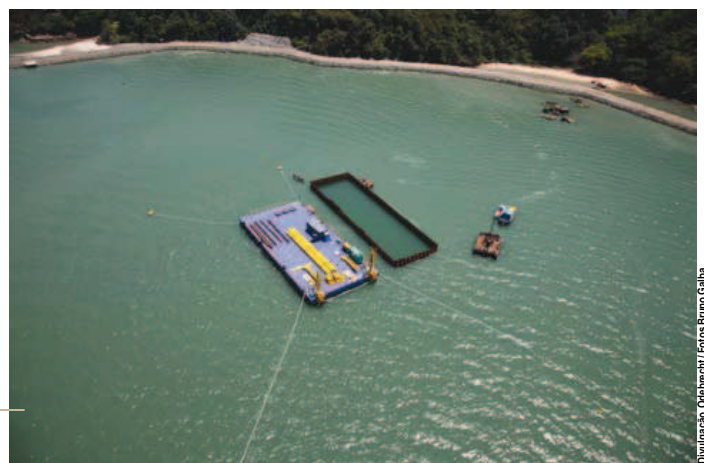
À direita no alto, área Sul do Estaleiro e Base Naval - início das obras marítimas; na sequência, detalhes das obras marítimas - enrocamento e estaqueamento
