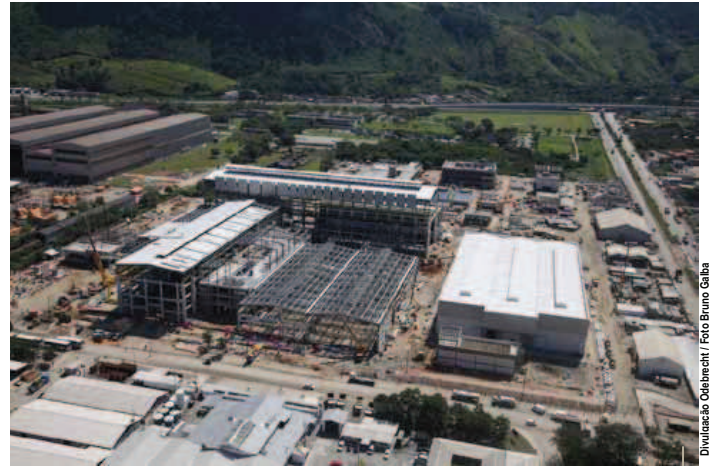
Vista aérea da Unidade de Fabricação de Estruturas Metálicas (UFEM)
