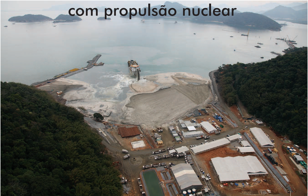
Estaleiro e Base Naval - Vista aérea da Ilha da Madeira - Área Sul - Início das obras de dragagem
