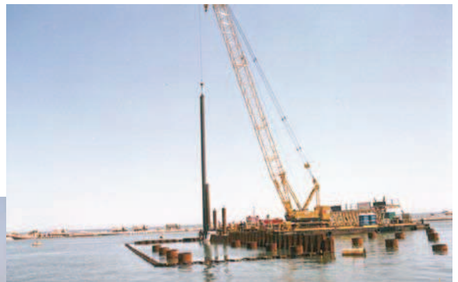
Início das obras marítimas: à esquerda abaixo, flutuantes e martelos hidráulicos em operação de estaqueamento; acima à esquerda, pátio de estacas metálicas; à direita, sequência do estaqueamento com o martelo hidráulico
