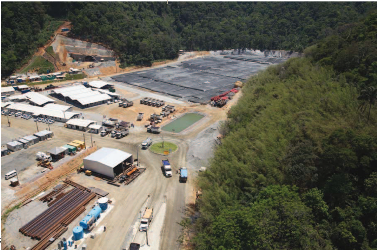
Acima, tratamento do sedimento contaminado - Unidade de dosagem de polímero; abaixo, sedimento nas unidades de Geotube dispostas em local definitivo
