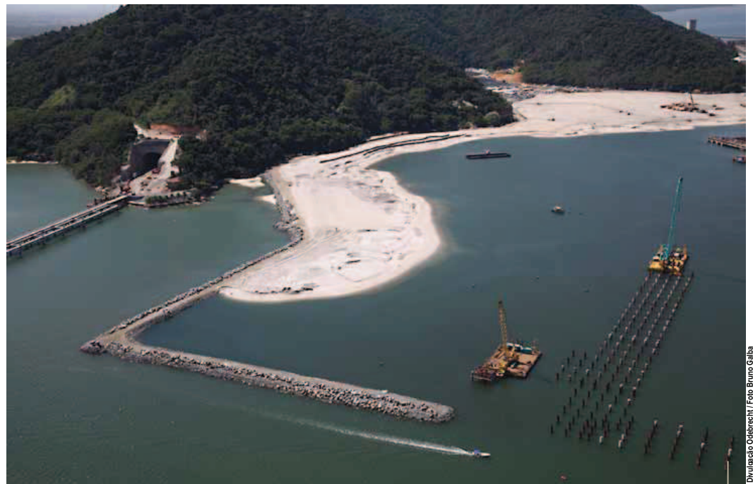
Obras marítimas na área Sul do Prosub - Estaleiro e Base Naval em Itaguaí
