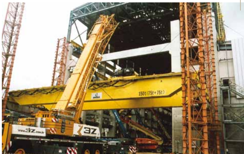
Início da montagem eletromecânica de pontes rolantes nas edificações da UFEM
