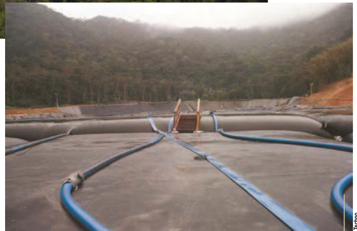
Acima, detalhe das unidades Geotube em área definitiva; abaixo, fiscais do IBAMA observam a área de lavagem de caminhão betoneira no qual a água recircula, gerando uma economia de 700L de água por caminhão - um processo inovador adotado pelo empreendimento
