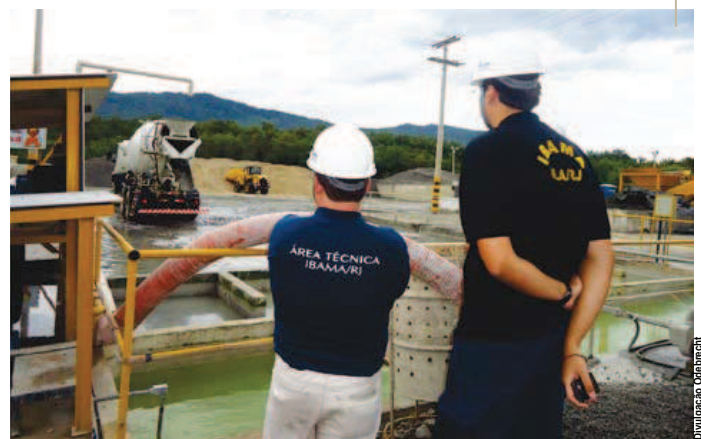
Acima, detalhe das unidades Geotube em área definitiva; abaixo, fiscais do IBAMA observam a área de lavagem de caminhão betoneira no qual a água recircula, gerando uma economia de 700L de água por caminhão - um processo inovador adotado pelo empreendimento
