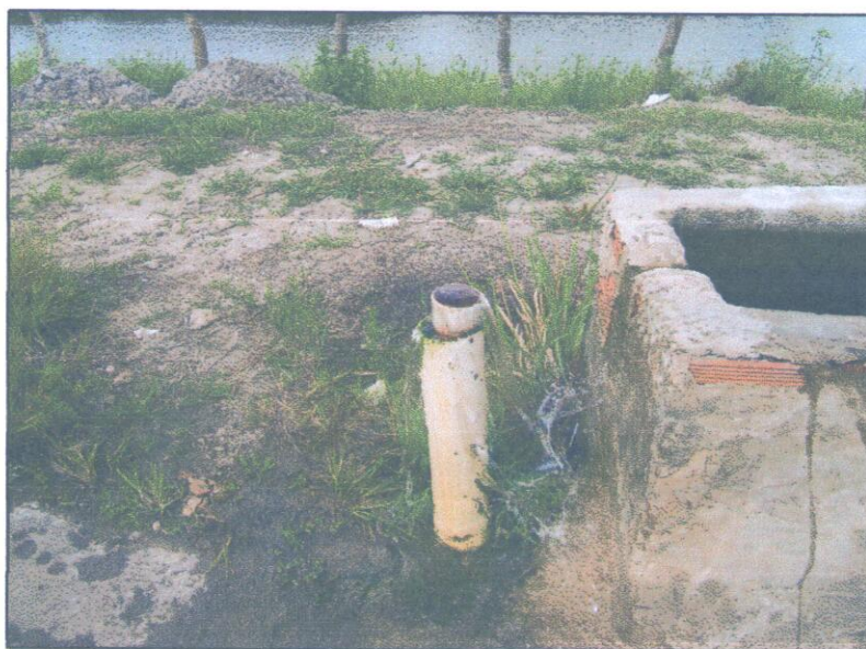
Figura 2 – Poço artesiano jorrante no vale do rio Coruripe
