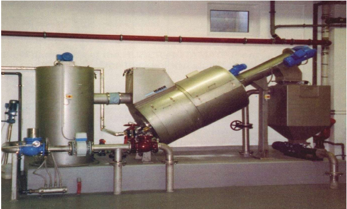
Figura 7.6 – Adensador Mecanizado do Tipo Tambor.
