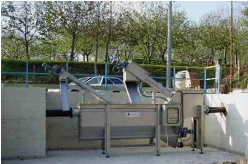
Figura 7.2 – Tratamento Preliminar Compacto e Mecanizado.
