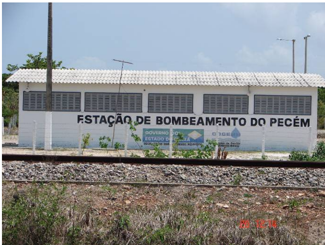
Foto 11 – Vista da Estação de Bombeamento do Pecém, localizada no setor norte do CIP.
