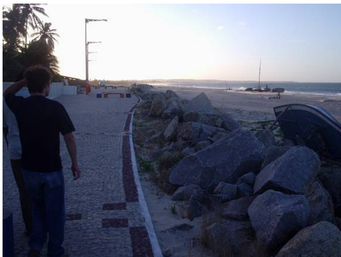
Foto 31 – Barreira física para evitar ação de ondas e marés dispostas na praia do Pecém para evitar erosão, fato este que não mais atinge a vila.
