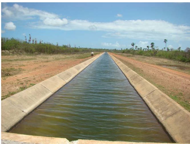
Foto 12 – Vista do Canal Sítios Novos – Pecém tomada do setor sudoeste do CIP.
