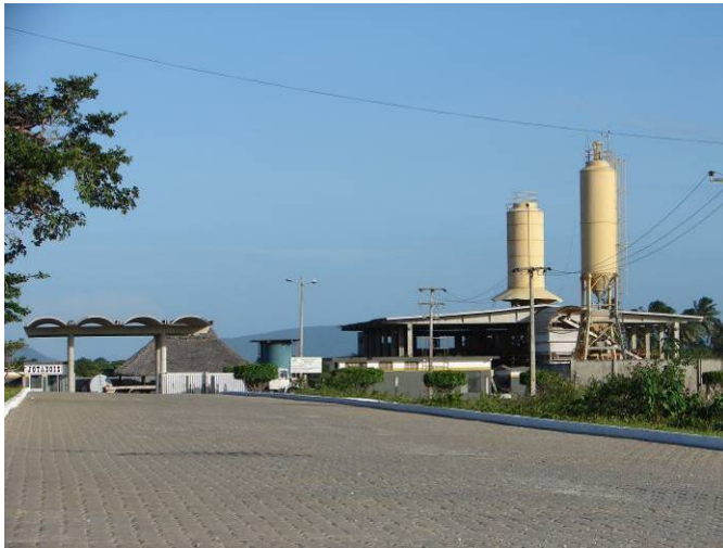
Foto 10 – JOTADOIS - Empresa produtora de pré-moldados, localizada no setor norte do CIP, município de São Gonçalo do Amarante.
