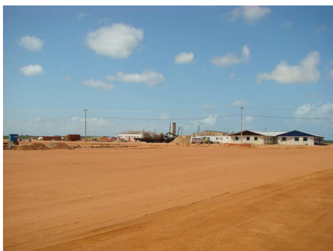
Foto 18 – Foto do canteiro de obras da UTE Porto do Pecém, situada no setor noroeste do CIP – Setor I.
