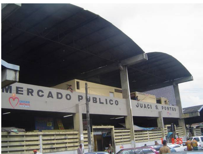
Foto 66 – Mercado Público Juaci S. Pontes, sede municipal de Caucaia.
