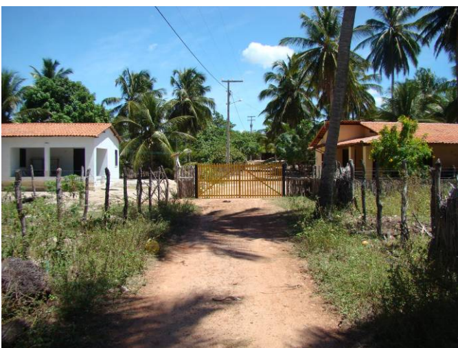
Foto 75 – Residências típicas da comunidade do Madeiro, localizada no setor noroeste do CIP
