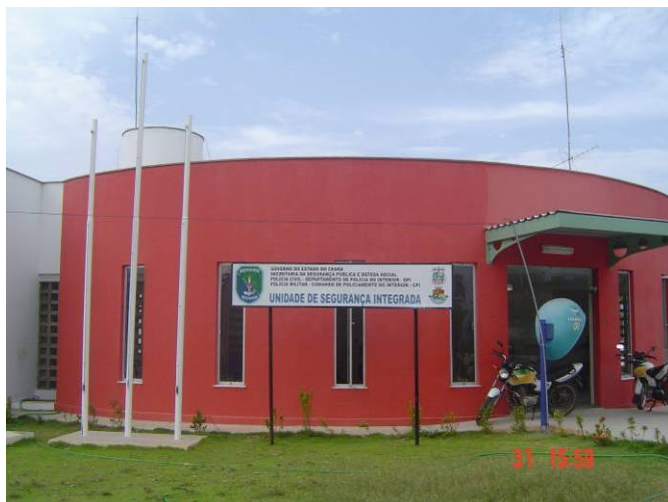
Foto 71 – Unidade de Segurança Integrada, sede municipal de São Gonçalo do Amarante.
