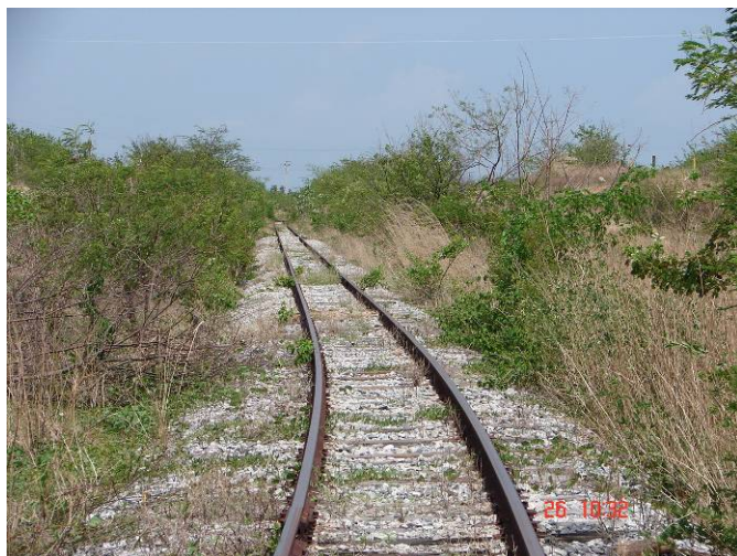
Foto 07 - Linha Férrea existente no CIP. Tomada feita no setor sudeste, município de Caucaia.
