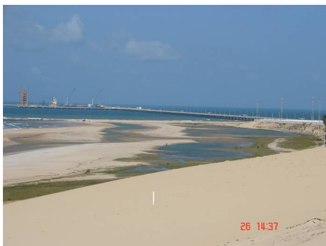
Foto 19 – Vista geral do Terminal Portuário do Pecém, localizado na área de influência do CIP.
