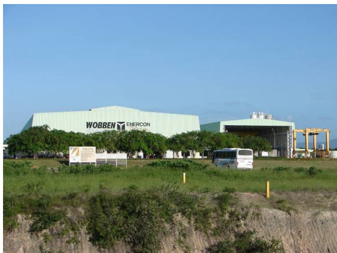
Foto 08 - Empresa de Aero geradores Wobben Windpower, localizada no setor centro-norte do CIP, município de Caucaia.
