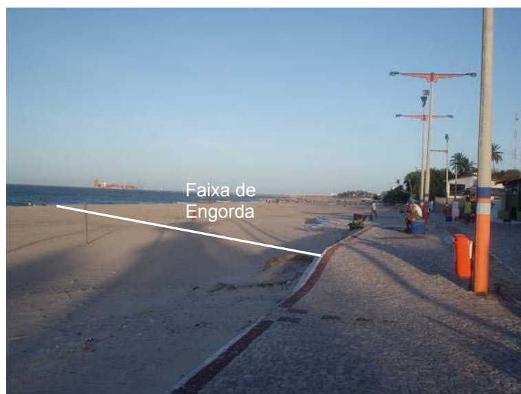
Figura 3.5 - Aumento Significativo da Praia de Pecém, Agora Sofrendo Ação dos Ventos e Permitindo Assoreamento do Calçadão da Vila
