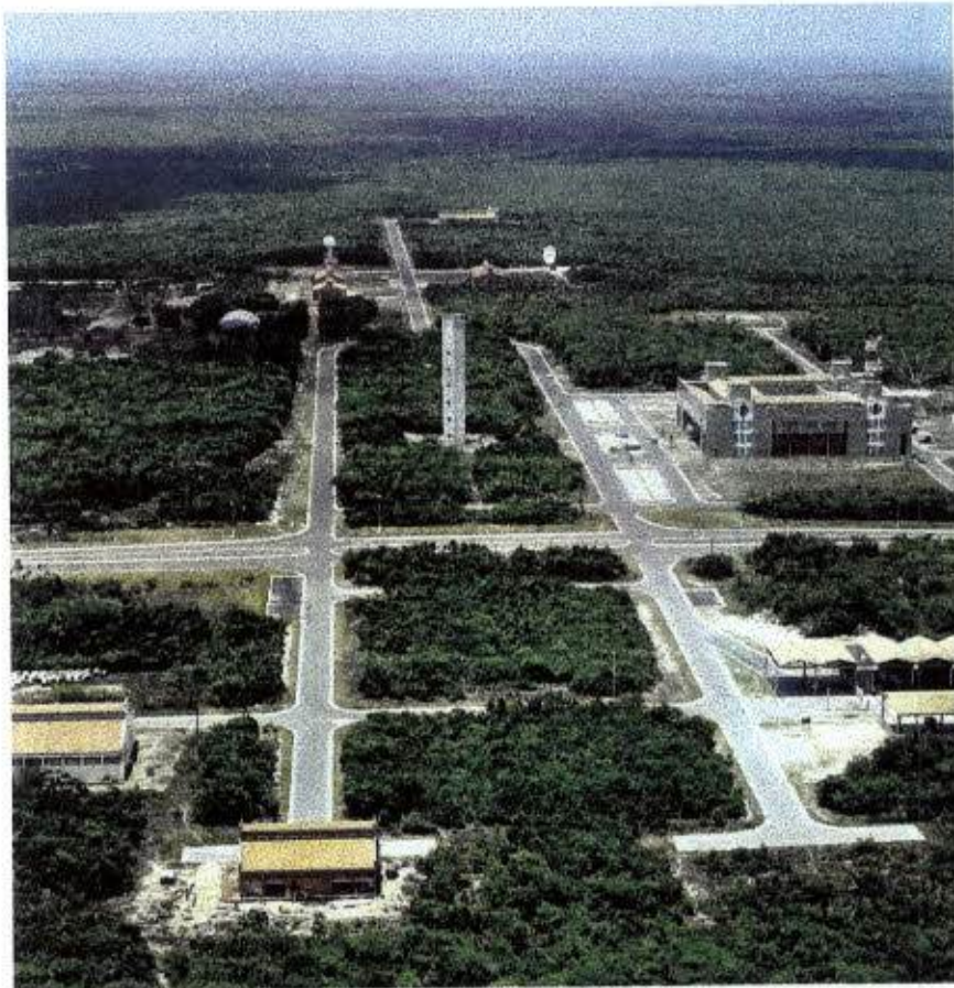
Foto 1 - Vista aérea do Centro de Controle do CLA
