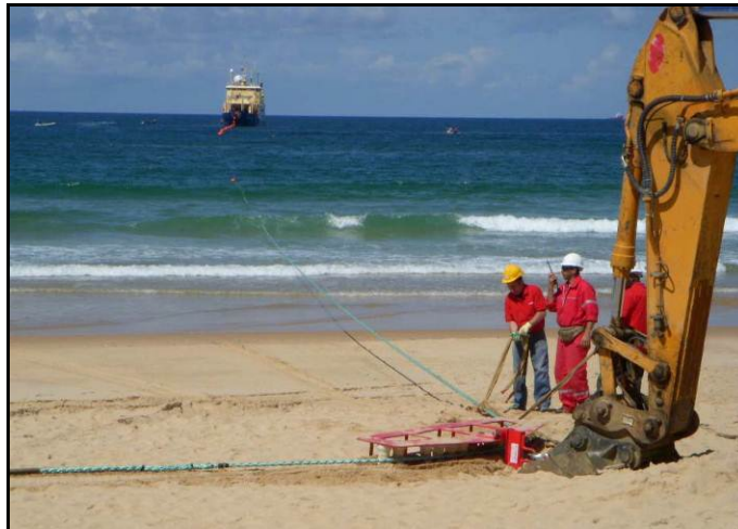
Figura III-33 - Uso do quadrante para a tração do cabo submarino na faixa de areia
