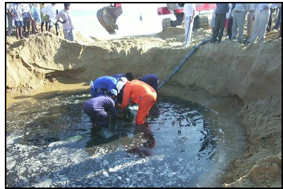
Figura III-36 - Obras de instalação da placa de aterramento
