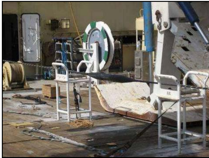
Figura III-8 - Exemplo de junção do cabo submarino, realizada a bordo do navio de instalação
