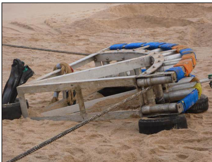
Figura III-17 - Quadrante na praia - usado para executar o tracionamento do cabo ao longo da praia
