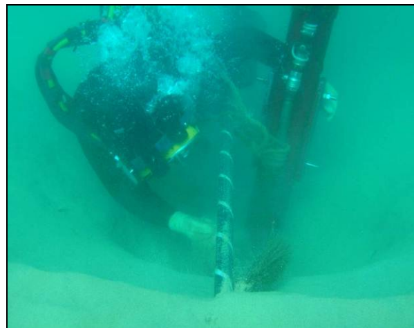
Figura III-15 - Ferramenta de jateamento manual - Airlifting
