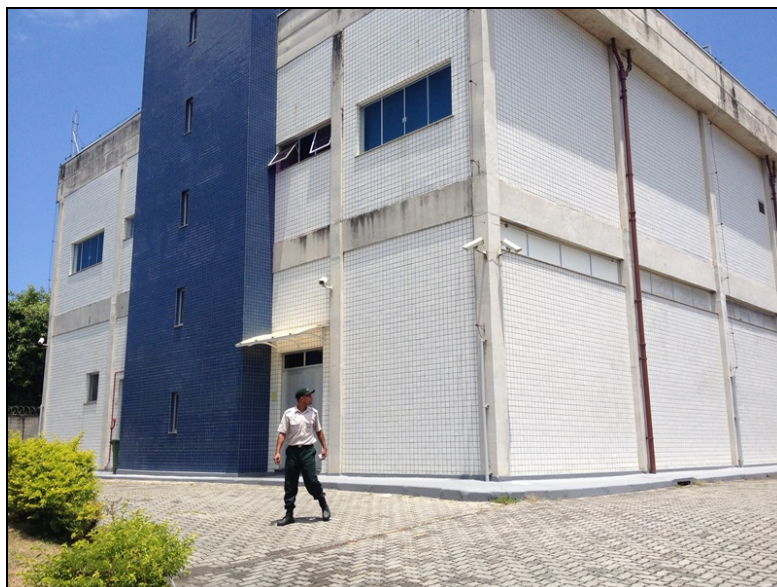
Figura III-18 - Prédio da Estação terminal (CLS) da Telefônica no Recreio dos Bandeirantes/RJ
