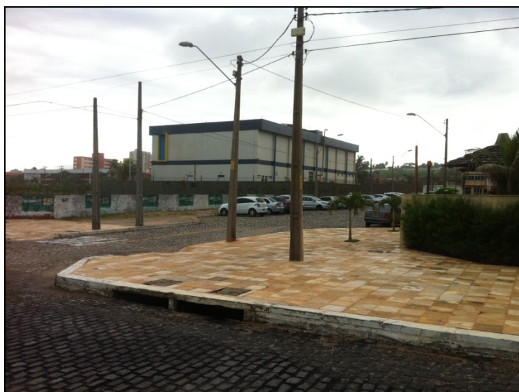
Figura III-19 - Prédio da Estação Terminal (CLS) da Telefônica na Praia do Futuro/FLZ
