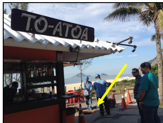
Figura V.3-9 - Quiosque TO_ATOÁ, na Praia da Macumba - Rio de Janeiro e local de interligação do Cabo BRUSA (BMH).
