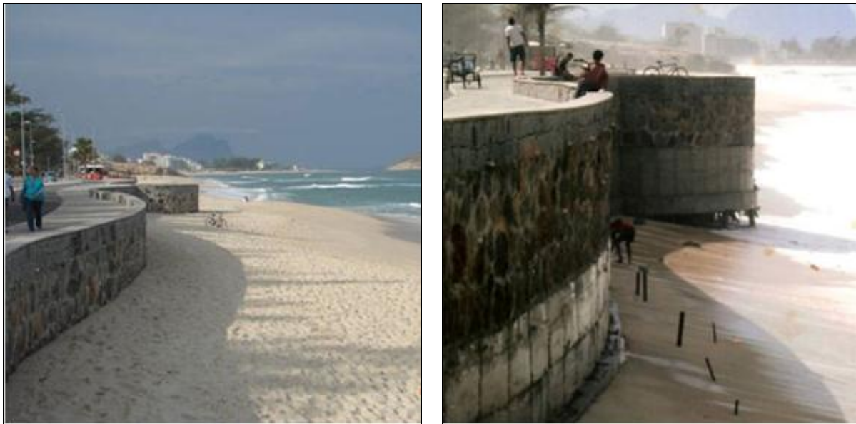
Figura V.1.4-5 - Variações no perfil ativo da praia. Comparando a foto da esquerda, de 2007, com a foto da direita, de 2009, é possível observar o quanto o estoque emerso foi comprometido em função de tempestades.
