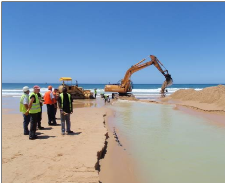
Figura IV-7 - Abertura de vala com retroescavadeira no trecho de areia de praia.
