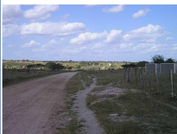
Vista geral de estrada vicinal com ocorrência de blocos de rocha isolados e cobertura do solo com espessura média de 1,0 m, o que facilita a execução das operações de manutenção do leito.
