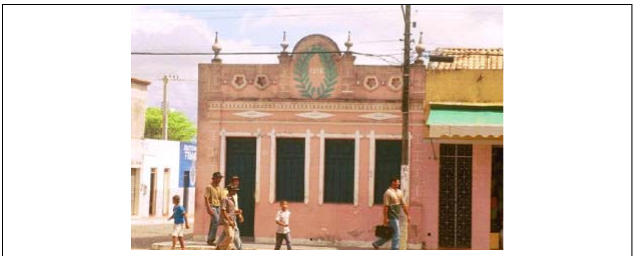
Foto 3 - Detalhe - fachada principal do casario secular da cidade Nossa Senhora da Glória. Casa datada de 1919.
