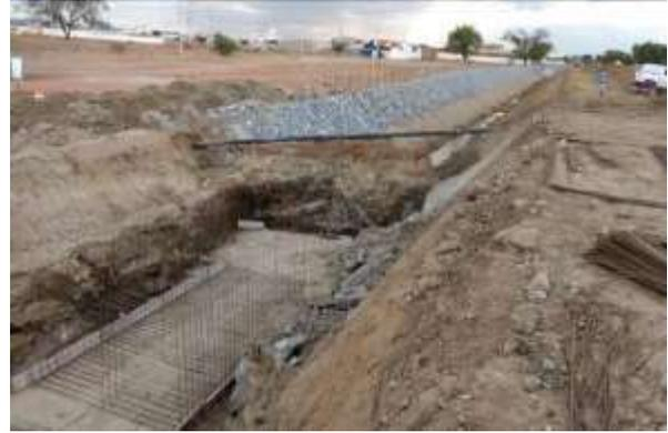
**Figura 15-334** – Trecho final, em construção, do canal de drenagem das águas pluviais, paralelo a adutora.
