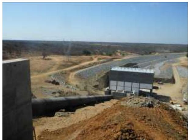
**Figura 15-226** – Vista superior da EBV – 5 + tubulação de Recalque
