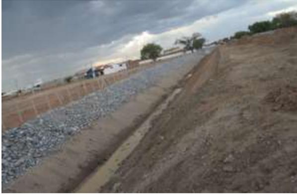
**Figura 15-333** – Canal de drenagem das águas pluviais, paralelo a adutora.
