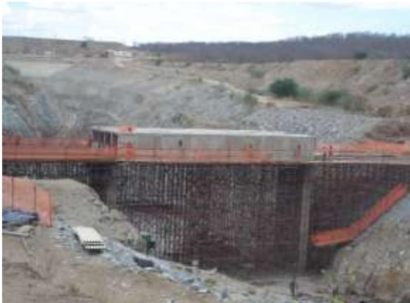
**Figura 15-303** – *Overchute* em fase de construção
