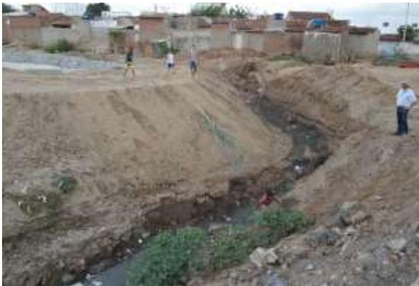
**Figura 15-331** – Trecho da adutora interrompido devido ao lançamento de águas pluviais + esgoto em trecho próximo ao lançamento da água no PISF no Rio.
