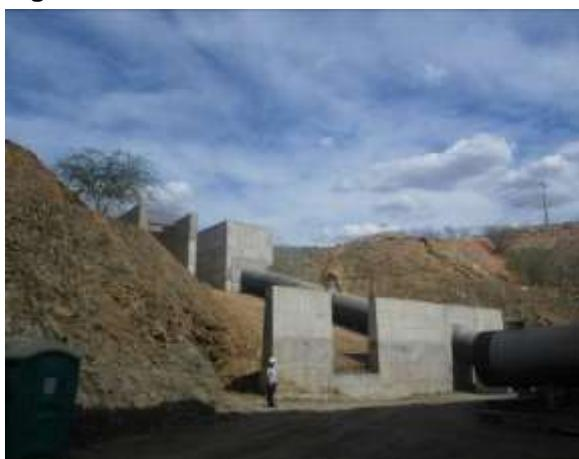
**Figura 15-141** – Tubulação de Recalque – EBV – 4
