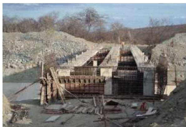
**Figura 15-176 – Overchute em construção**
