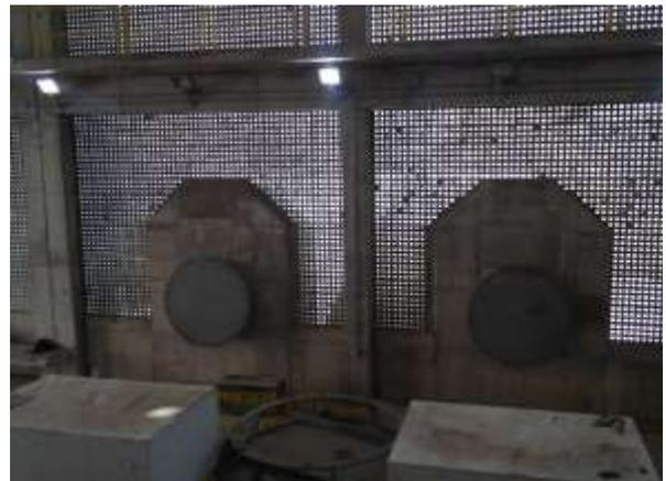
**Figura 15-16** – Entrada para futura instalação do segundo conjunto moto-bomba.
