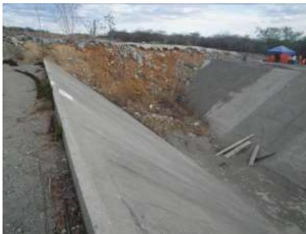
**Figura 15-203** – Canal Interrompido para travessia da equipe de obra.
