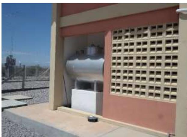
Figura 15-349 – Tanque de Combustível (1000litros) para gerador.
