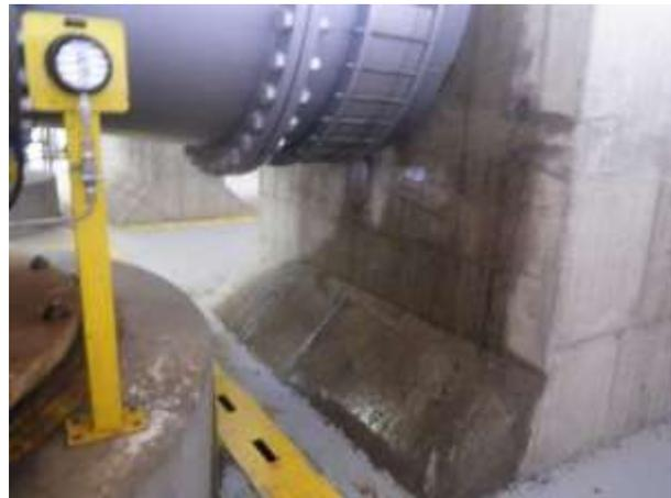
**Figura 15-46** – Vazamento na tubulação - EBV-2
