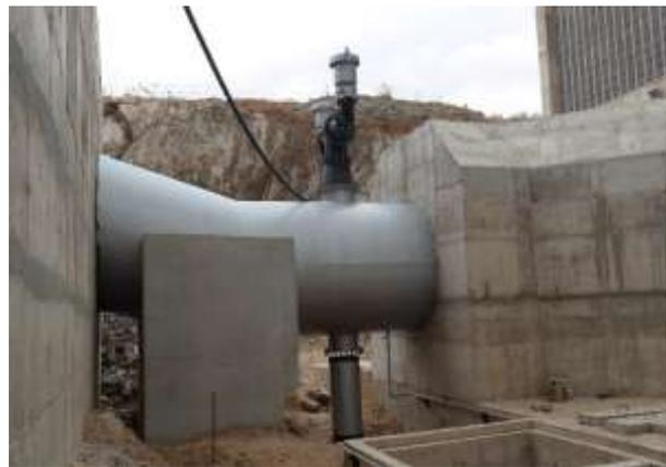
**Figura 15-48** – Tubulação de Recalque - EBV-2
