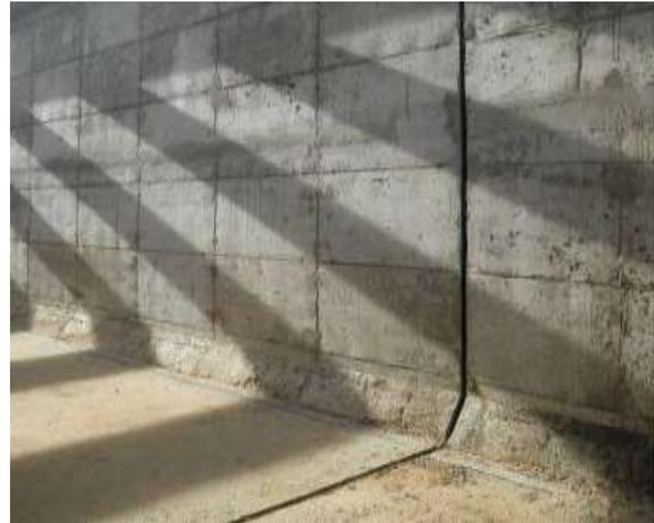
**Figura 15-162** – Junta - aqueduto x canal.
