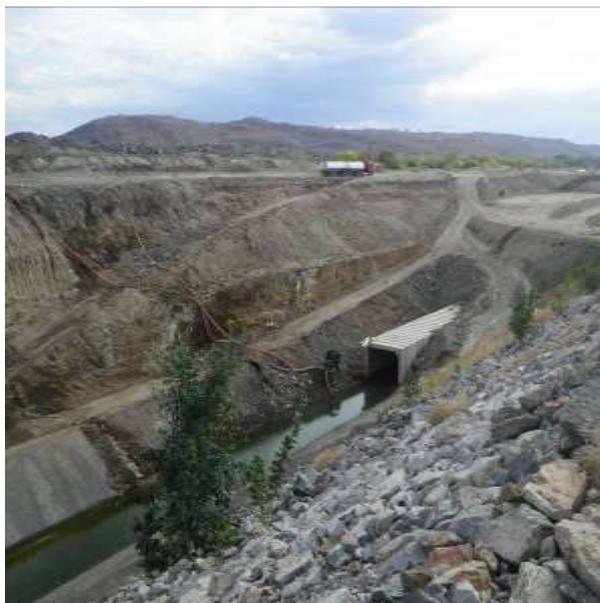
**Figura 15-321** – Saída da Galeria Monteiro para o canal, a montante da adutora.
