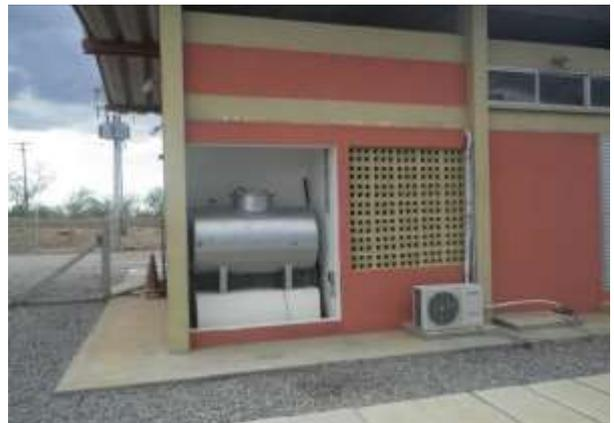
**Figura 15-362** – Tanque de combustível para gerador
