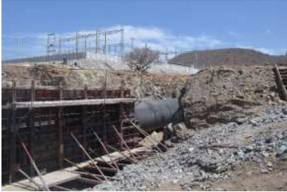
**Figura 15-251** – EBV – 6 – Linha de Recalque em Implantação
