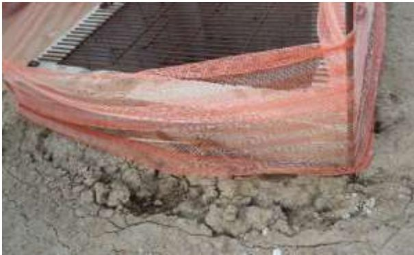
**Figura 15-329** – Processo erosivo na base do ponto de visita.
