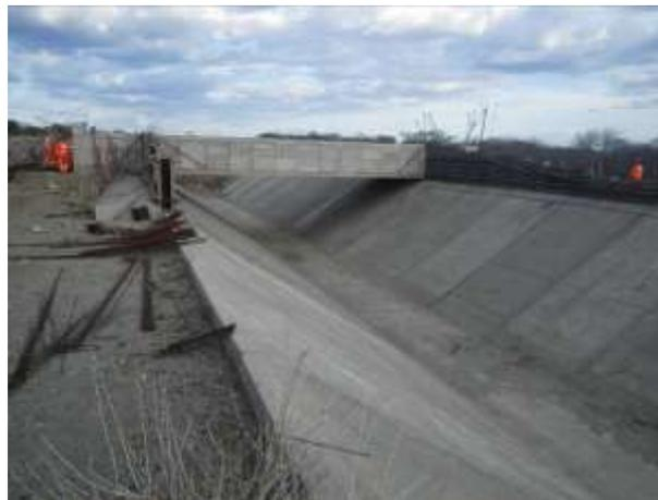
**Figura 15-202** – *Overchute* em Construção
