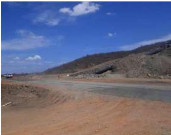
**Figura 15-253** – EBV – 6 – Linha de Recalque, sob acesso, em Implantação
