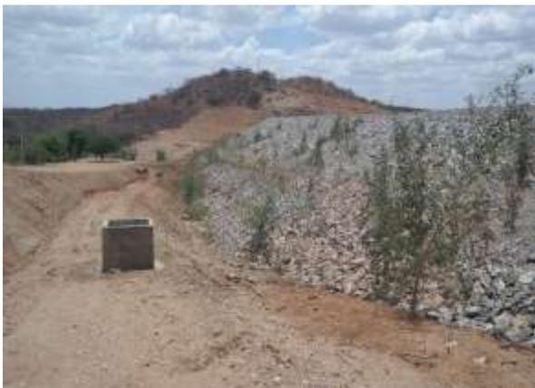
**Figura 15-273 – Piezômetro**
