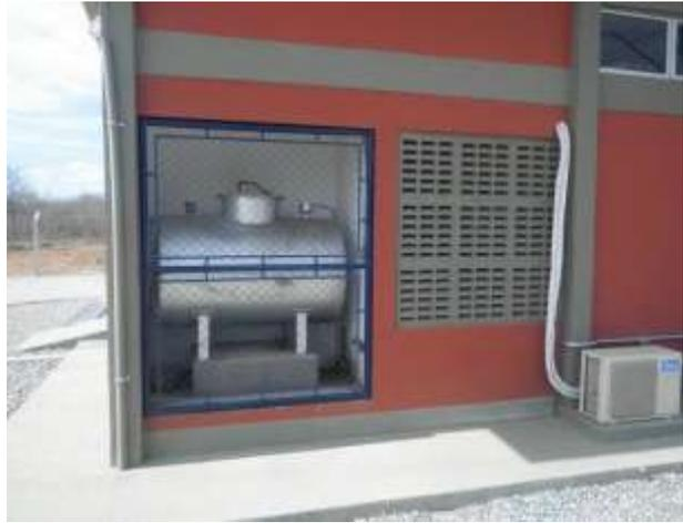
**Figura 15-370** – Tanque de combustível para gerador, fonte alternativa de energia
