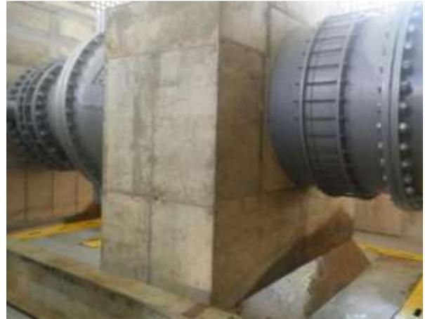
**Figura 15-12** – Vazamento na tubulação EBV-I
