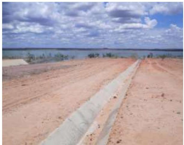
**Figura 15-28** – Sistema de Drenagem, paralelo ao canal, desaguardo no Reservatório Areias.
