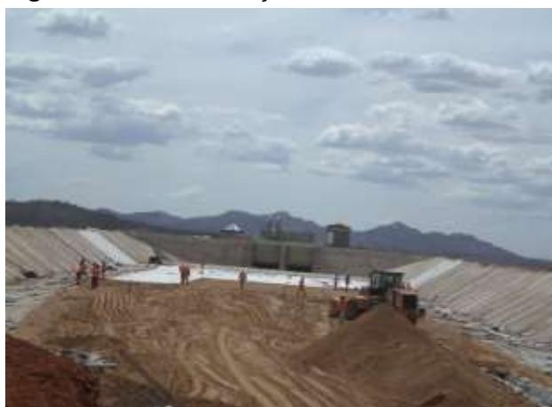
**Figura 15-142** – Forebay de Jusante – EBV – 4 + Canal em construção
