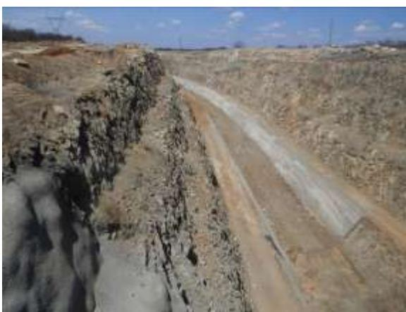
**Figura 15-248 – Canal em Construção**
