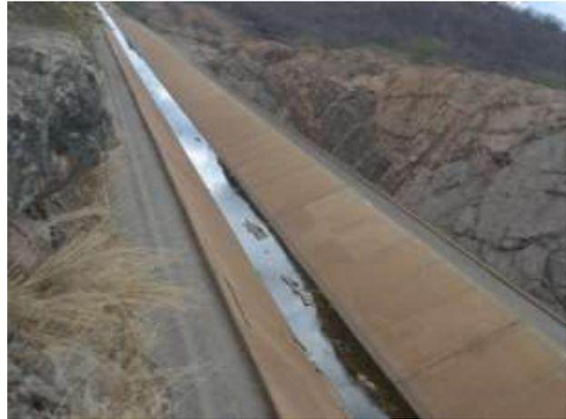
**Figura 15-300** – Canal com problema decorrente do sistema drenagem.
