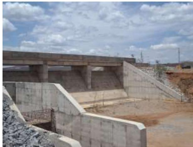
**Figura 15-272 – Vertedouro - Reservatório Campos**
