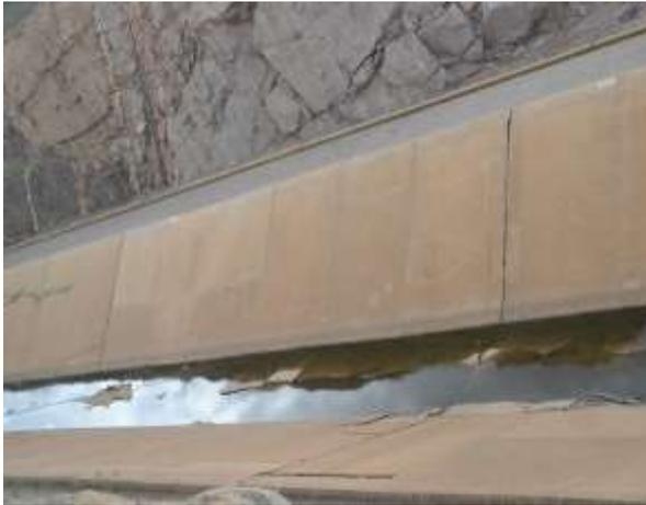
**Figura 15-299** – Canal com problema decorrente do sistema drenagem.
