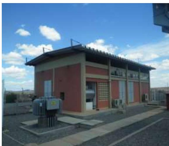
Figura 15-348 – Transformador + Casa de Comando + Casa Gerador + Casa Bateria
