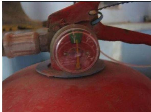
Foto 1.2.12. Extintor de incêndio em condições adequadas de uso.
