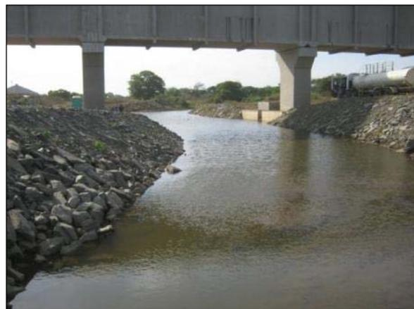
Foto 1.2.24. Canal de restituição do curso hidrico sob o devidamente estabilizado com enrocamento dos taludes.
