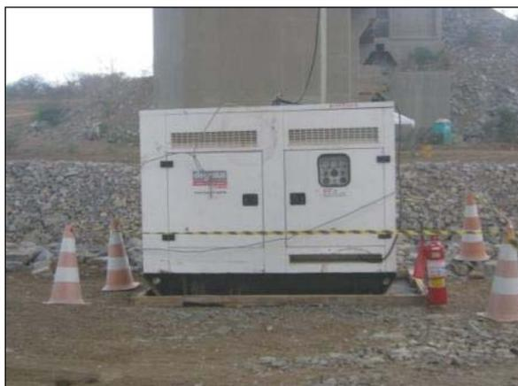
Foto 1.2.19. Gerador instalado sobre bandeja de contenção e extintor na frente de serviço
