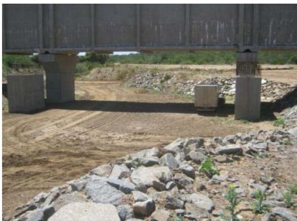
Foto 1.2.23. Vista da área com proteção dos taludes implantada a fim de minimizar o carreamento de materiais sólidos para o talvegue.
