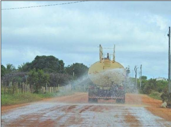
Foto 1.2.1. Caminhão pipa realizando umectação na via de acesso entre Brejo Santo e o canteiro central.
