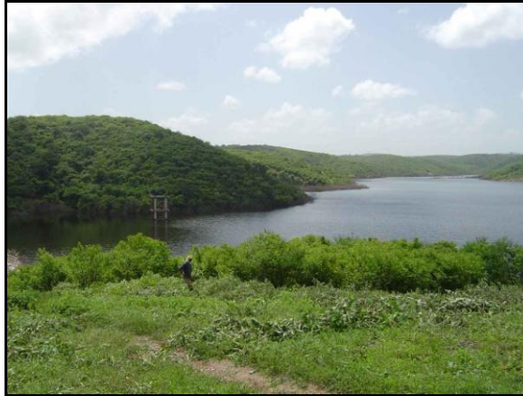
Foto 28.4. Vista do Açude Atalho (9155 619 N 511 682 L), que ficará inserido no sistema adutor do Projeto
