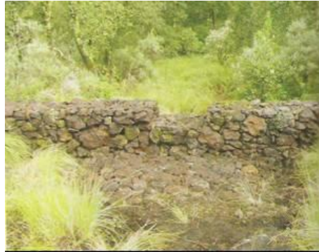
Figura 24.39. Barraginhas Mista, Pedra Argamassada com Pedra Arrumada a Jusante.
