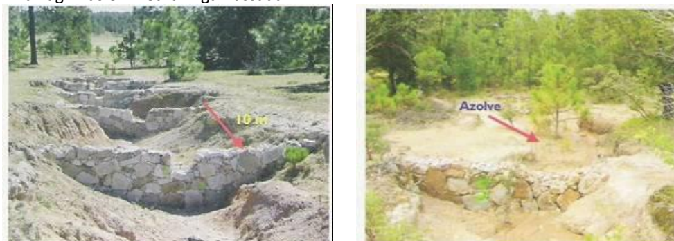
Figura 24.31. Barraginhas em Pedra Argamassada.
