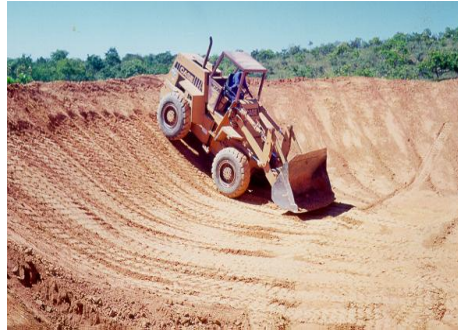
Figura 24.38. Execução de uma Barraginha de Terra Tipo EMBRAPA com Pá Carregadeira.
