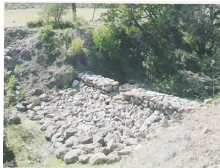
Figura 24.30. Barraginhas mistas, Gabiões com Pedra Arrumada a Jusante.
