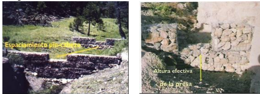
Figura 24.29. Barraginhas em Gabiões com Vertedouro Central.
