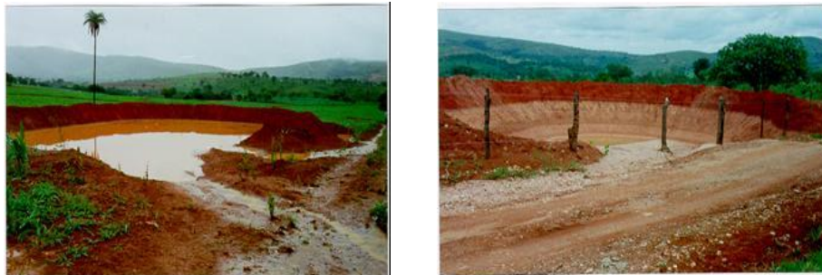
Figura 24.37. Barraginha de terra Tipo EMBRAPA.
