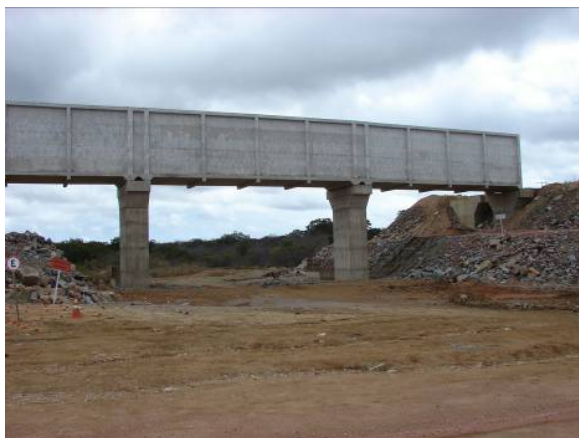
Foto 01 Aquedutos Lote 1 Trecho I
