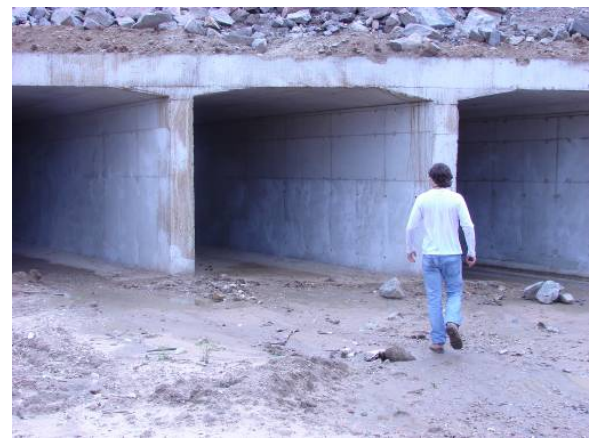
Foto 02. Pequenas Galerias Quadradas e Retangulares Lote 11 Trecho V.
