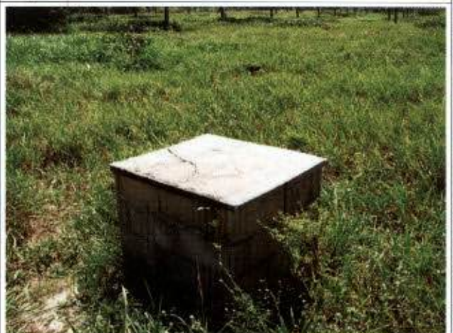
Foto 16: Poço para captação de água para abastecimento da área do stand de vendas.
