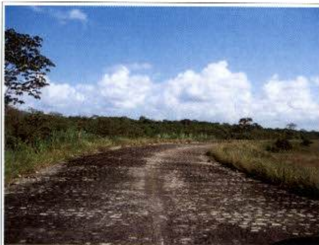
Foto 01: Via pavimentada em paralelepípedos que serve de acesso ao local previsto para construção do canal de navegação, no rio Camaragibe.
