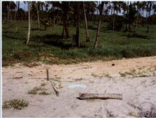
Foto 17: Fossa instalada para atender aos sanitários do stand de vendas.
