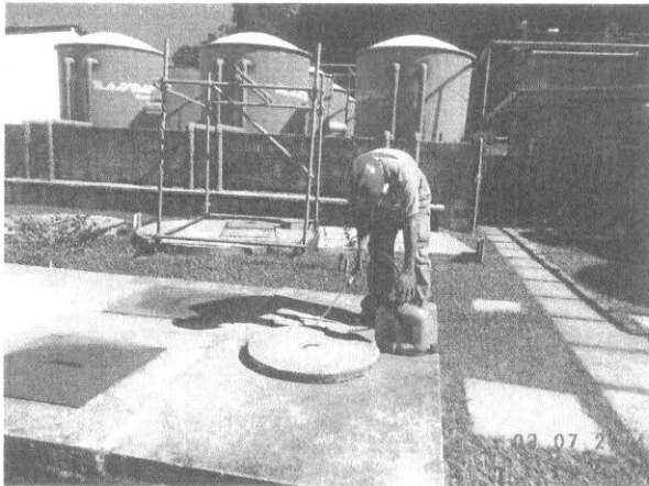
Foto 01: Realização de controle de vetores nas áreas do canteiro de obras.
