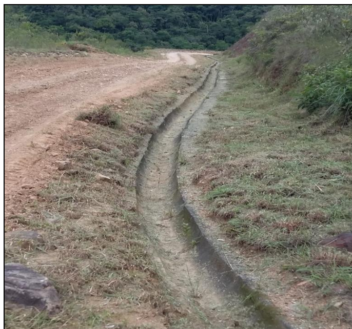
Figura 4 - Canaleta de drenagem pluvial
