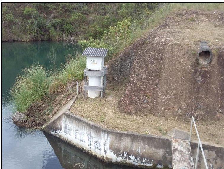
Figura 3 - Remoção de vegetação no Ponto 025E
