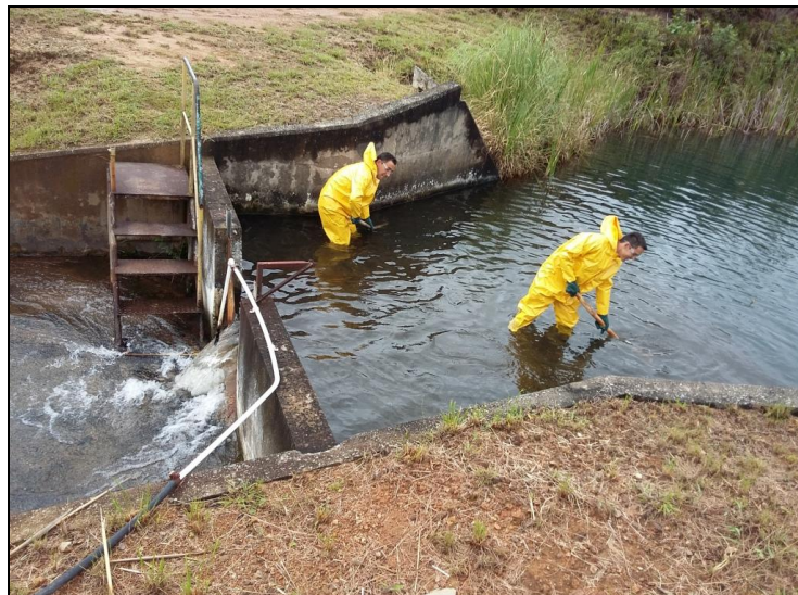
Figura 2 – Limpeza na área próxima ao sistema extravasor
