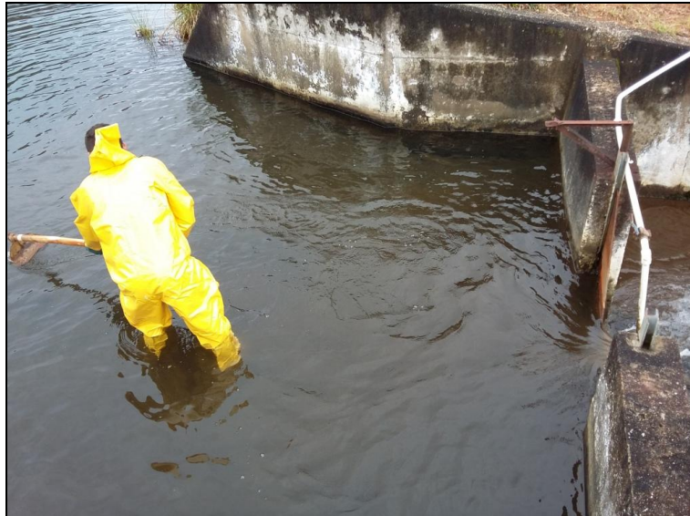
Figura 1 - Manutenção na bacia de decantação
