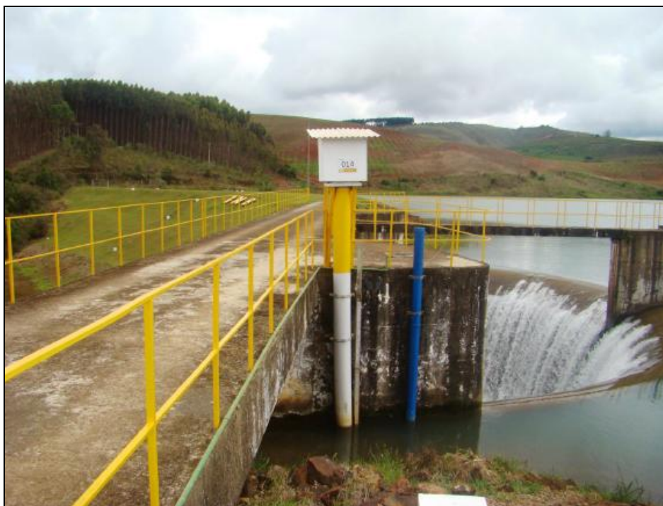
Figura 2 - Sistema extravasor, vertedor em arco.
