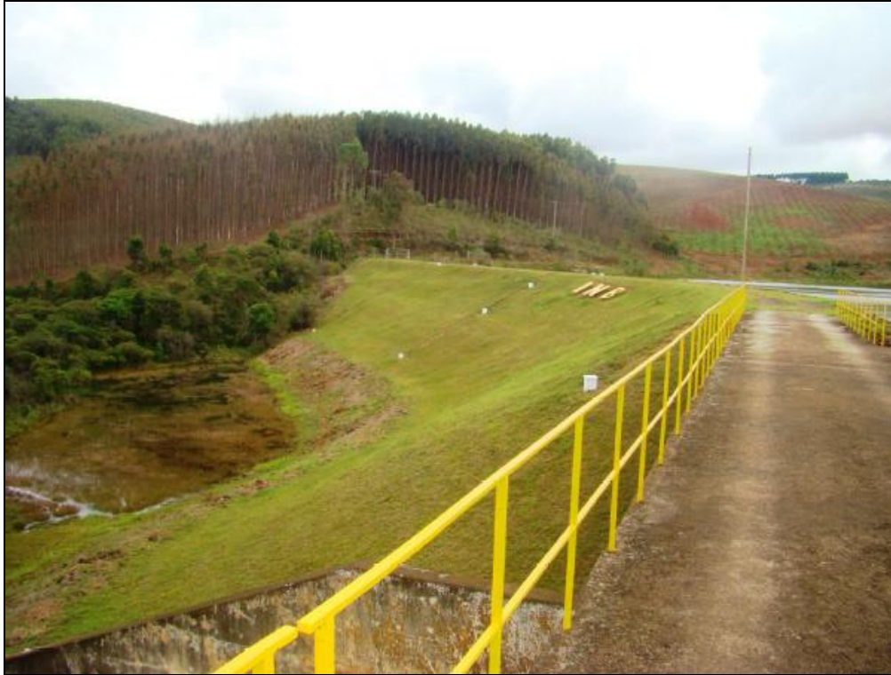
Figura 1 - Barragem de Águas Claras, vista da ombreira esquerda.
