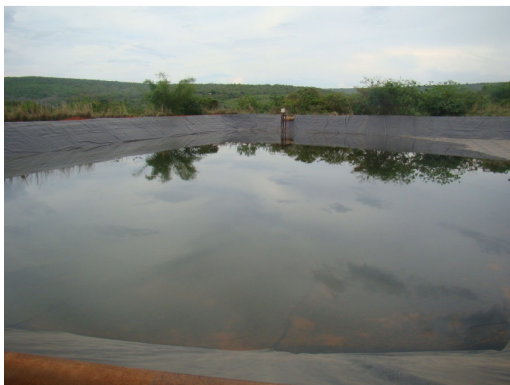
Figura 9.6.1 - Bacia de sedimentação de finos
