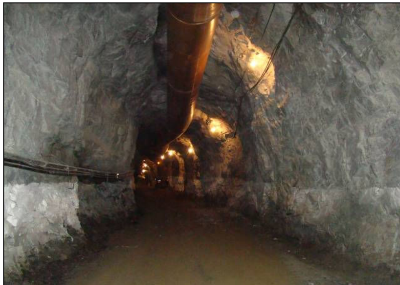
Figura 9.2.2 - Rampa da Mina Subterrânea
