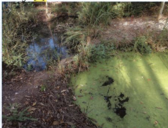
Ilustração 40: Barramento construído no córrego. [8]
