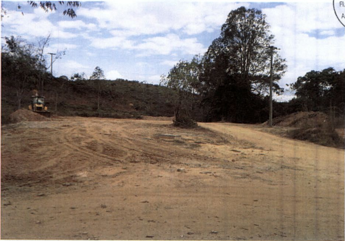
Ao lado direito, via de acesso à área da USICON. Mais à direita, bota-fora para reparos de via.
