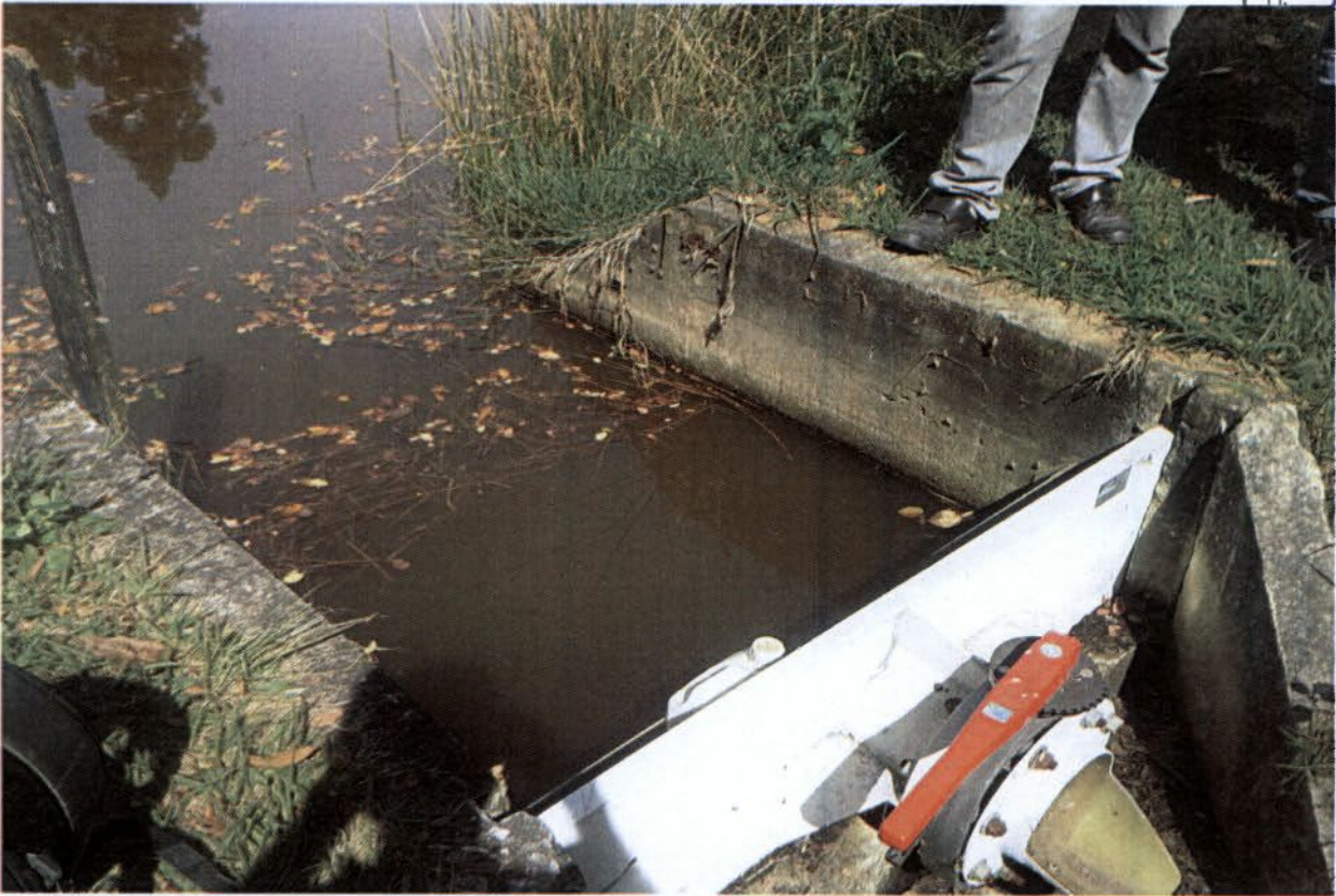
Visão da comporta da Lagoa de Polimento, com a presença de macrófitas na margem da lagoa.
