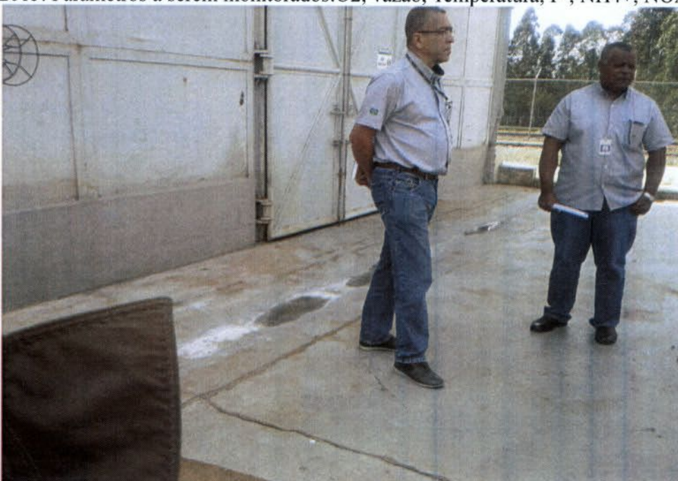
Canaleta refeita após acidente, em fevereiro de 2014.
