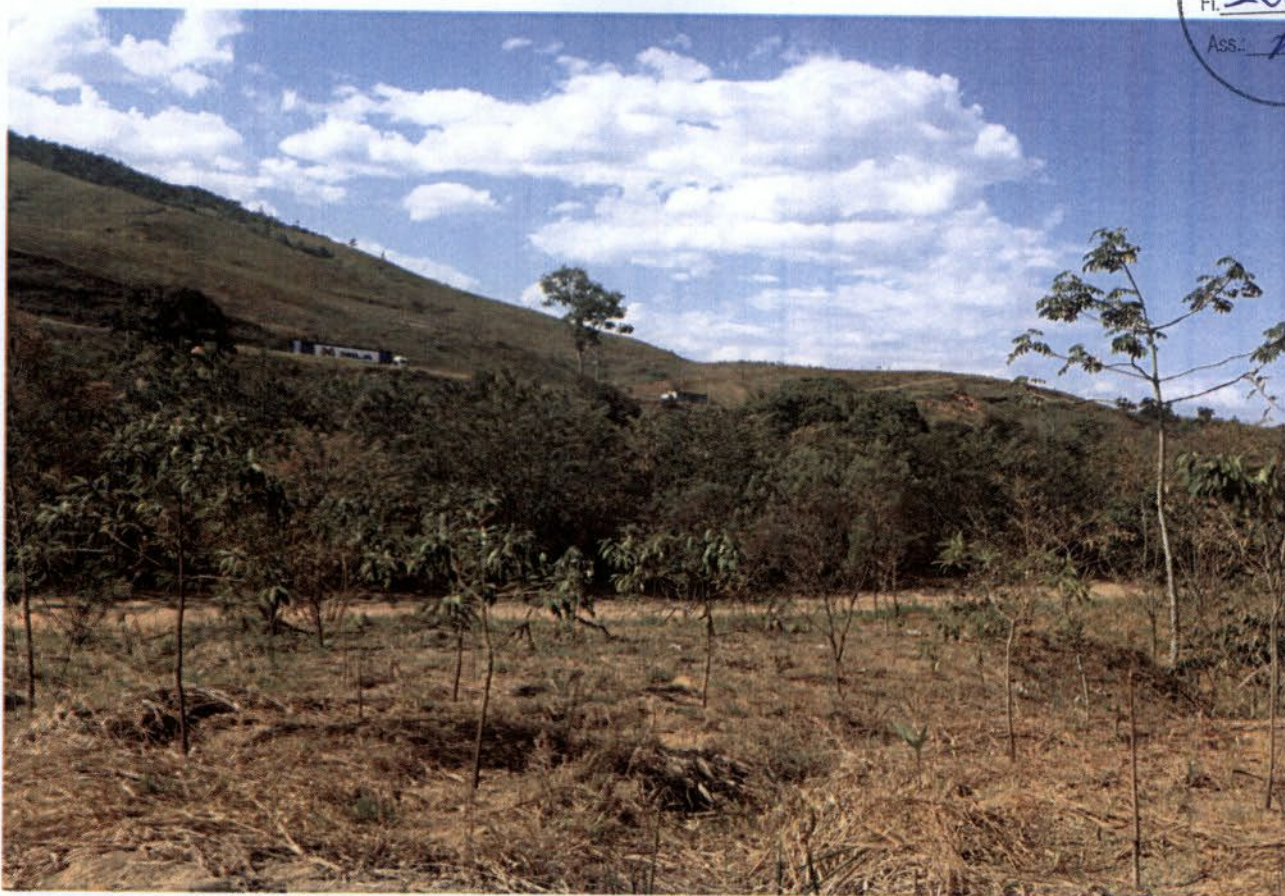
Área norte da propriedade da INB. Talhão n° 20 após limpeza do terreno.
