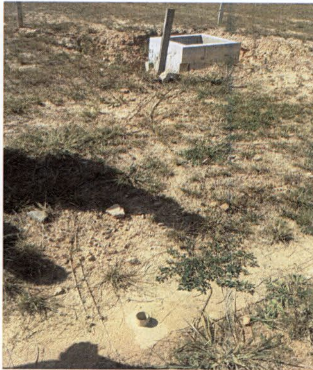
Presença de estruturas deixadas como indicação para drenagem e para os portões.
