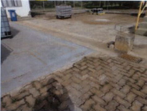
Ilustração 10: Drenagem pátio multiúso [2]
