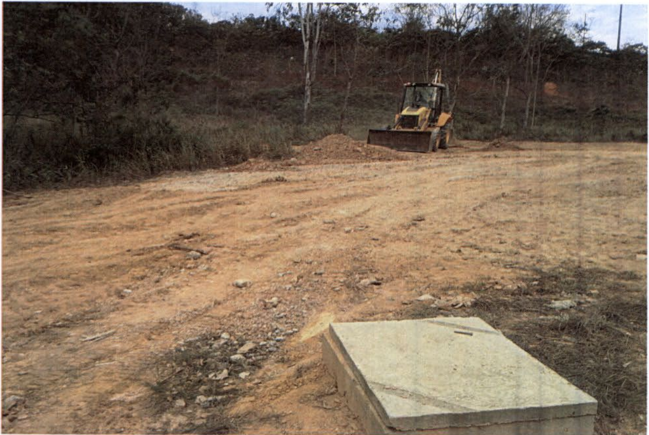
Escavadeira realizando limpeza da via. Segundo o empreendedor, não há nenhuma relação com as obras de ampliação da área de armazenamento de resíduos.
