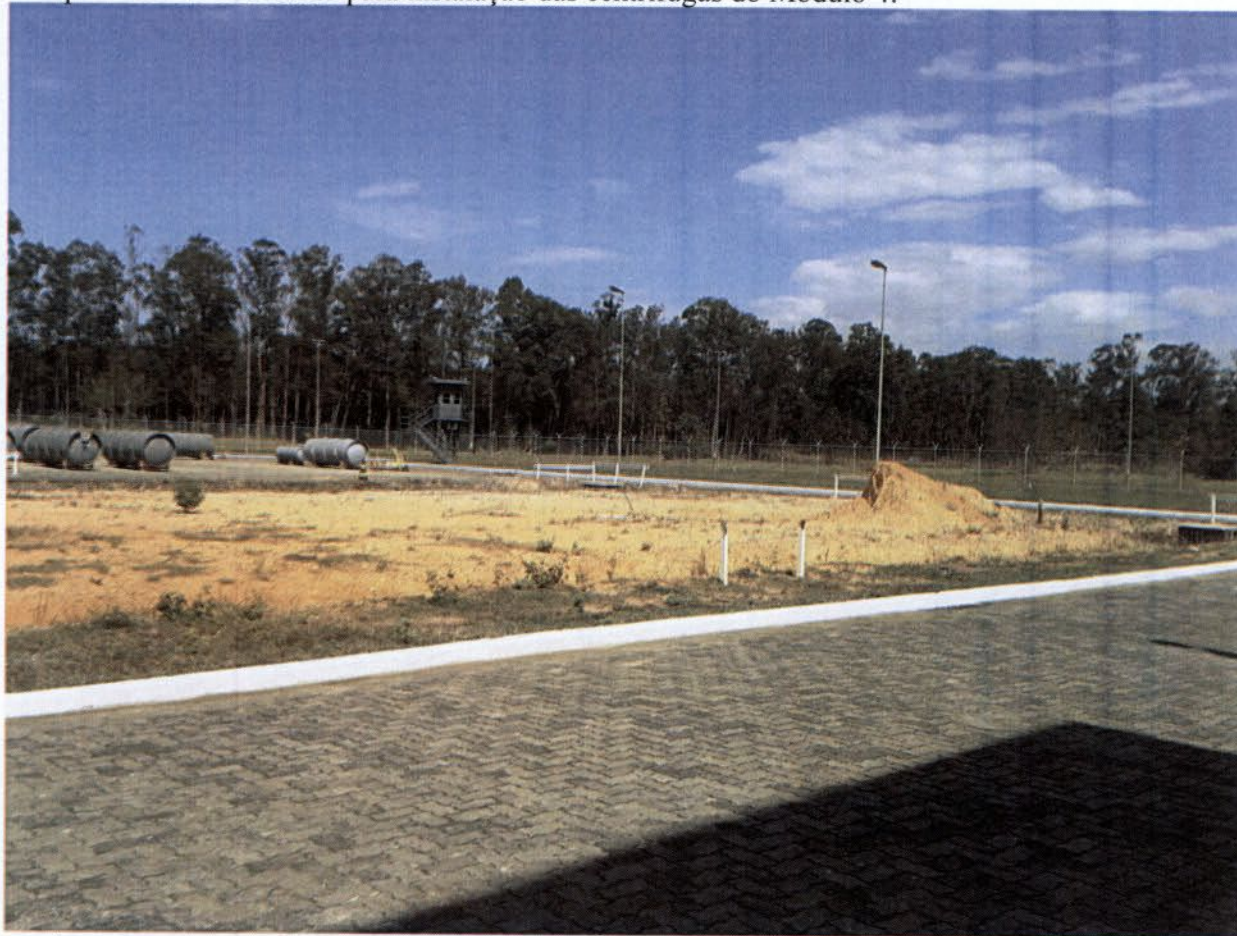
Área prevista para armazenamento de novos cilindros, com a conclusão das obras.
