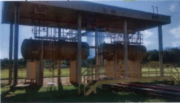
Ilustração 25 Tanques de amônia [9]
