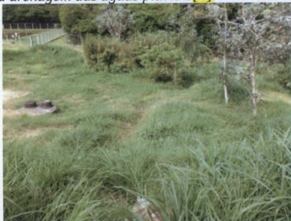
Ilustração 35: Vegetação amarelada no caminho da drenagem das águas pluviais [4]
