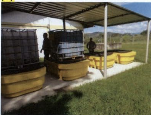
Ilustração 14 :Caixas de contenção [3]
