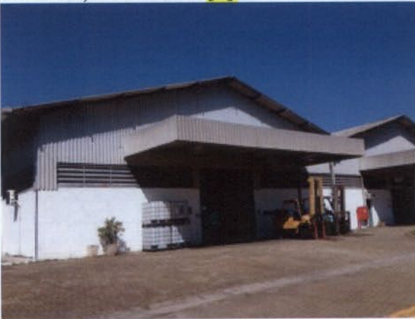
Ilustração 27 Depósito de rejeitos de baixa atividade, área externa [7]
