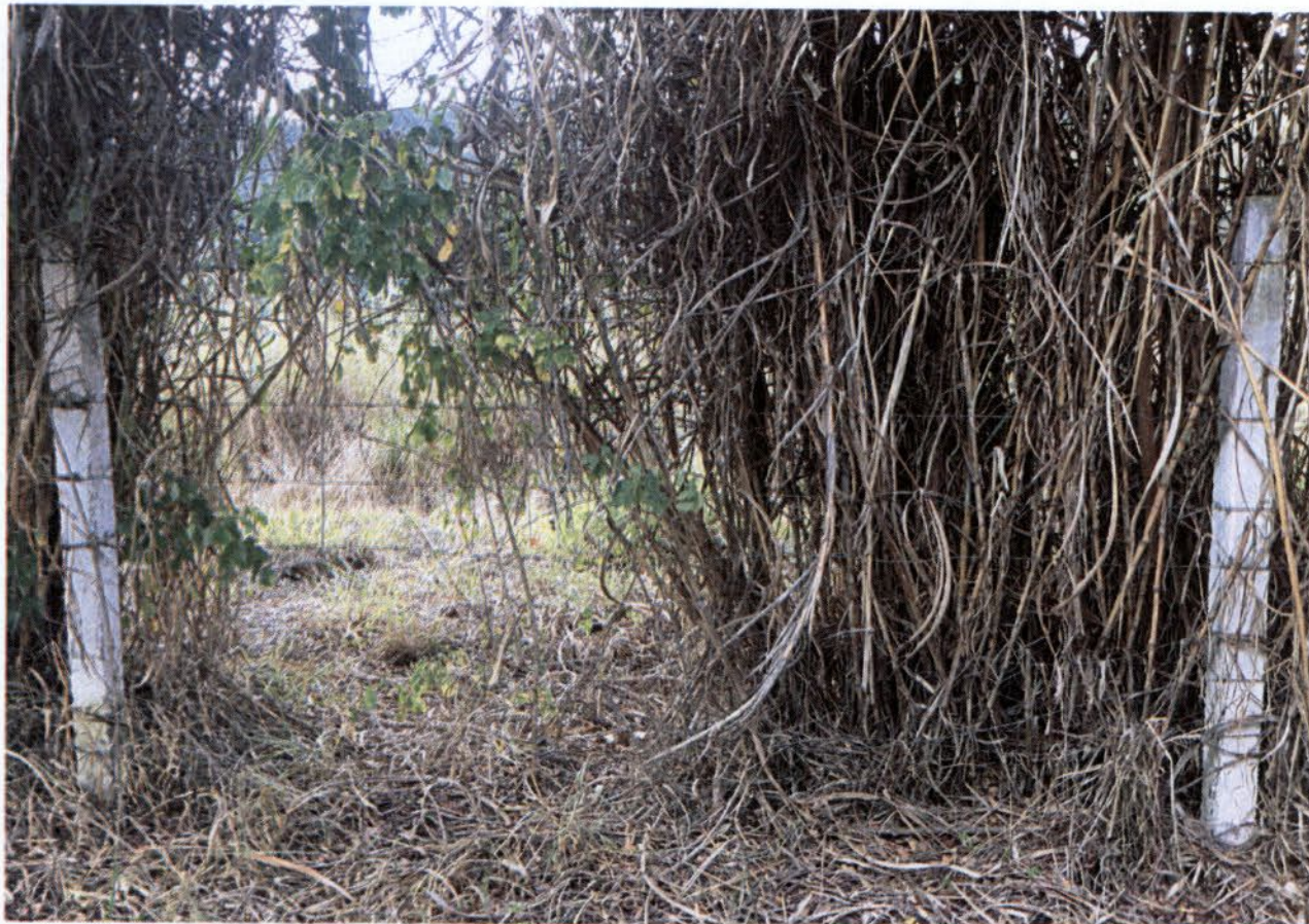
Cerca danificada na área norte da propriedade (Tl 23). Segundo o empreendedor, as avarias nas cercas são constantes.
