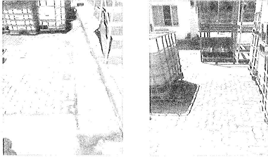
Figura 7 Área dicada construída para contenção de fluoreto de amônio na FCN II – dia: 19/09/2015
