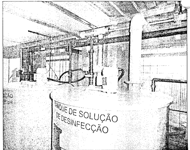
Foto 4- Tanque de Armazenamento de Soluções
