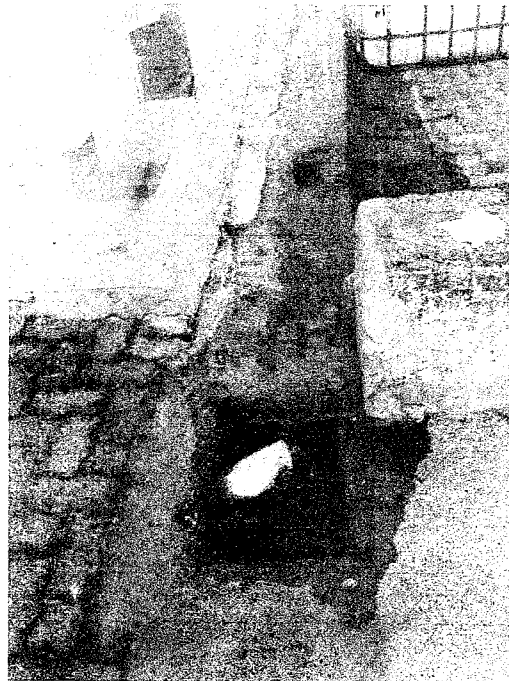
Foto 2 – Tamponamento do bueiro
