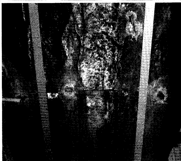
Figura 24 - Solda de reparo de furo no Ciclone
