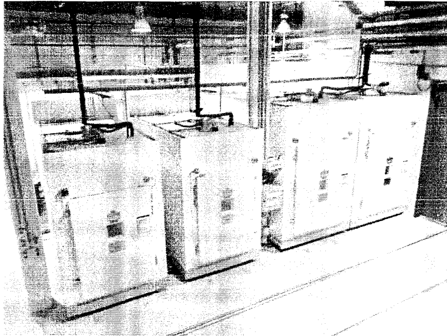
Foto 3: Câmaras Frigoríficas - Sala UFD01-103
