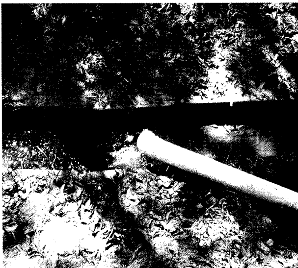
Figura 57 - Canaletas de descarte após Lagoa de Polimento - Duto de descarte de efluentes sanitários da FCN II
