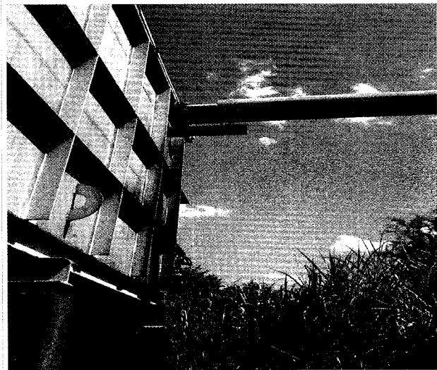
Figura 08 - Dutos de Recebimento e Transferência com Encapsulamento
