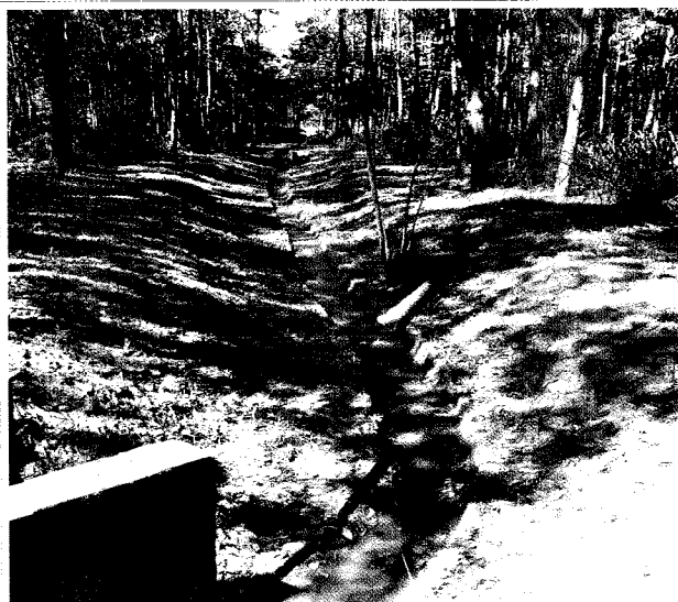
Figura 56 - Canaletas de descarte após Lagoa de Polimento - Duto de descarte de efluentes sanitários da FCN II
