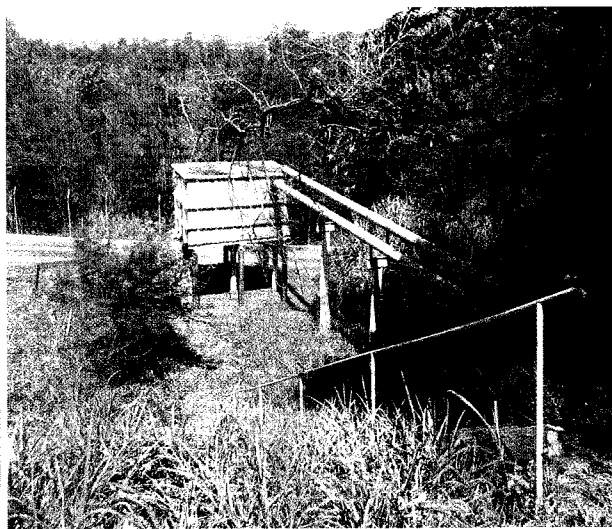
Figura 07 - Caixa de Acumulação - Dutos de Recebimento e Transferência
