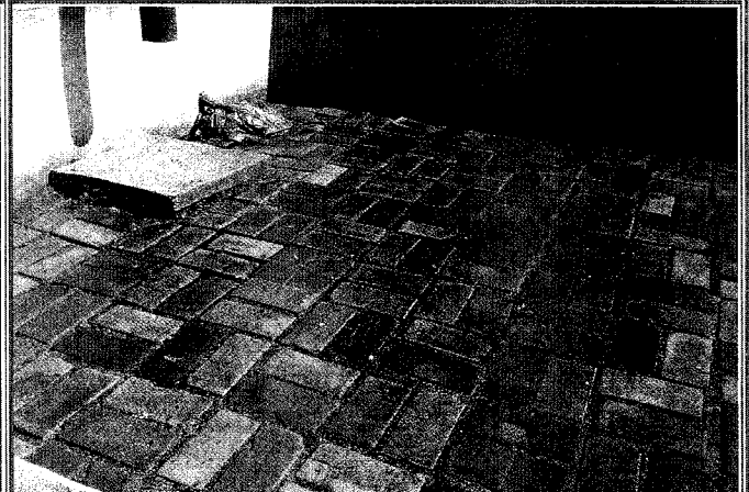
Figura 113: Detalhe do leito de secagem.
