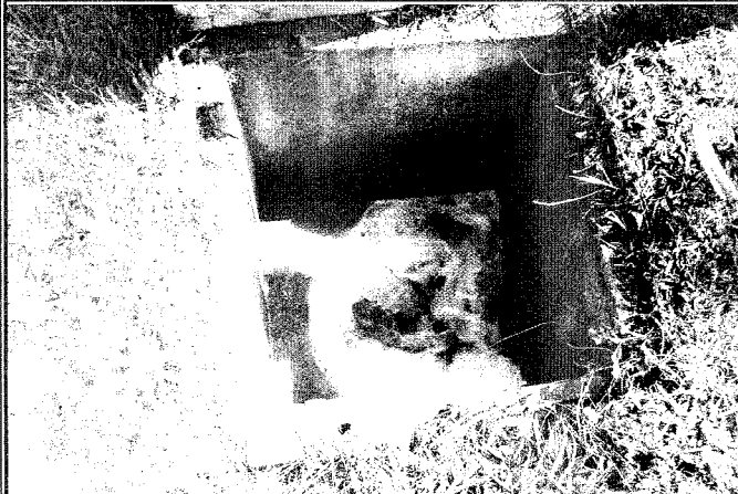
Figura 110: Saída do efluente tratado.
