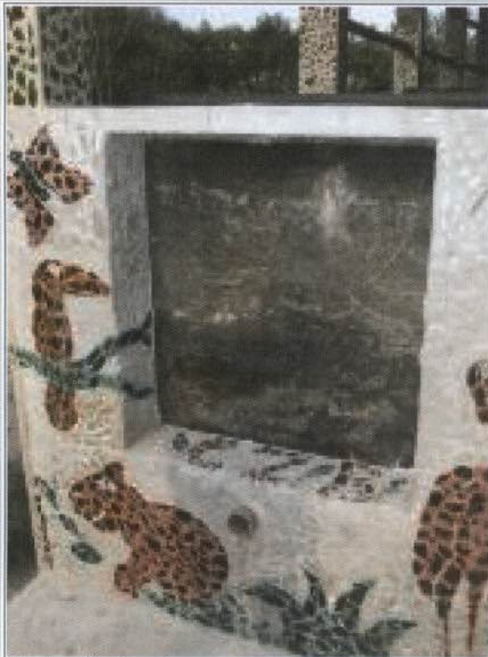
60: Detalhe dos drenos e da visão interna pelo lado de fora.
