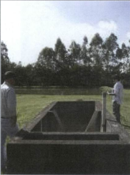
80: Vertedouro (a frente) e lagoa de polimento (ao fundo)
