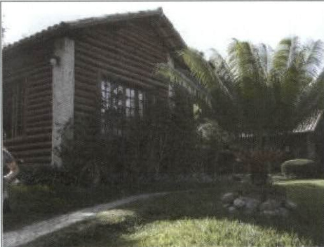
46: Instalações do Centro Zoobotânico
