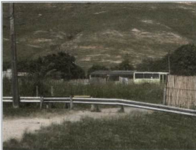
120: Bloqueio de acesso à rodovia
