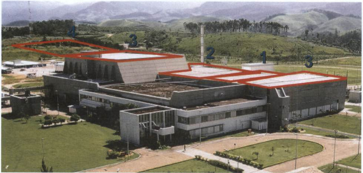
Figura: 4: Prédio 1 (Reconversão de UF6 em UO2); Prédio 2 (Fabricação de Pastilhas) 3 e 4 (Enriquecimento de Urânio). Fonte: INB, 2006.
