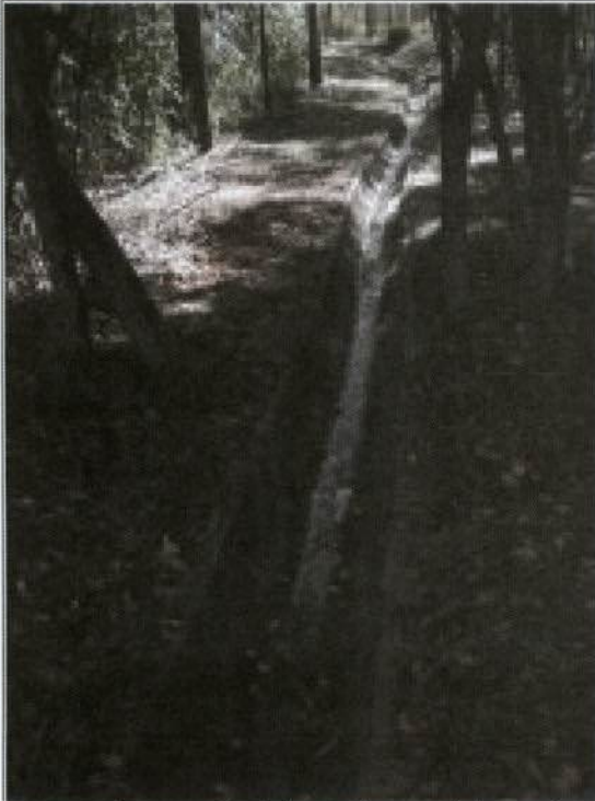
96: Canaletas conduzindo o efluente da lagoa de polimento até o Ribeirão da Água Branca
