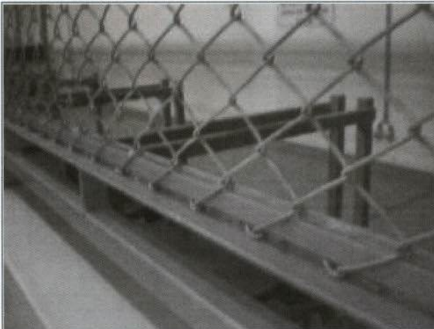
110: Baias preparadas para estocagem de rejeitos
