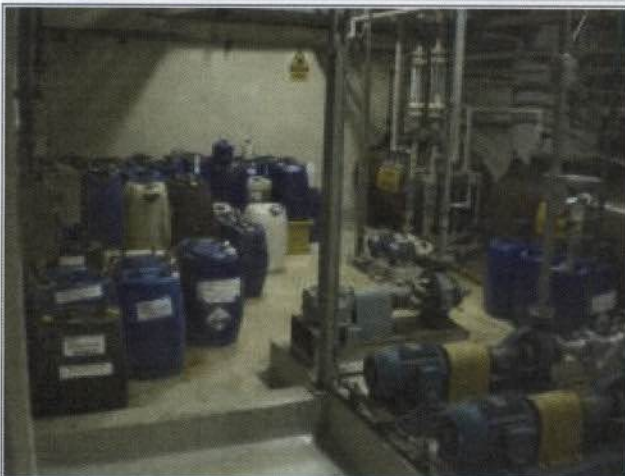
32: Outra visão do dique, ao lado das bombas
