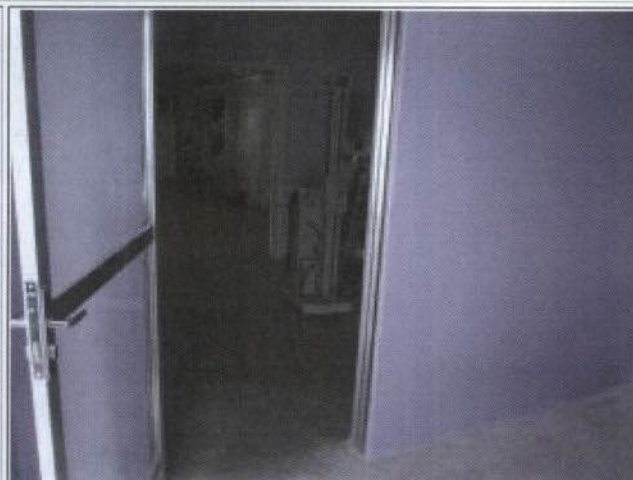
125: Porta de acesso ao interior do hospital
