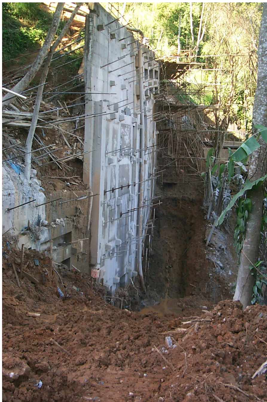
Foto 9 -Início das obras de reforço (julho/2001) mostrando os tirantes de reforço já instalados e os painéis rompidos.
