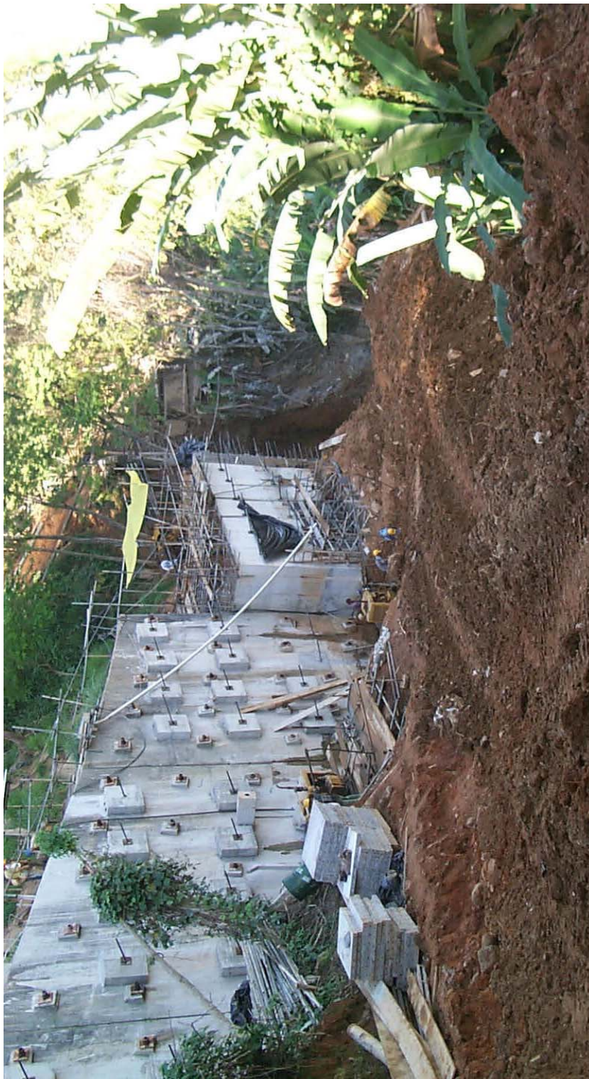
Foto 8 - Execução do reforço da cortina inferior (julho/2001), apresentando os novos tirantes instalados sobre placas de concreto armado quadradas para suportar o esforço de punção.
