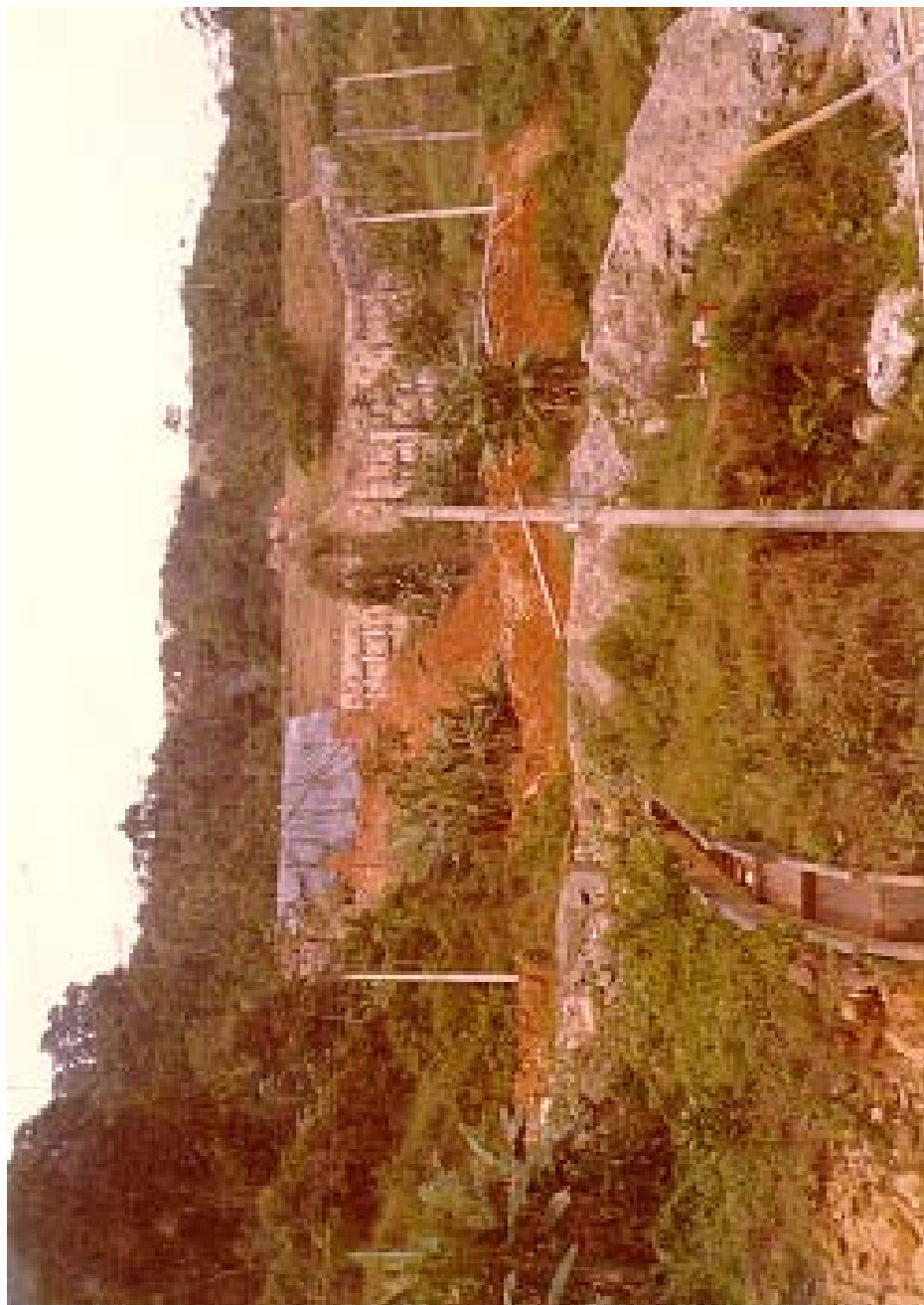
Foto 2 - Foto tirada próximo ao Canal 5, após o deslizamento de janeiro/1979, observa-se que o corpo estradal possuía um talude que atingia o topo da cortina.
