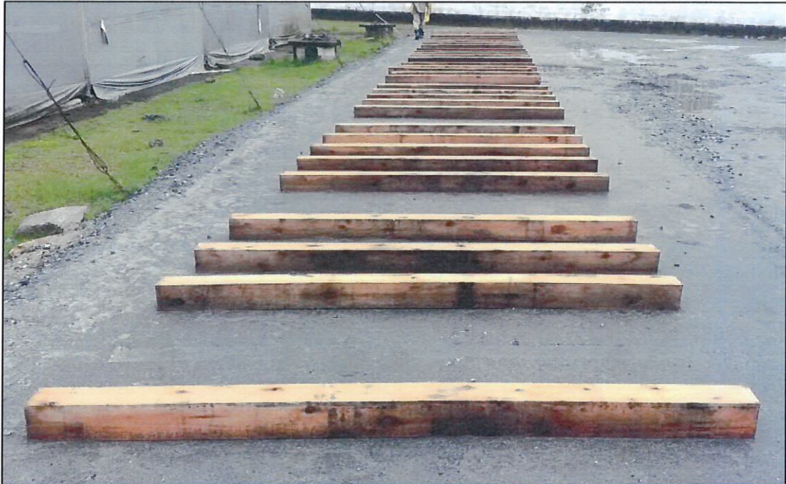
Figura 07: Área preparada para armazenamento das tampas dos tanques Hi Storms.
