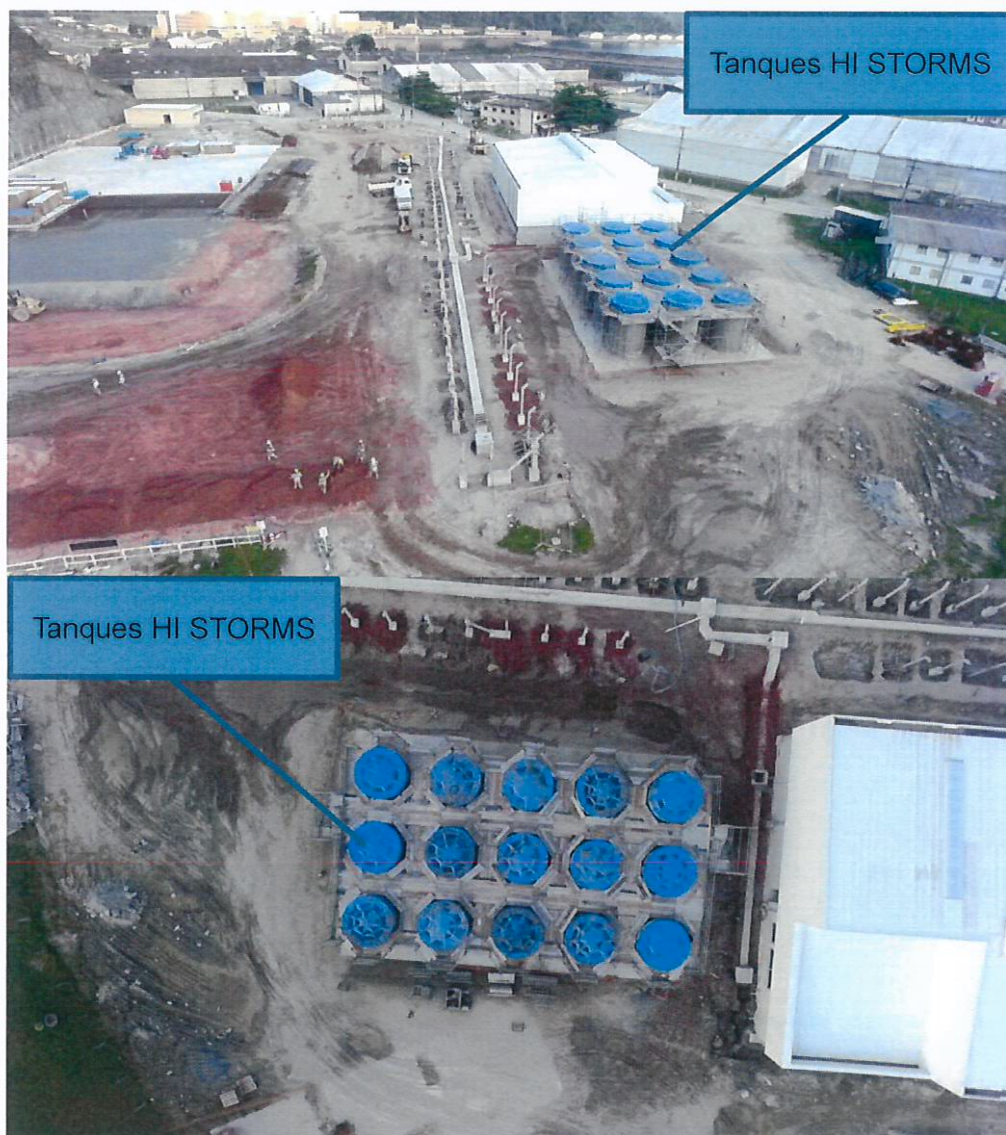
Figura 9: Área de concretagem dos tanques HI STORMS.
