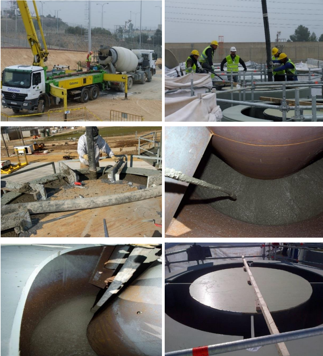
Figura 4 – Conjunto de fotos ilustrativas de uma operação de concretagem de HI-STORMs executado pela Holtec.
