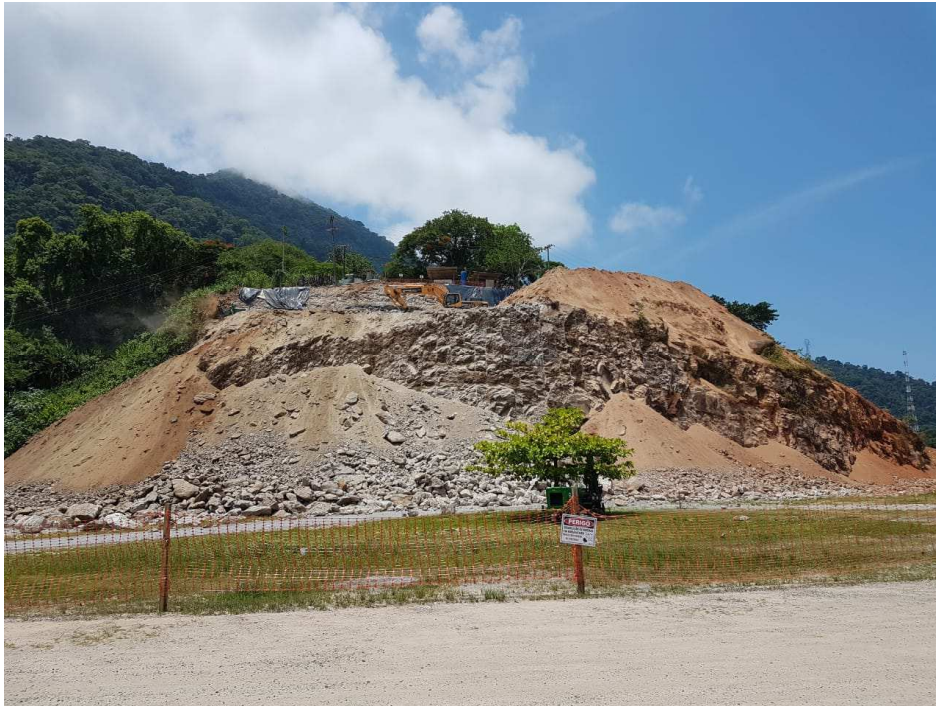
(a) Vista geral das escavações
