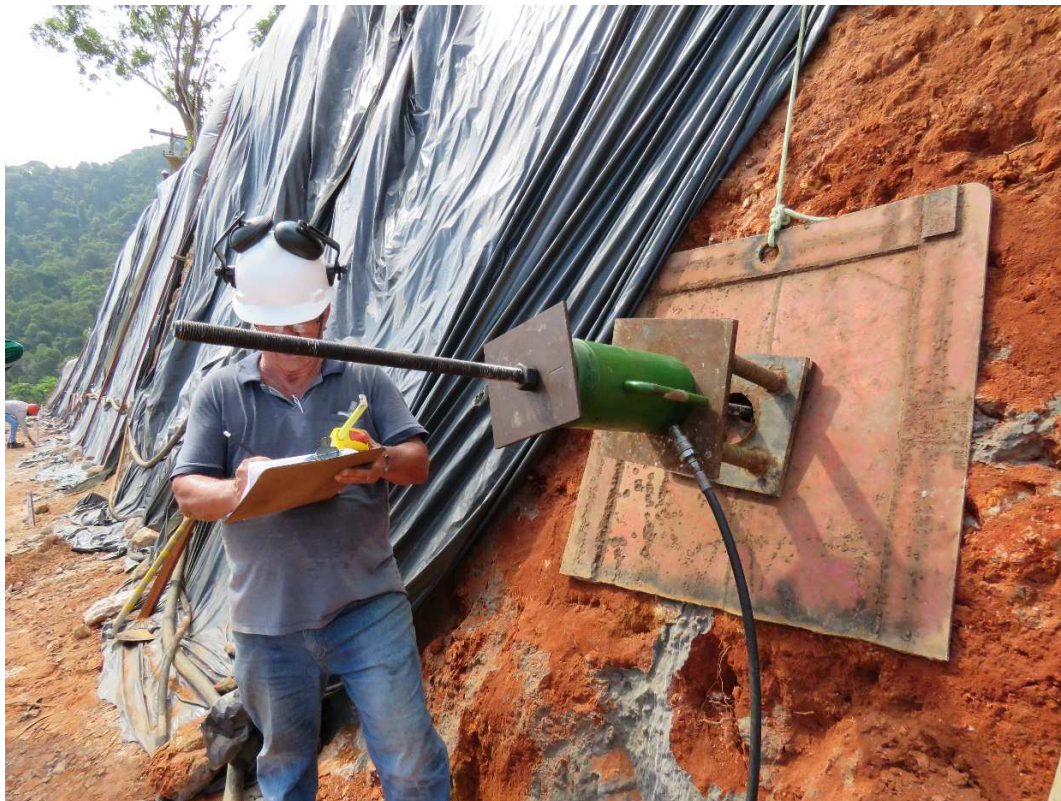
Figura 14. Ensaio de arrancamento – Chumbador 01 em solo residual – Seção 10.
