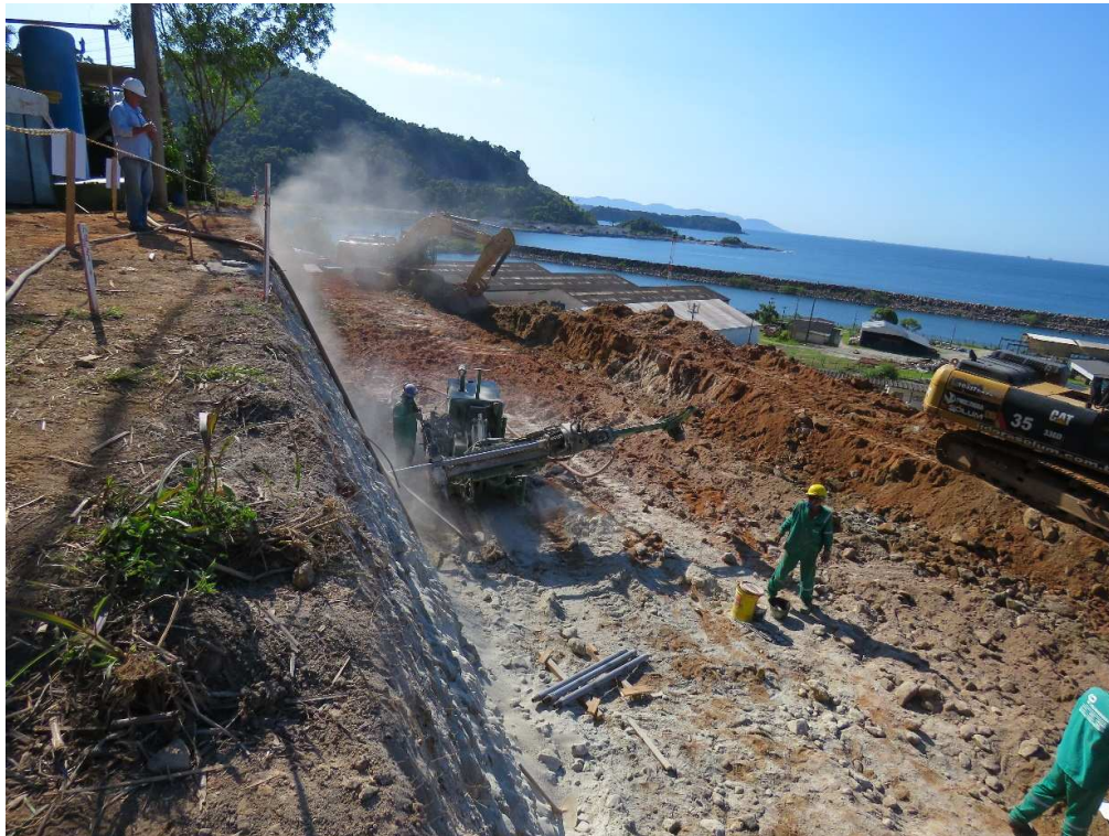
Figura 10. Início das atividades de perfuração dos furos de chumbadores da linha 01 na Seção 06 (10/jan/2019).
