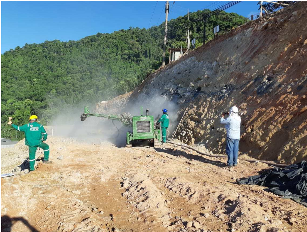
(a) Perfuração dos furos de chumbadores da Linha 02 na Seção 6
