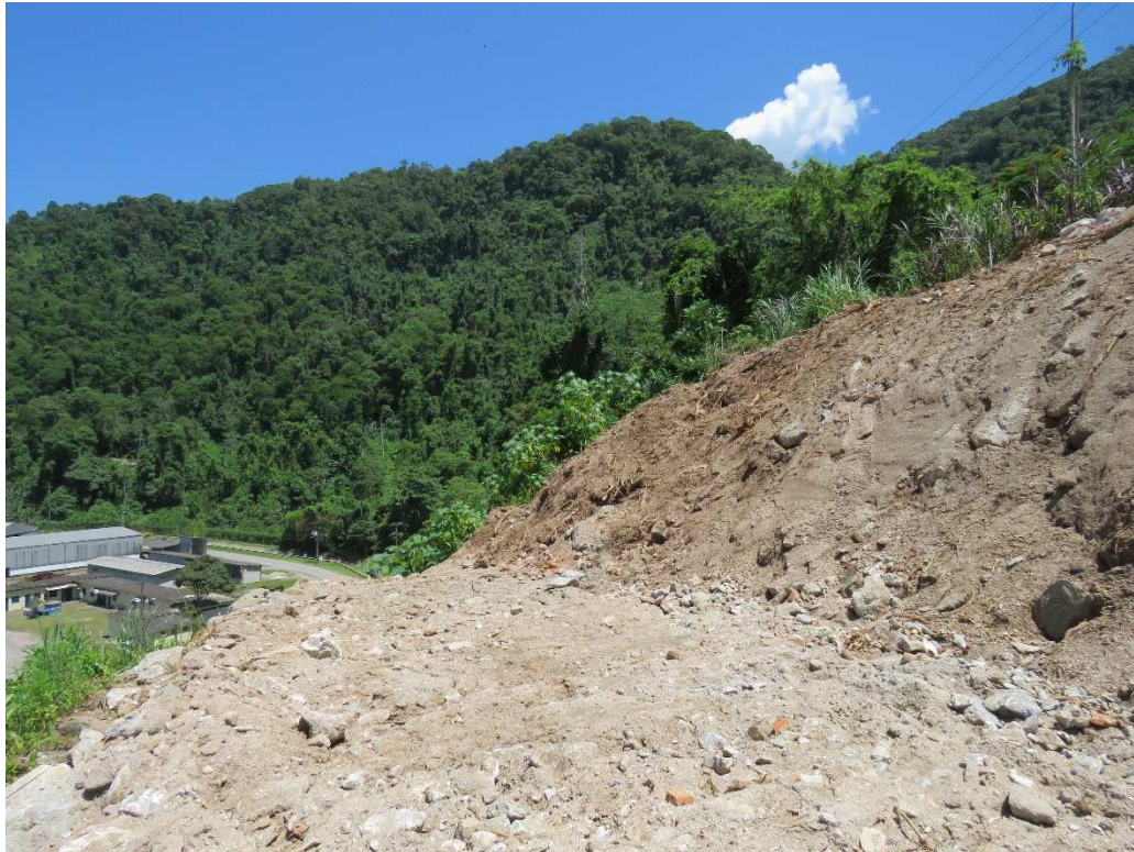
(a) Área da escavação da trincheira
