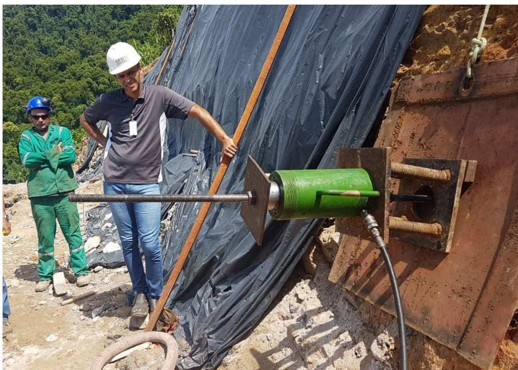
Figura 15. Ensaio de arrancamento – Chumbador 02 em rocha muito alterada – Seção 2.
