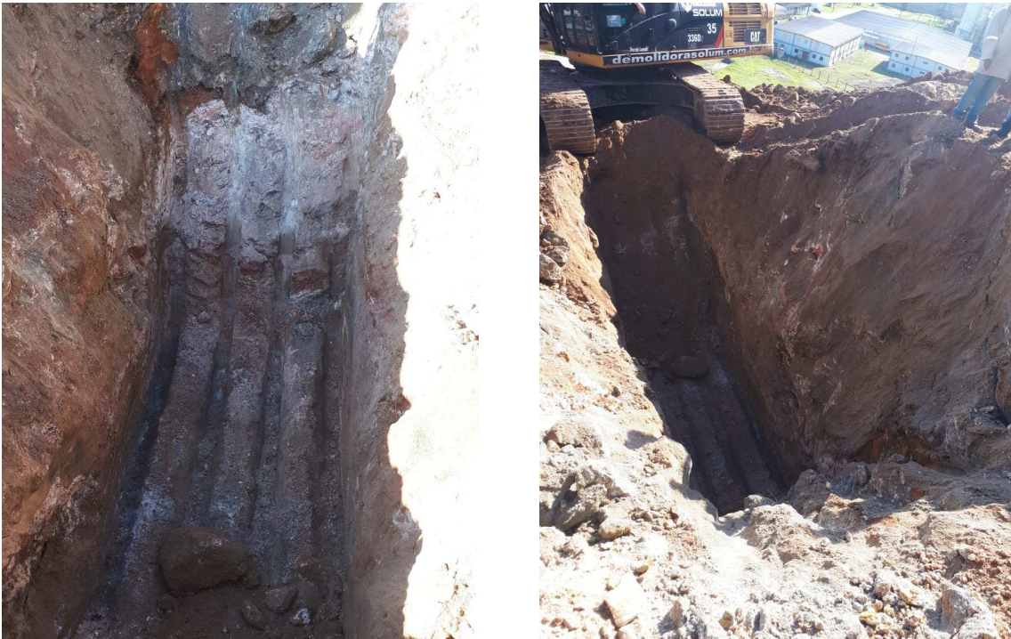
(b) Rocha alterada e saprólito com blocos de rocha
