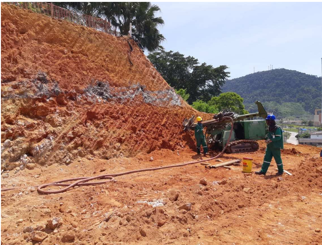
(b) Perfuração dos furos de chumbadores na Seção 11
