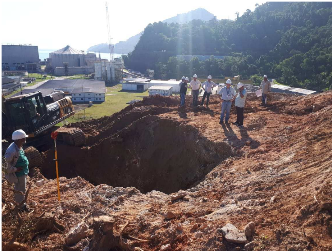
(a) Lateral da trincheira com solo residual e alteração de rocha
