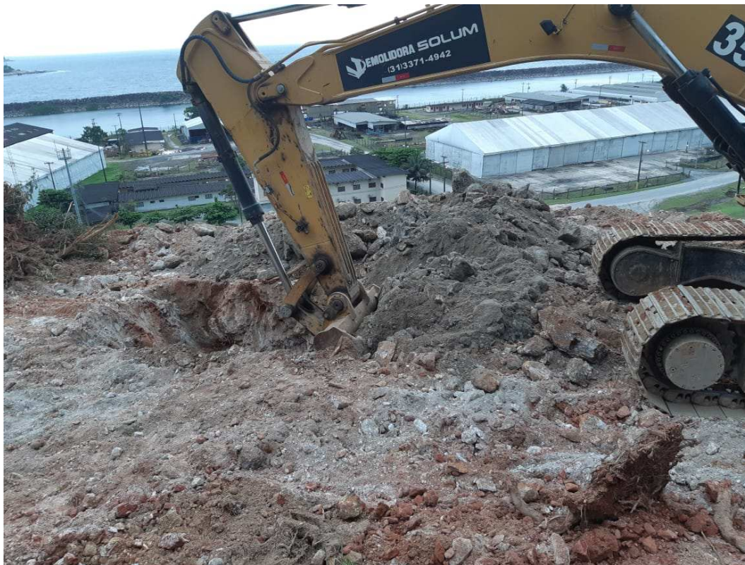
(a) Escavação da trincheira
