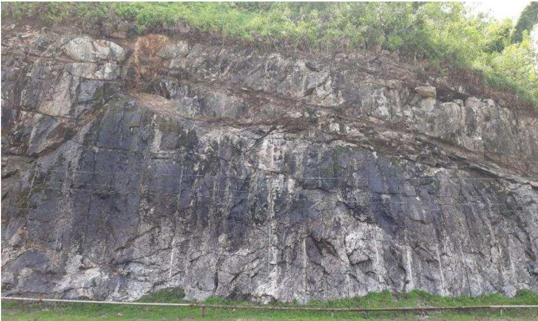
Figura 2.14. Talude rochoso após limpeza da superfície, com realce das juntas intemperizadas em 2017.
