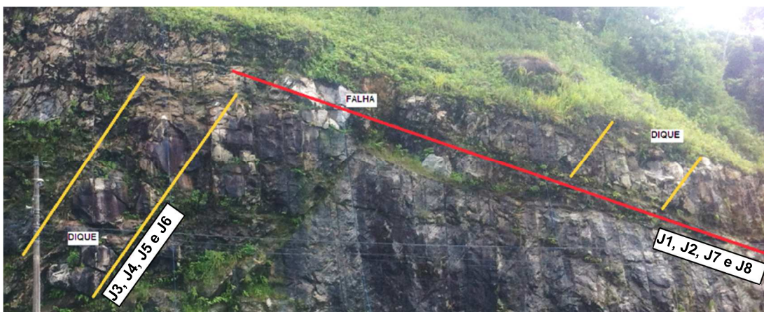
Figura 2.5. Presença da falha normal e dique de granito deslocado de 11m pela ação da falha (BP-U-6501-170003, 2013).
