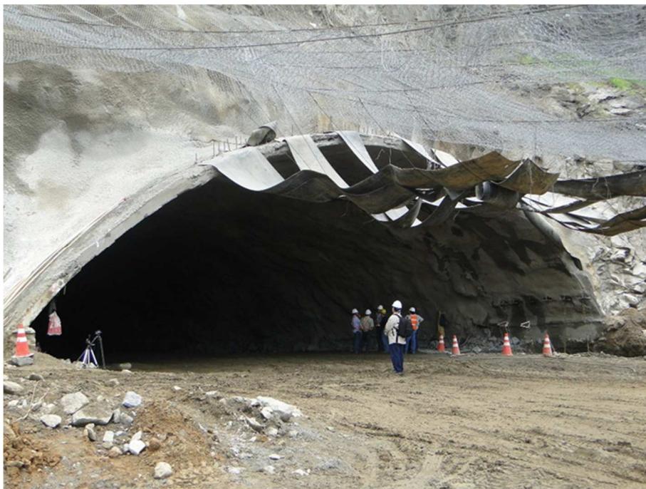
Figura 3.2. Cobertura com tela metálica de alta resistência e painéis de borracha no emboque do Túnel Porto Sudeste.
