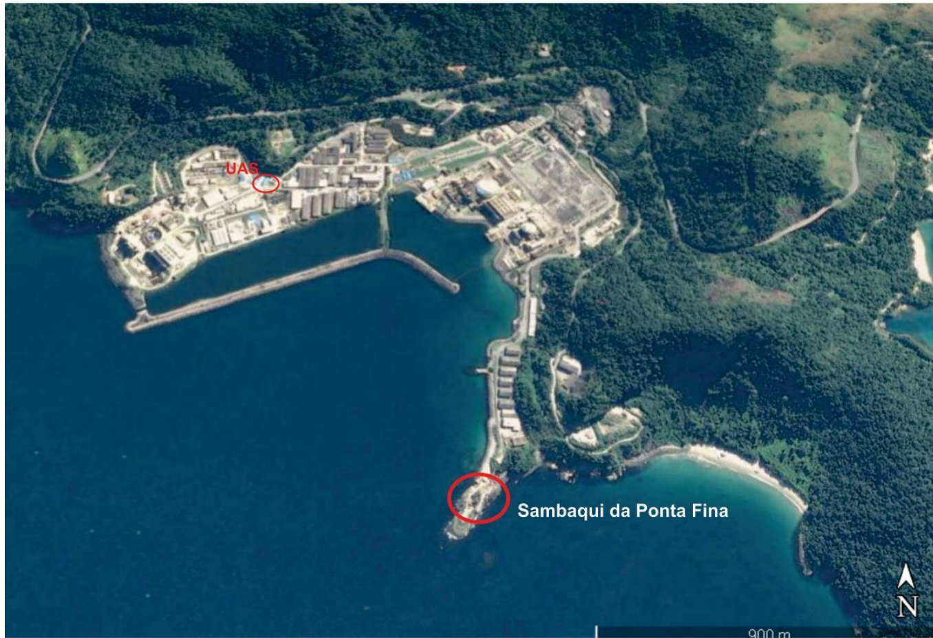
Figura 1- Visão geral da Central Nuclear Almirante Álvaro Alberto (CNAAA) com destaque para a Ponta Fina e a área da Unidade de Armazenamento a Seco.
