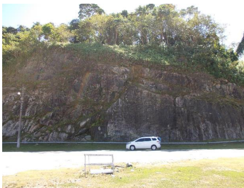
Figura 8 – Visão inferior do talude.
