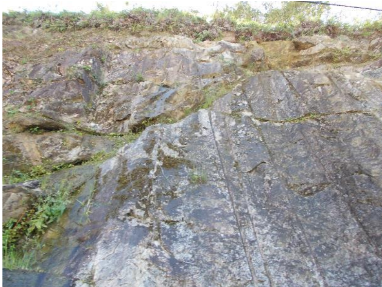
Figura 6 – Visão inferior do talude.
