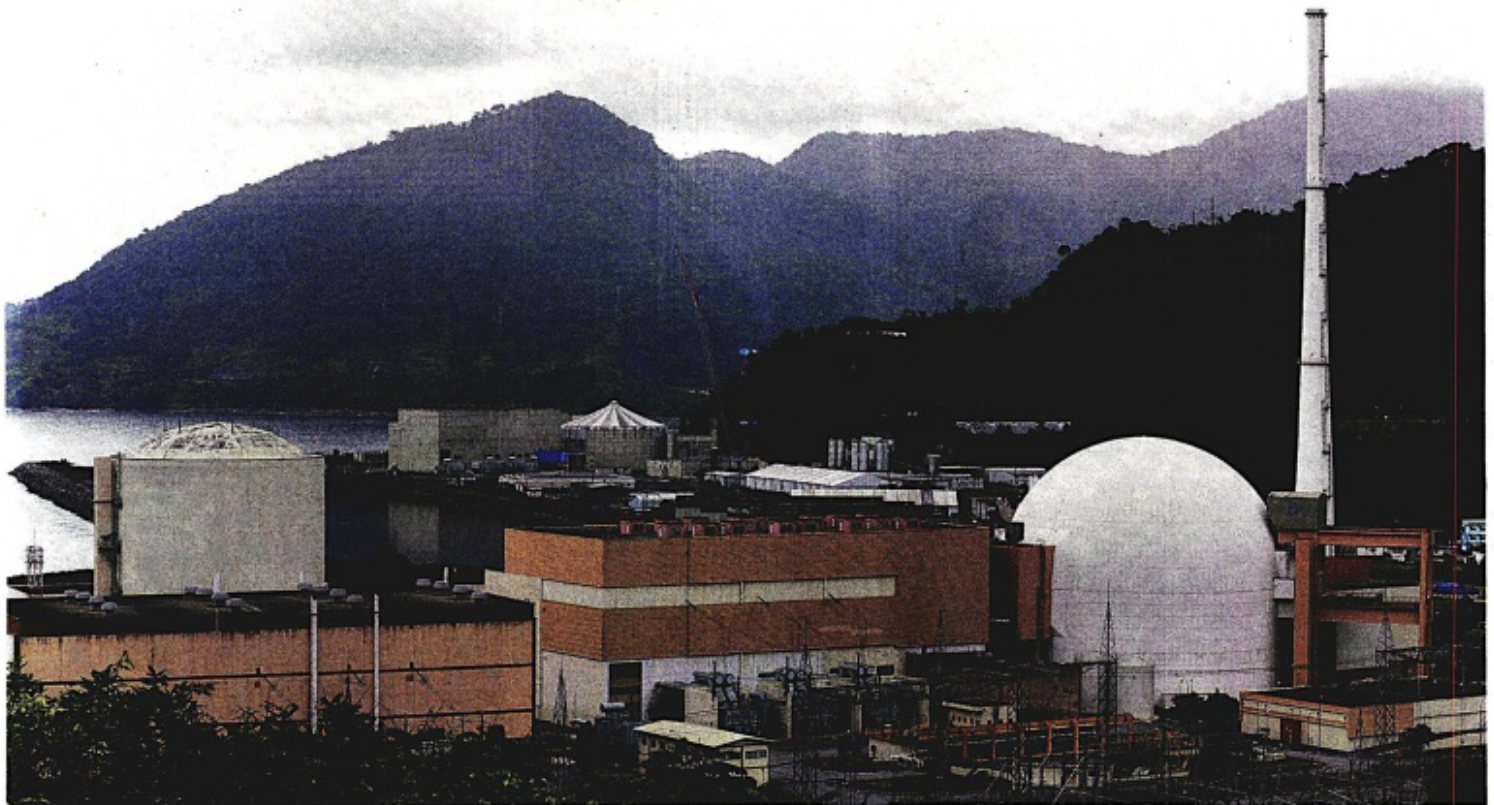
Em operação. Parte do complexo nuclear de Angra dos Reis: obra da chamada Unidade de Armazenamento Complementar a Seco já foi licitada. Especialista aprova o modelo, mas chama a atenção para a importância dos licenciamentos
