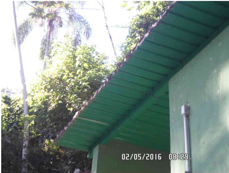
Figura 4.2 – Detalhe do telhado do abrigo da ESAR
