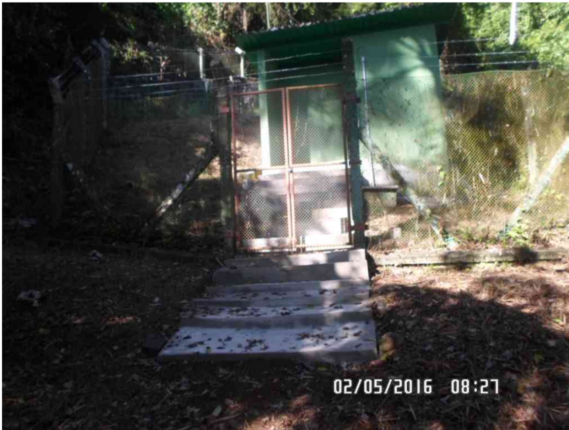
Figura 4.1 – Entrada do abrigo da ESAR
