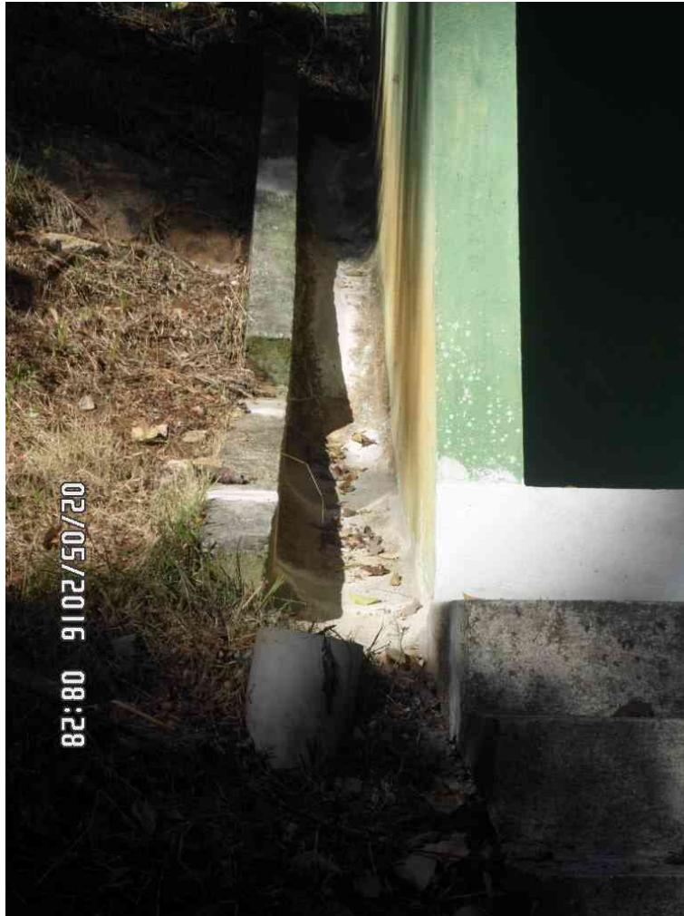
Figura 4.4 – Detalhe da canaleta de drenagem de água superficial no entorno do abrigo da ESAR
