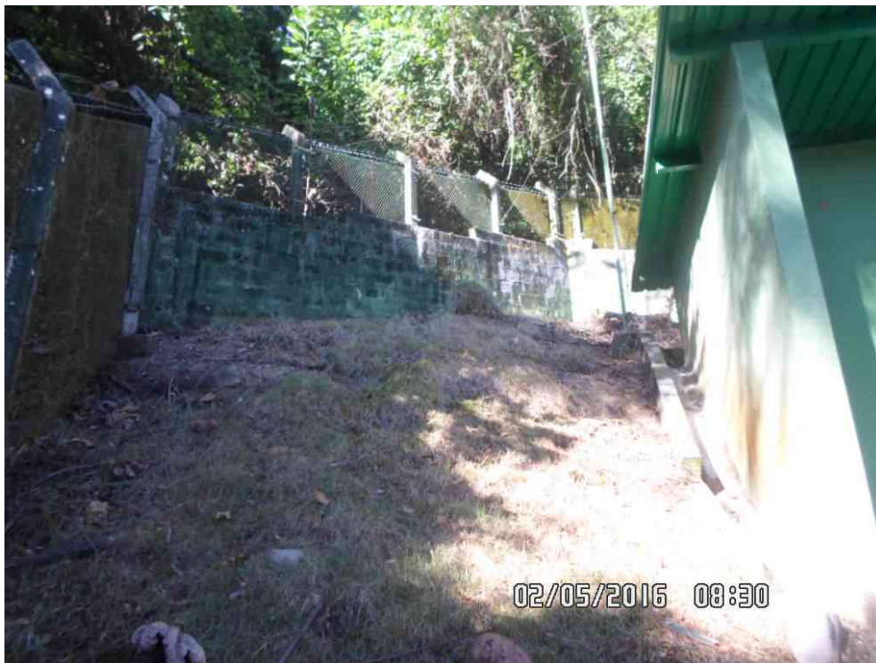
Figura 4.3 – Detalhe do muro que cerca o abrigo da ESAR
