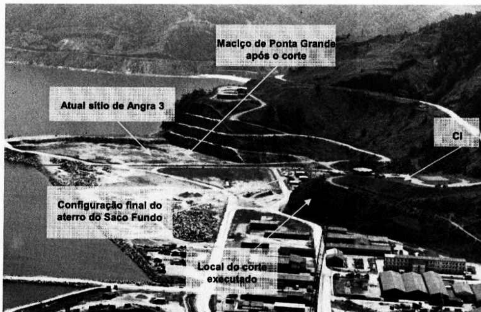
Figura 6.3 - Vista do CI com o corte executado e a configuração final do aterro da região do Saco Fundo, interligando o sítio de Angra 3 (aproximadamente a configuração atual).
