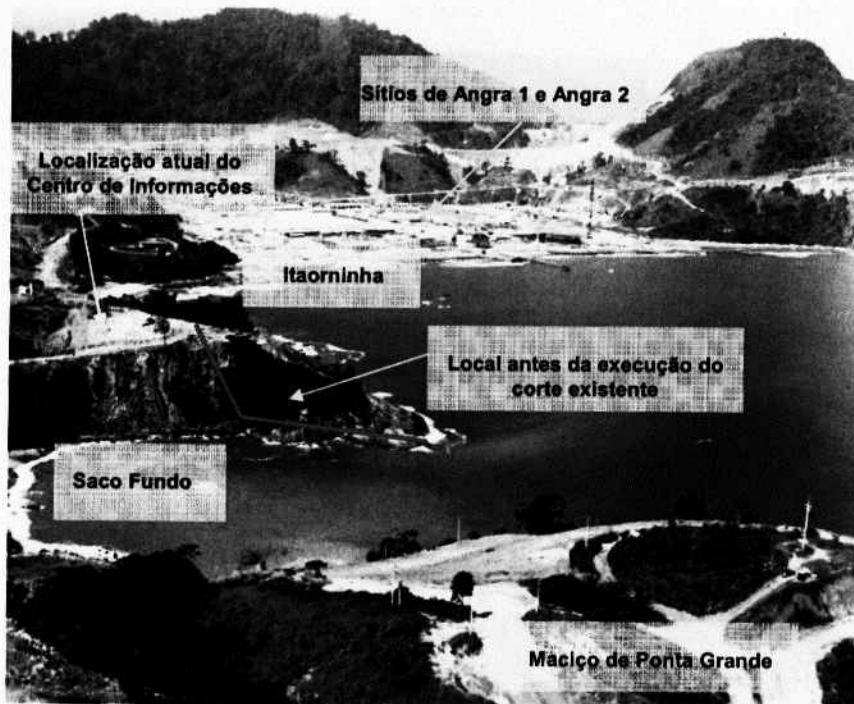
Figura 6.1 - Vista do sítio de Angra 1 e Angra 2, da região do Saco Fundo, antes do corte e do aterro, e do maciço de Ponta Grande antes do corte (1974).
