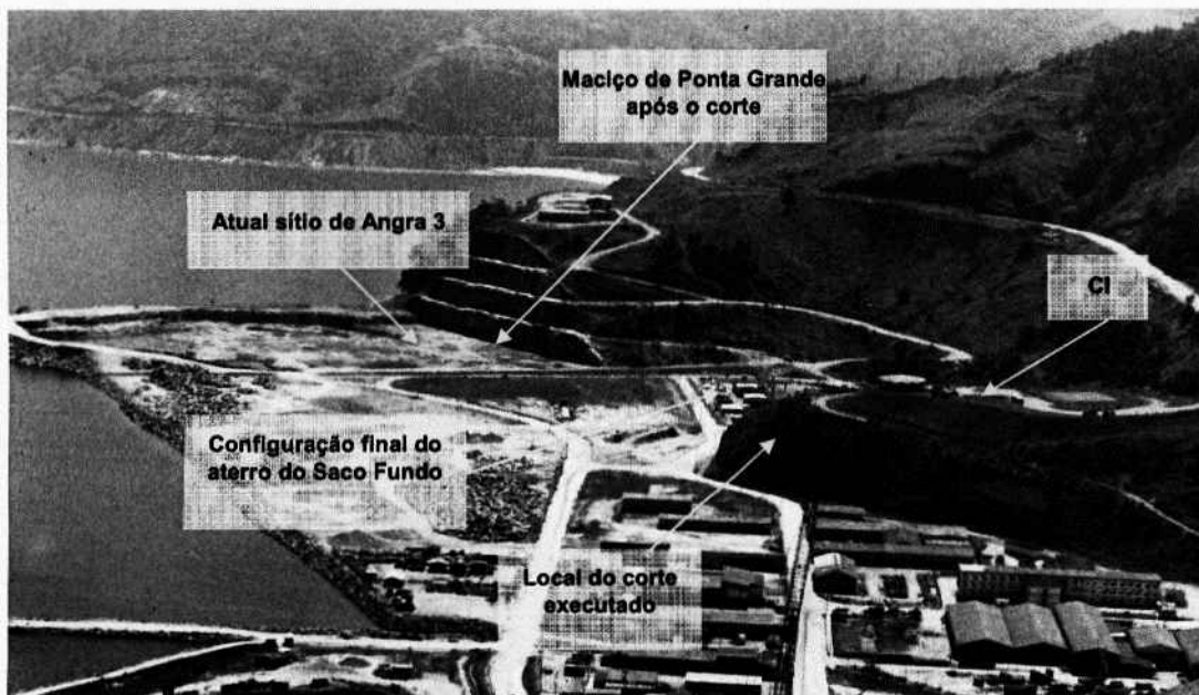
Figura 3 - Vista do CI com o corte executado e a configuração final do aterro da região do Saco Fundo, interligando o sítio de Angra 3 (aproximadamente a configuração atual).
