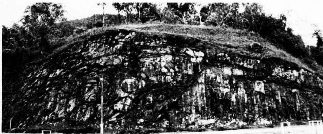
Figura 4 – Paredão rochoso após limpeza parcial em 2012.
