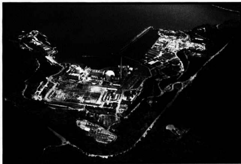
Figura 1: Imagem aérea da CNAEA. Angra dos Reis - RJ. (fonte: Eletronuclear, 2016)
