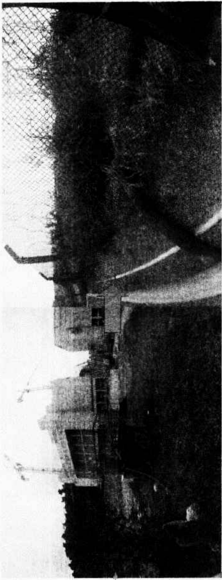
Figura A45: Caixa d'água utilizada para decantação da água bombeada na drenagem ilustrada na figura A33, e encaminhamento do efluente para Itaorna. Procedimento adequado.
