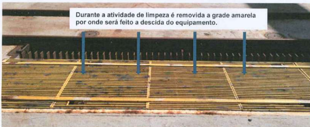
Foto 5 - Local de descida do equipamento Limpa Grades na grade fixa
