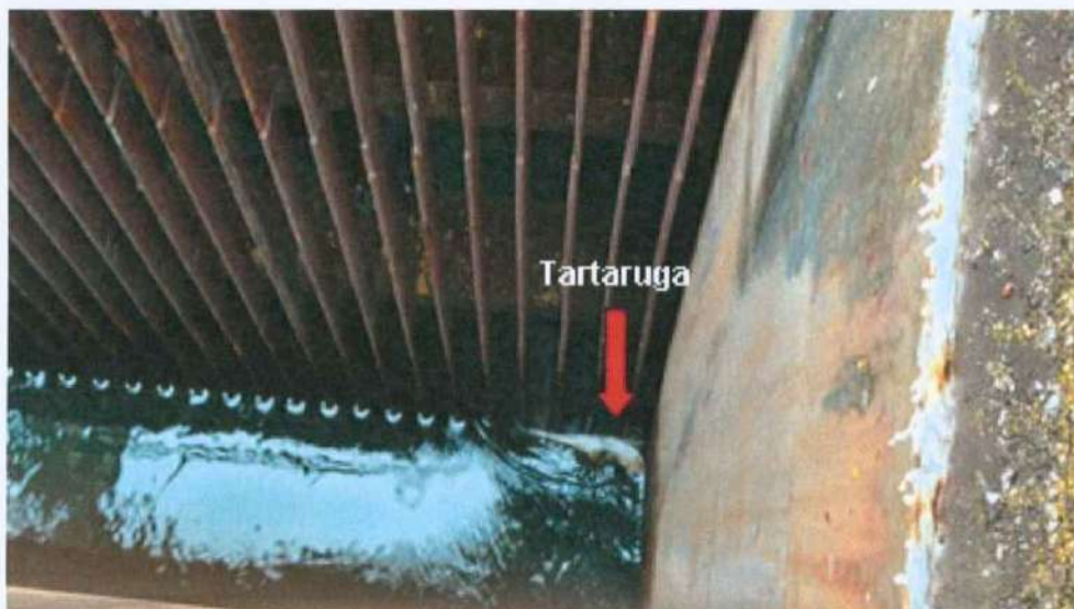
Foto 2- Local onde foi identificada a tartaruga e realizado o seu resgate, na grade fixa da tomada d' água de Angra 1.
