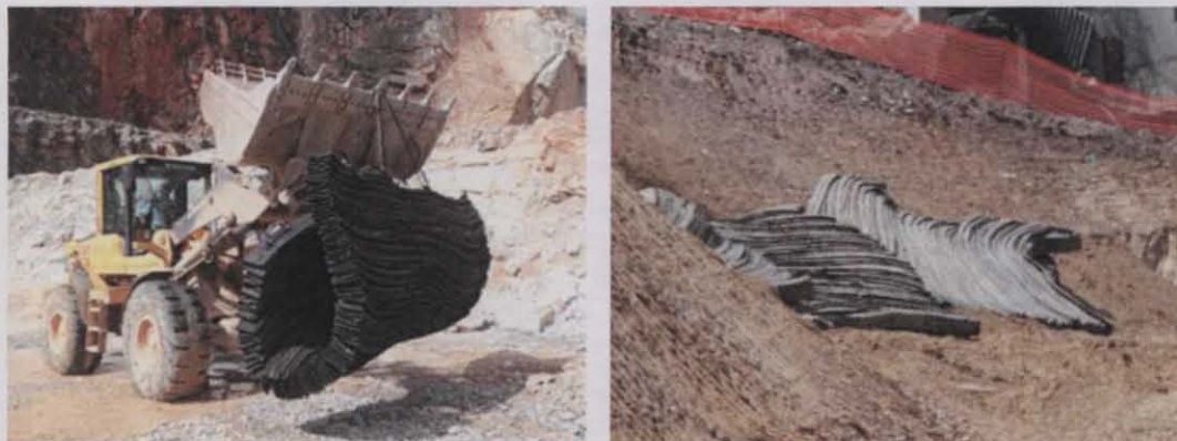
Figura 3.4. Cobertura com mantas de borracha amarradas para formação da rede do tipo Blasmat.
