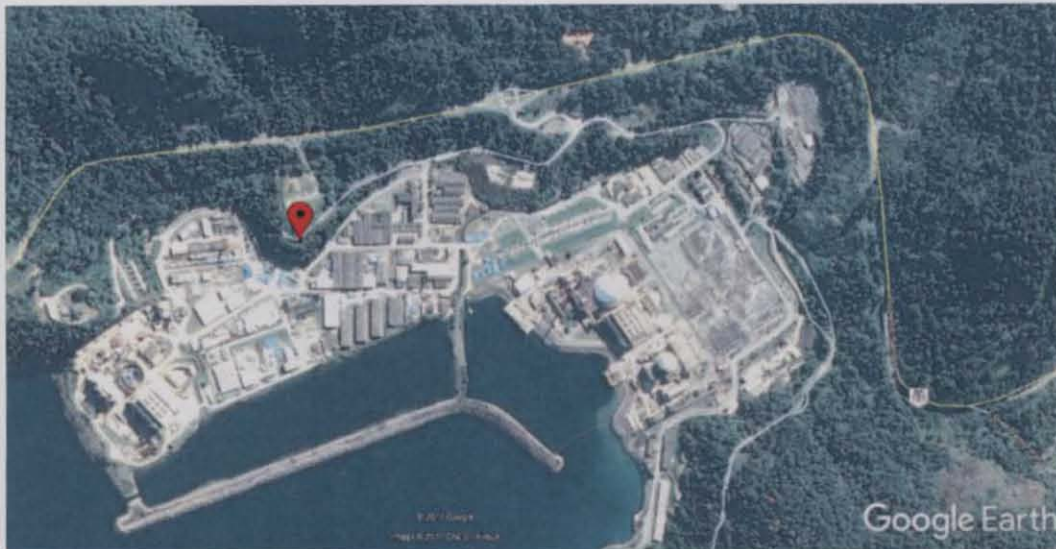
Figura 2.1. Área do talude em imagem de satélite (Google Earth).
