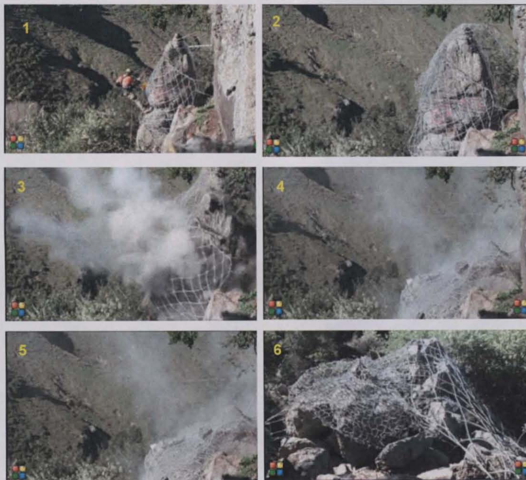
Figura 3.3. Sequência de imagens de desmonte a fogo de bloco com cobertura de painel de alta absorção de energia do tipo HEA na Nova Zelândia.
