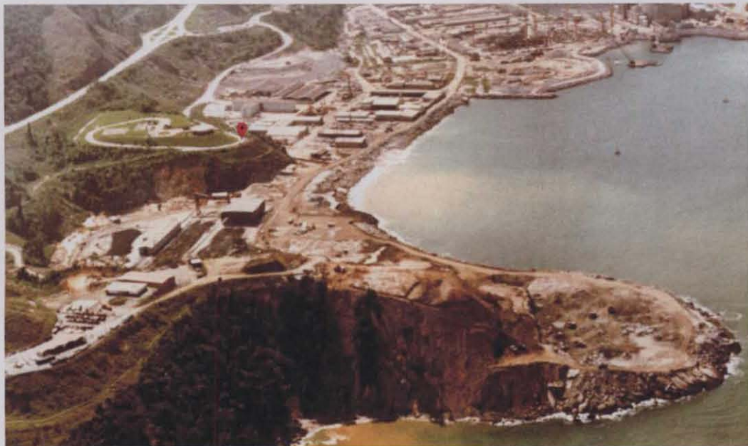
Figura 2.11. Pedra de Itaorninha retaludada com Centro de Informações e aterro parcial em 1981.
