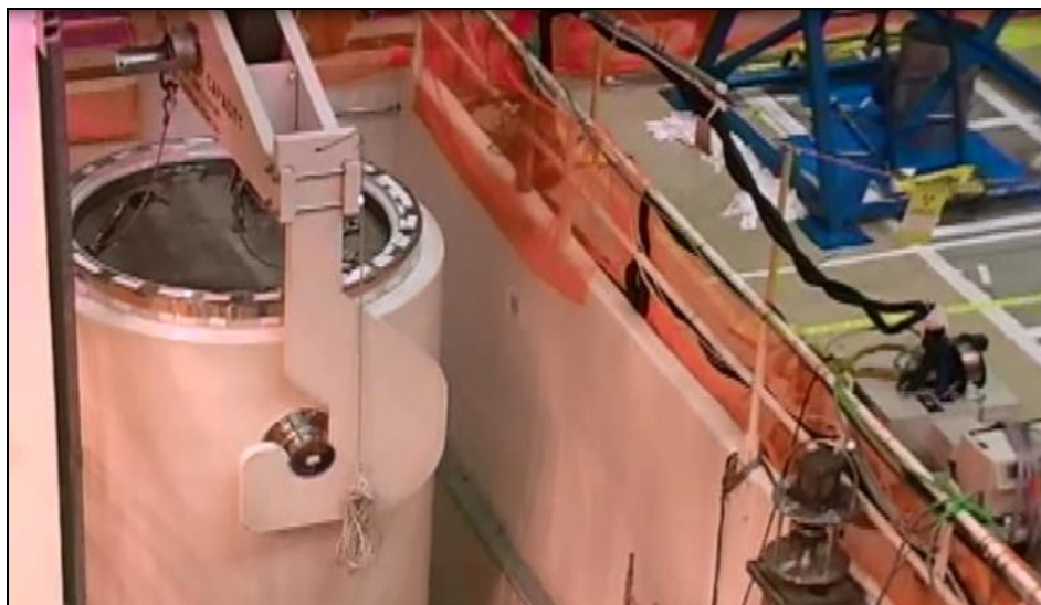
Figura 4-28 - Área de trabalho para operação de soldagem.
