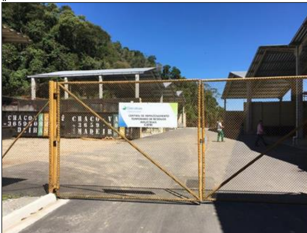
Figura 4-86 – Central de Armazenamento Temporário de Resíduos Industriais (CATRI) da CNAAA.
