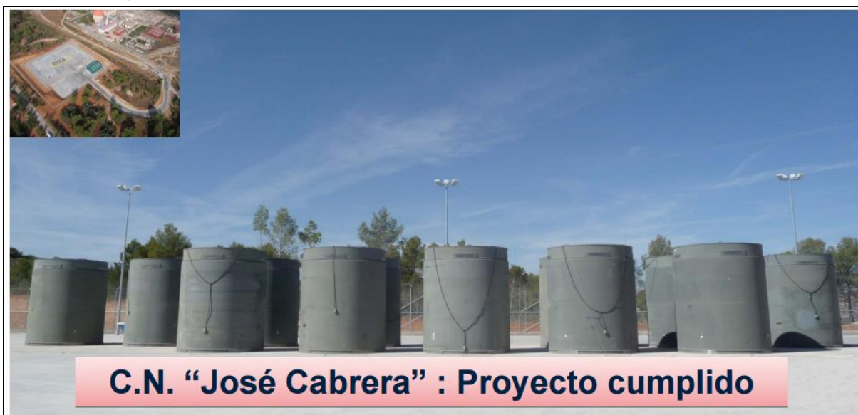
Figura 4-10 - Módulos de Armazenamento a seco de ECIs na Central Nuclear José Cabrera, Espanha.
