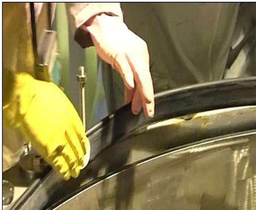
Figura 2-21 - Instalação do anel de vedação
