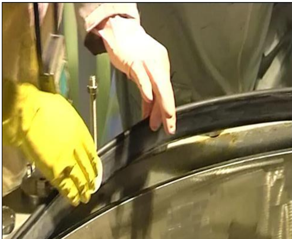
Figura 4-41 - Instalação do anel de vedação.
