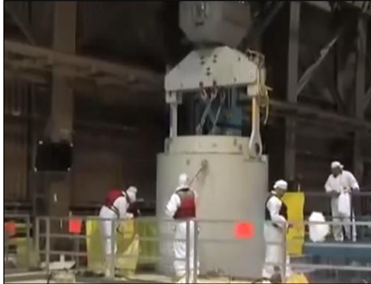
Figura 2-26 - Lavagem e secagem do Casco de Transferência.
