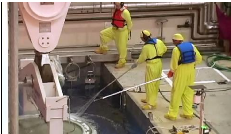
Figura 4-27 - Lavagem e descontaminação do casco.
