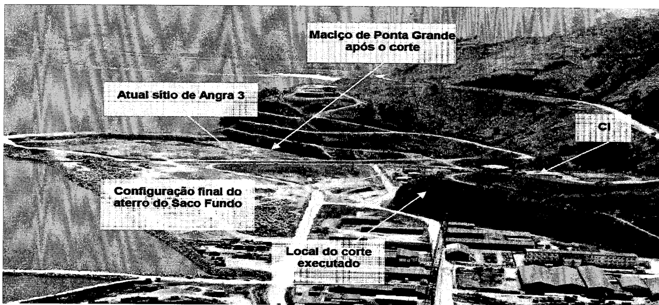
Figura 2. Foto da CNAAA na década de 70, após o primeiro desmonte de talude. Fonte: ETN.
