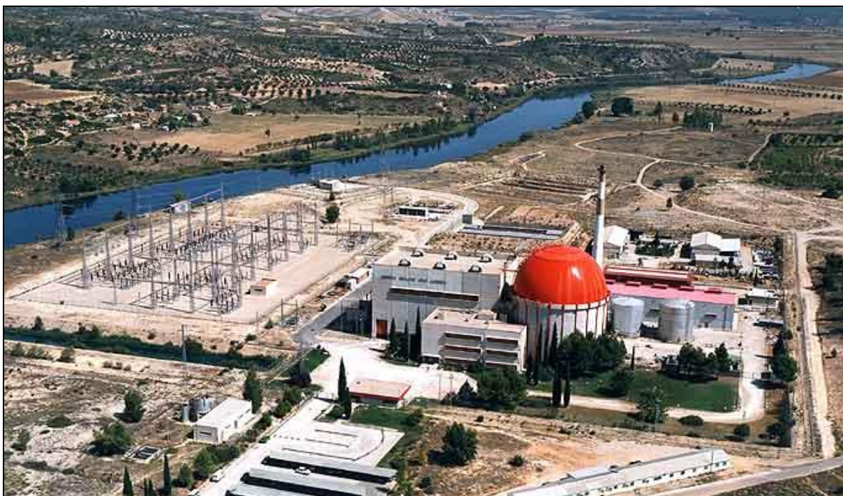
Figura 4-9 - Central Nuclear de José Cabrera, Espanha.
