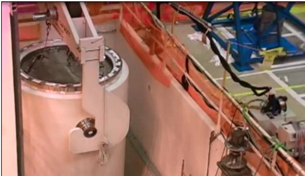
Figura 2-8 - Área de trabalho para operação de soldagem.
