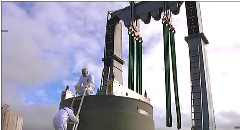
Figura 4-62 - Dispositivos de içamento do casco
