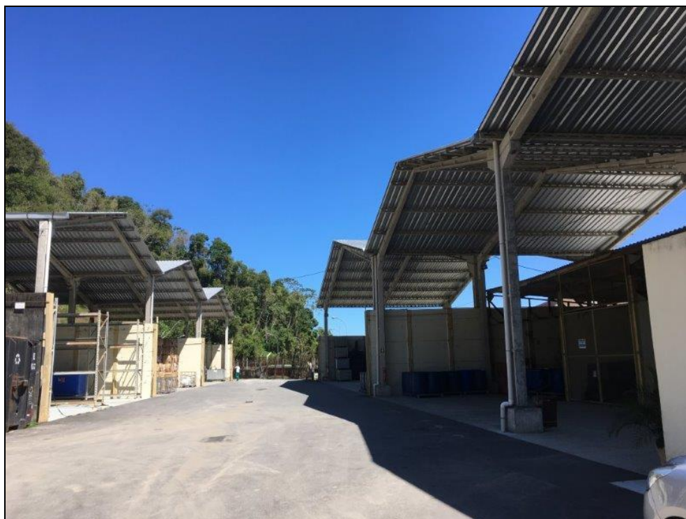
Figura 4-87 - Central de Armazenamento Temporário de Resíduos Industriais (CATRI) da CNAAA.
