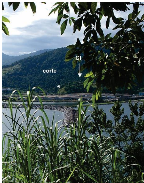
Figura 7 – Vista da área da UAS e o corte do talude.
