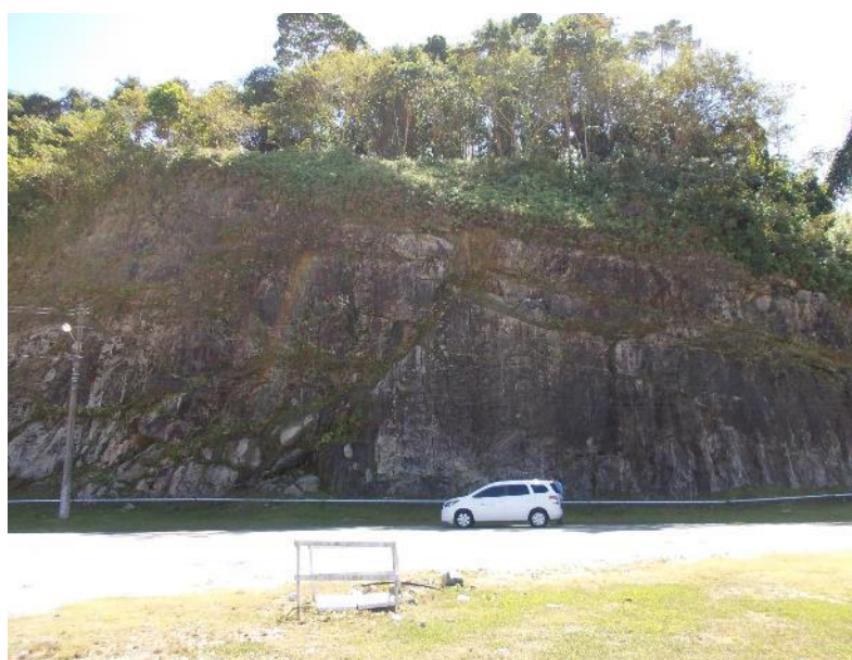
Figura 8 – Visão inferior do talude.
