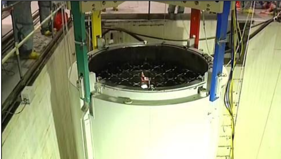
Figura 4-40 - Conjunto sendo imerso na piscina.
