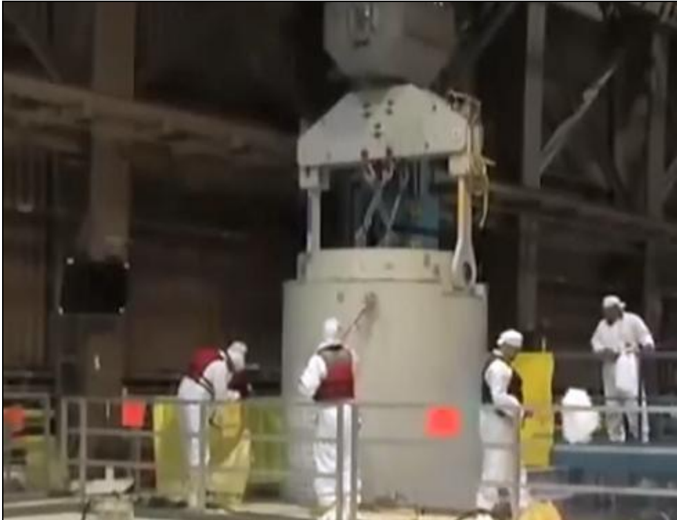
Figura 4-46 - Lavagem e secagem do Casco de Transferência.
