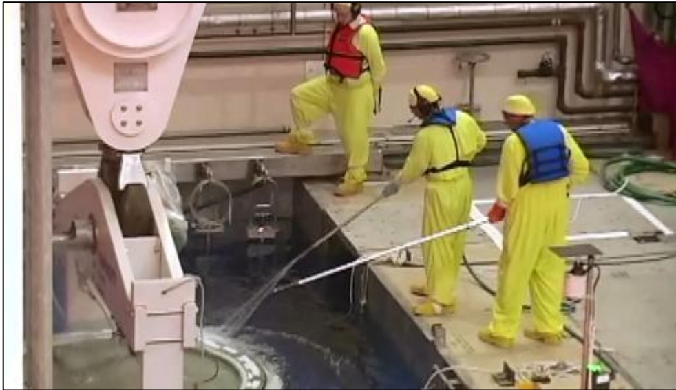
Figura 2-7 - Lavagem e descontaminação do casco
