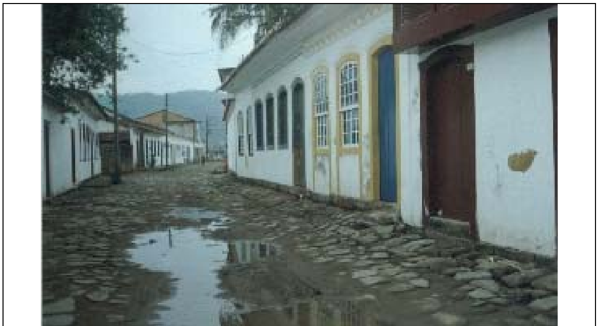
Figura 52 – Foto de conjunto arquitetônico e paisagístico de Parati. Atualmente a falta de investimentos impede a recuperação e a manutenção do patrimônio histórico e cultural existente, Parati - RJ. Fonte: “Análise do ambiente socioeconômico da área de influência da CNAAB”, Science.
